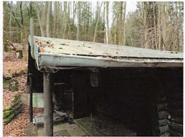
Zinkblechrinnen, Abdichtung mit Bitumenbahnen
