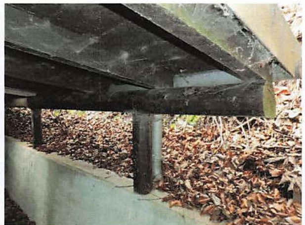
Stützmauer aus Ort beton
