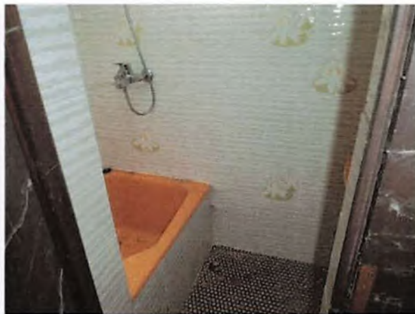
ehem. Dusche - außer Betrieb
