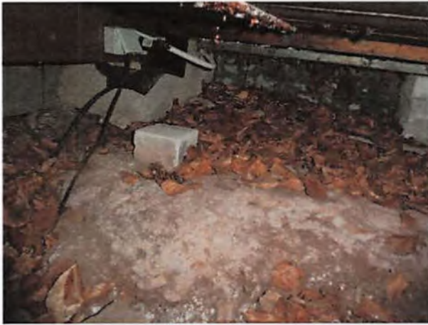
Betonfundamente
