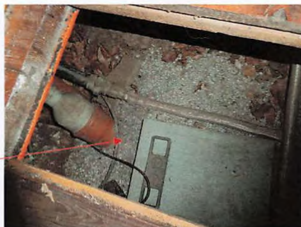
Blick unter den Dielenboden, Verrohrung
