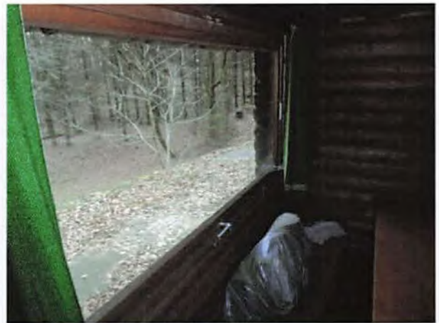
Holzrahmenfenster mit Einfachverglasung
