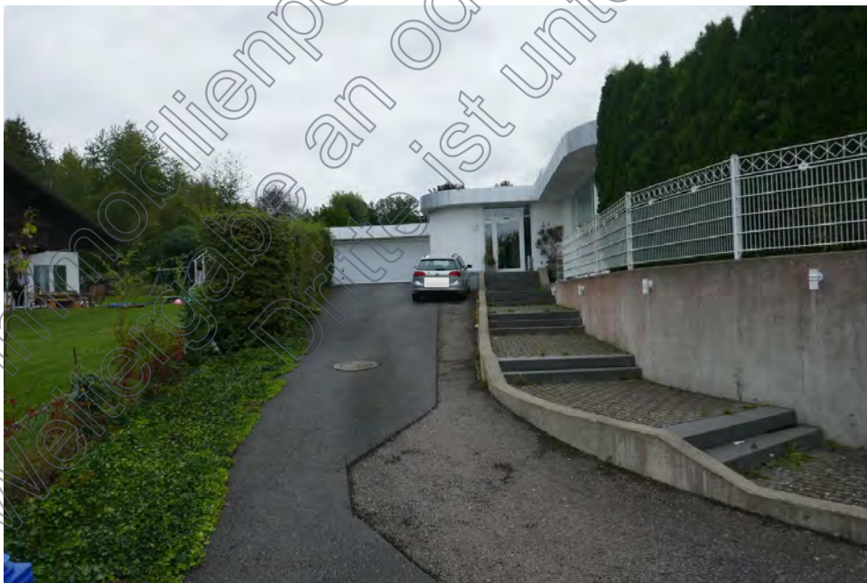
Bild 4: Hofansicht mit Hauseingang und Garage
