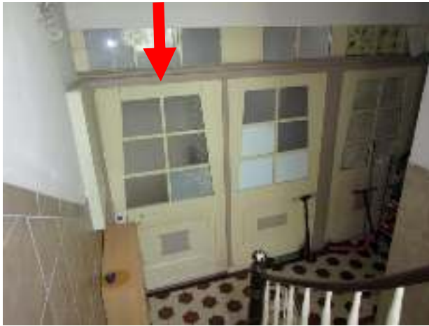
Abschlussstür der Wohnung Nr. 3
