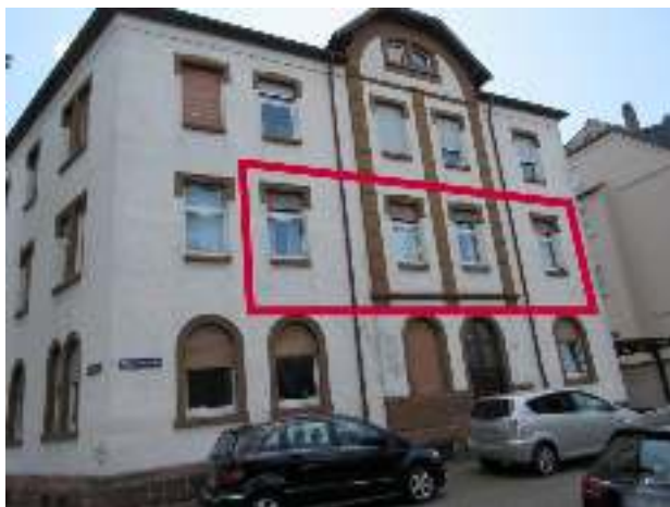
Straßenfassade Mauerstraße, Wohnung Nr. 3
