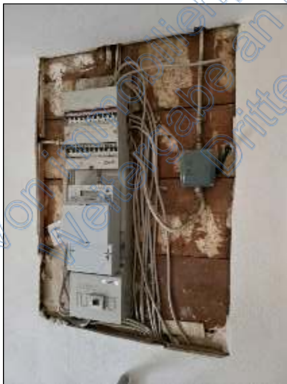
Elektrounterverteilung
