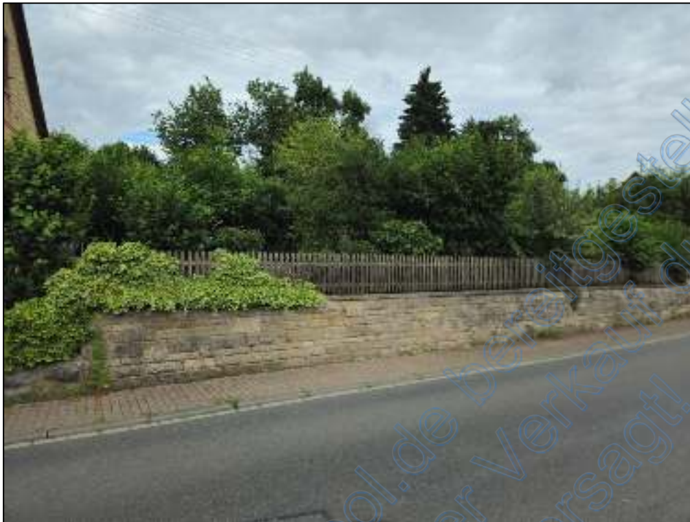
Flurstück Nr. 314 von Südwesten
