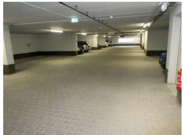
Tiefgarage Grüne Meile 52-56
