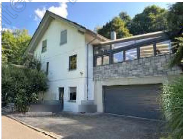
13 Blick auf das Wohnhaus von Südwesten.
