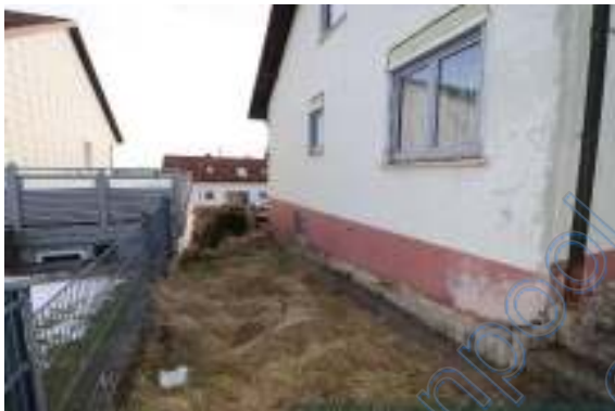
Putzabplatzungen Außenfassade
