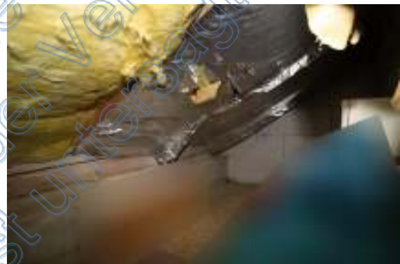
Hinunterhängende Dämmwolle
