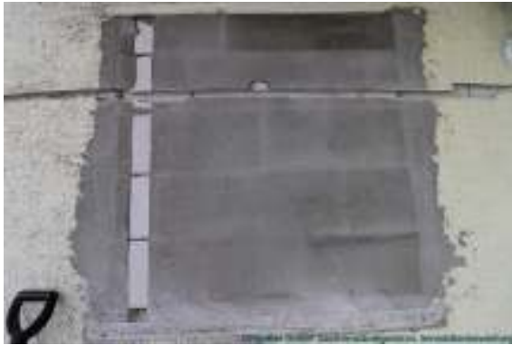
Zugemauertes Fenster an nördlicher Traufseite
