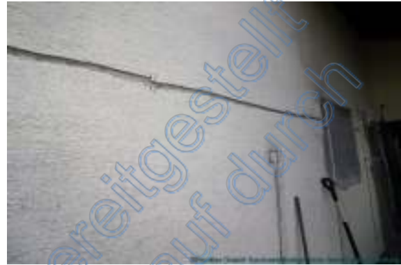
Gefraster Schlitz an nördlicher Außenfassade
