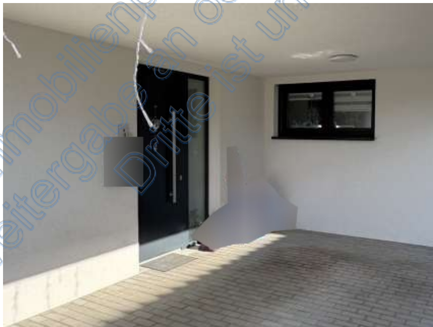
Bild 4: Zugang zum Gebäude
