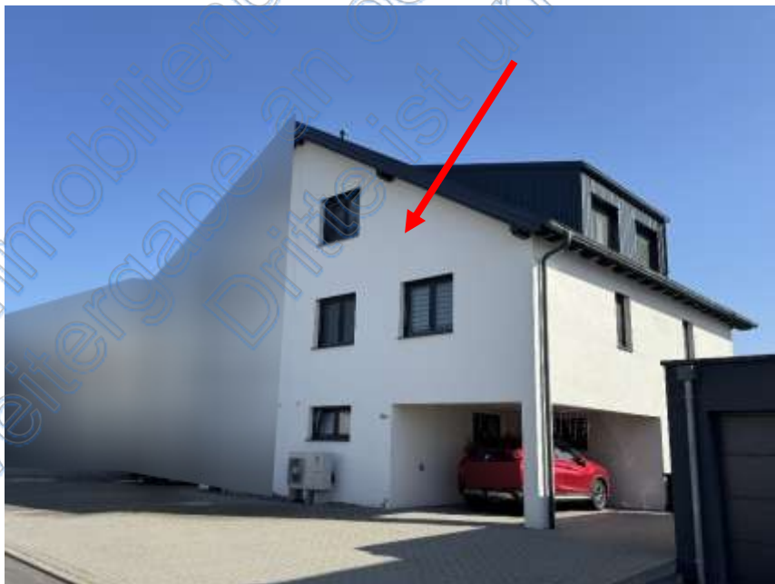
Bild 2: Gebäudeansicht von Westen
