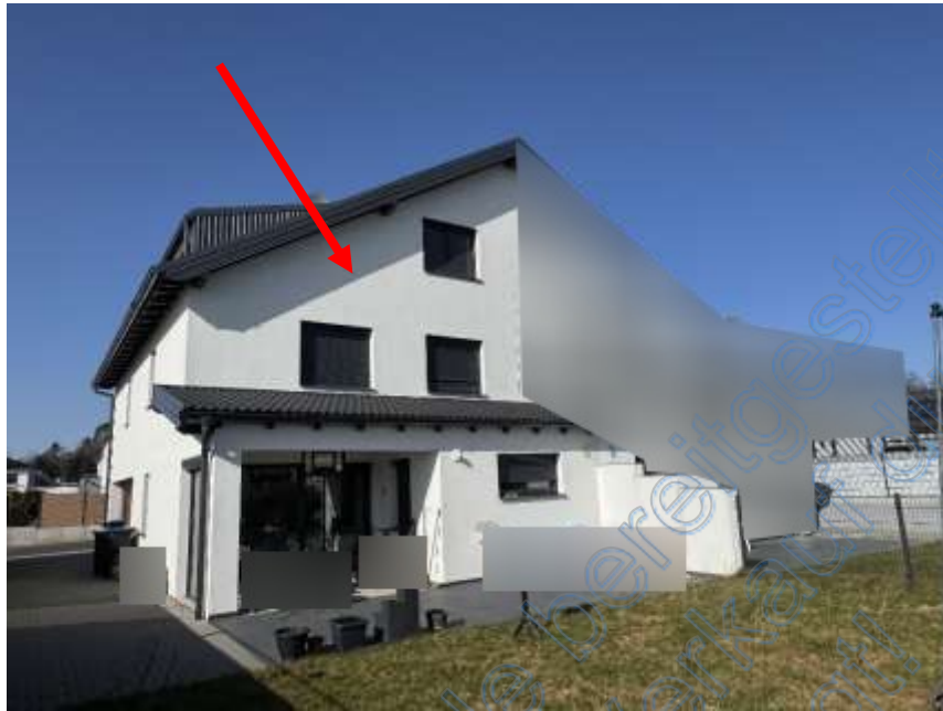
Bild 3: Gebäudeansicht von Südosten
