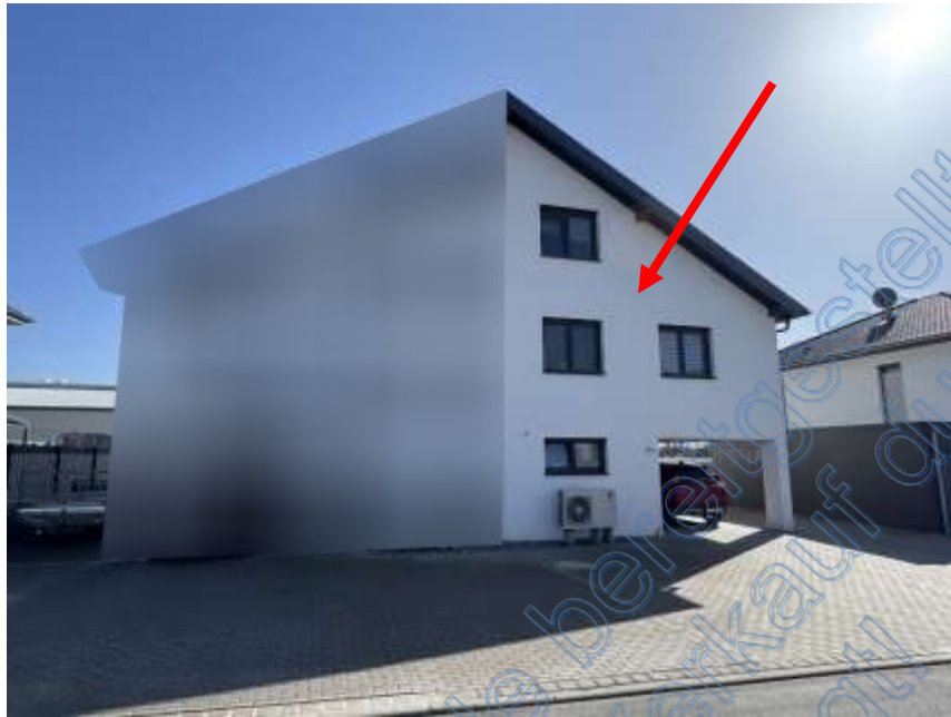
Bild 1: Gebäudeansicht von Nordwesten
