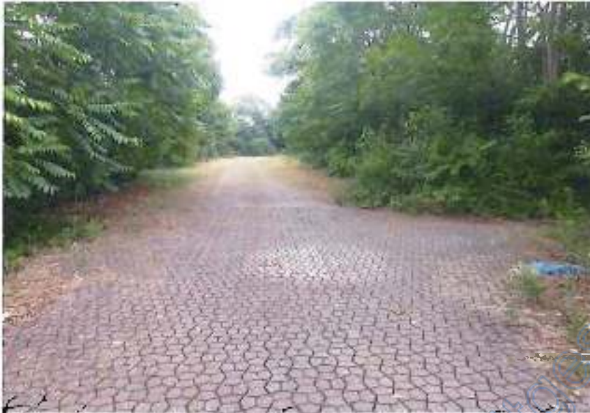
Foto 3: Derzeit abgesperrter Grundstücksbereich
