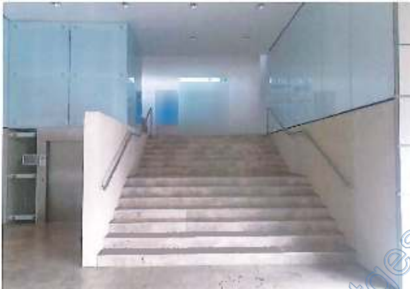
Foto 12: Eingangsbereich im EG
