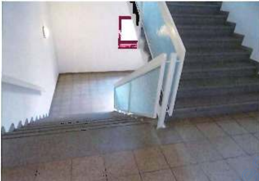
Foto 19: Treppenhaus im 1. OG
