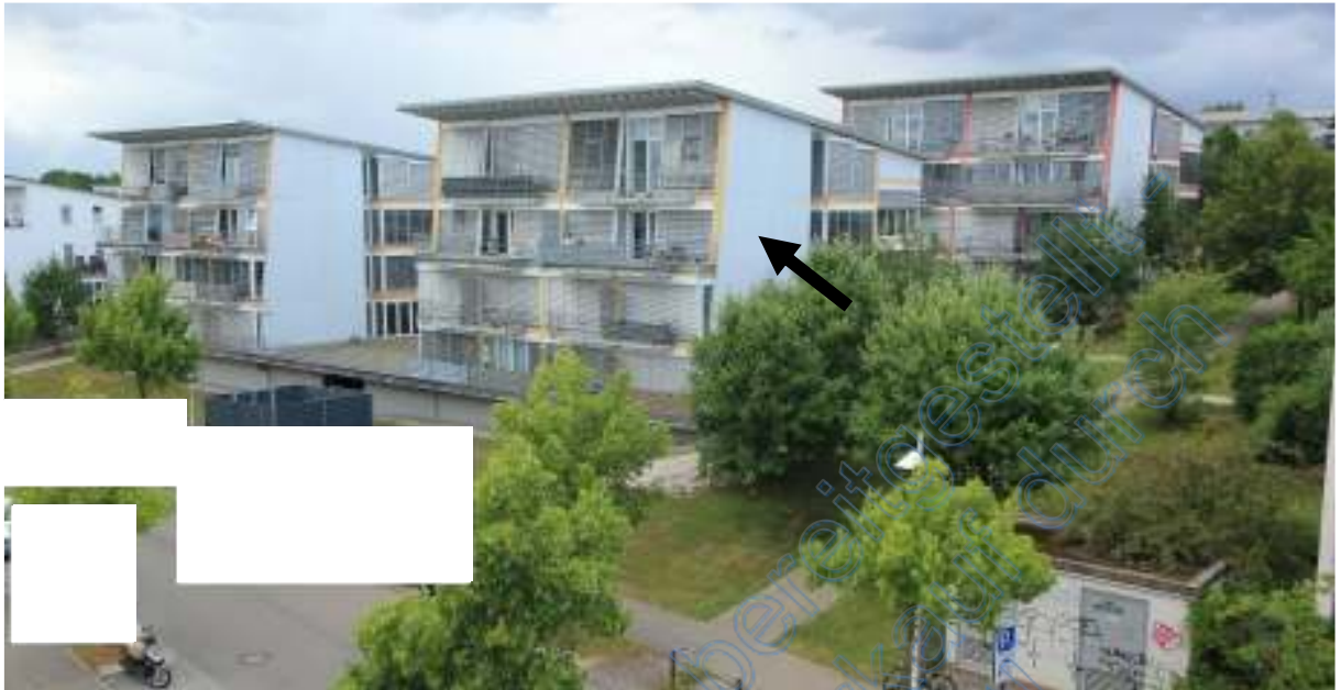
Eigentumsanlage mit den Gebäuden Virchowstraße 26 - 32 von Südosten, Pfeil HNr. 26
