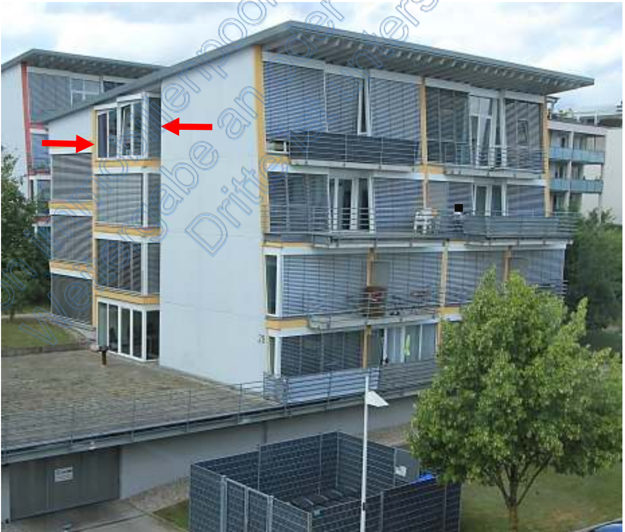
Haus 3 von Südwesten, rote Pfeile DG-Wohnung ATP Nr. 3.22
