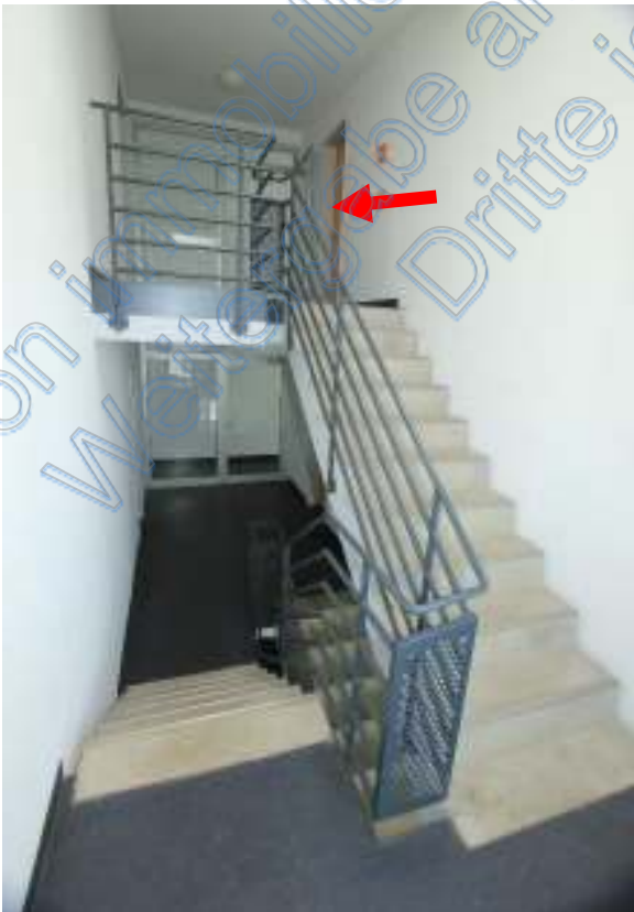
Treppenhaus OG/DG, Pfeil Wohnung Nr. 3.22
