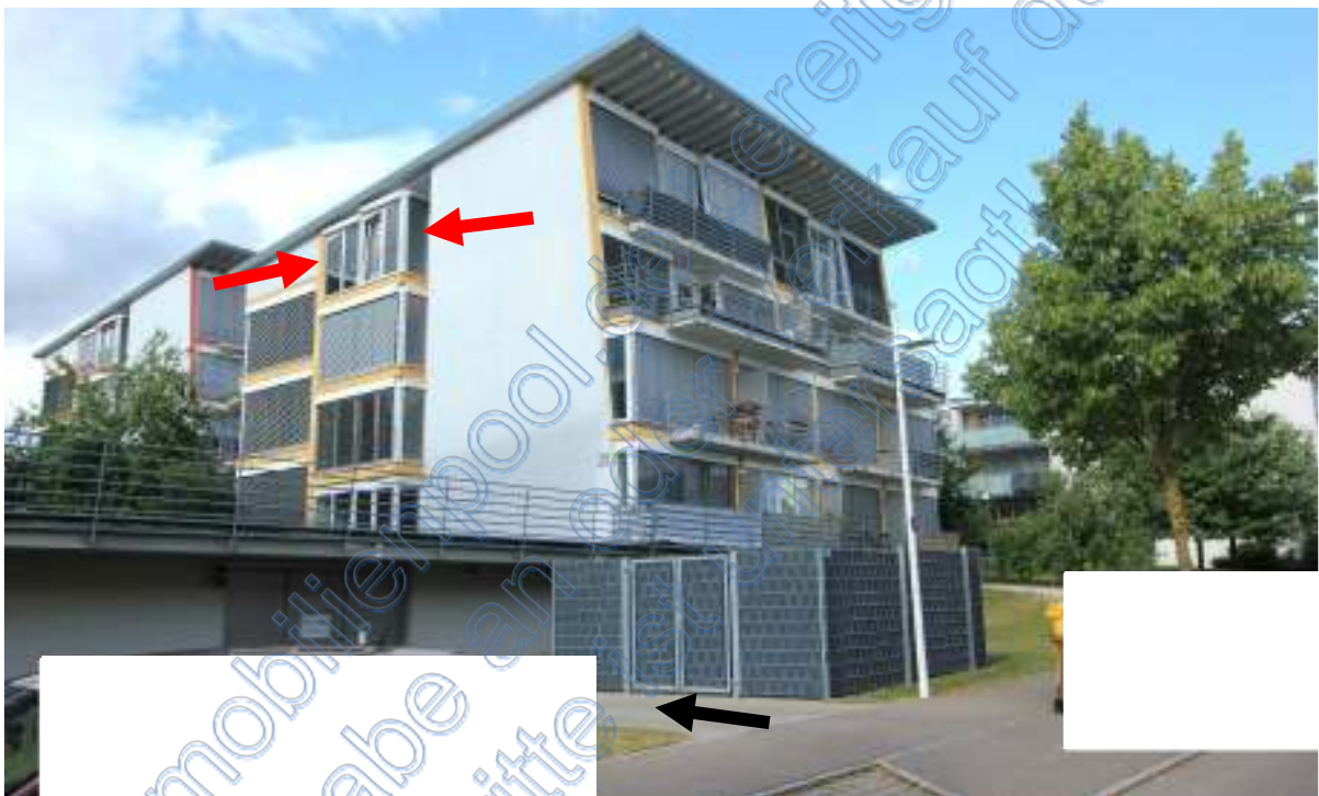
Blick von Südwesten, rote Pfeile DG-Wohnung ATP Nr. 3.22, schwarzer Pfeil TG-Zufahrt
