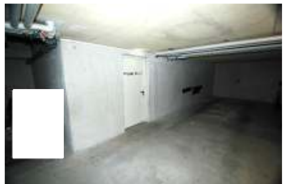
Zugang zum Treppenhaus im UG
