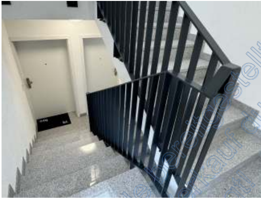
Bild 5: Treppenhaus mit Wohnungszugängen
