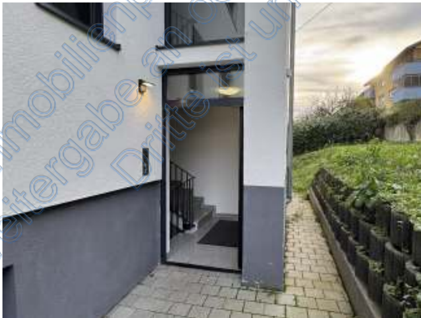
Bild 4: Zugang zum Gebäude
