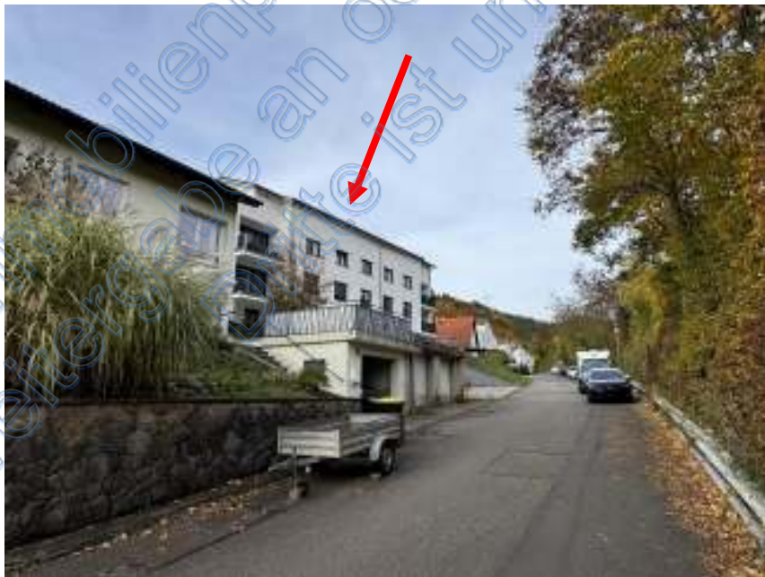
Bild 10: Umgebungsbebauung mit Blick nach Norden
