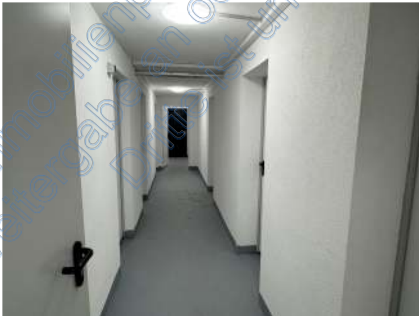
Bild 12: Untergeschoss mit Zugang zu den Technik-/Abstellräumen
