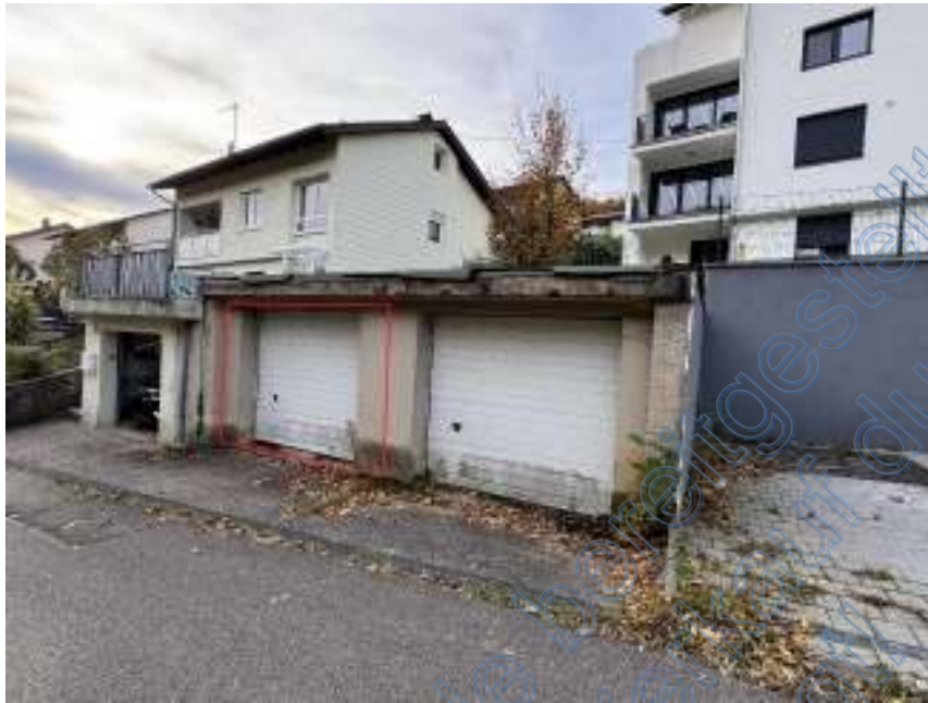
Bild 13: Garagenstellplatz "Gar 2" (rot markiert) als Sondernutzungsrecht
