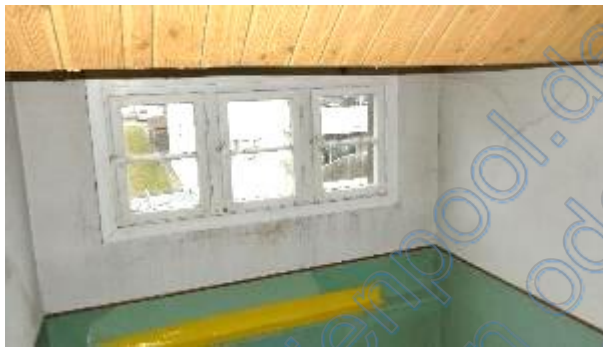
Treppenhaus OG-DG Giebelbereich
