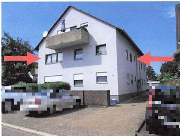
Straßenansicht + Ostfassade, Wohnung N. 4
