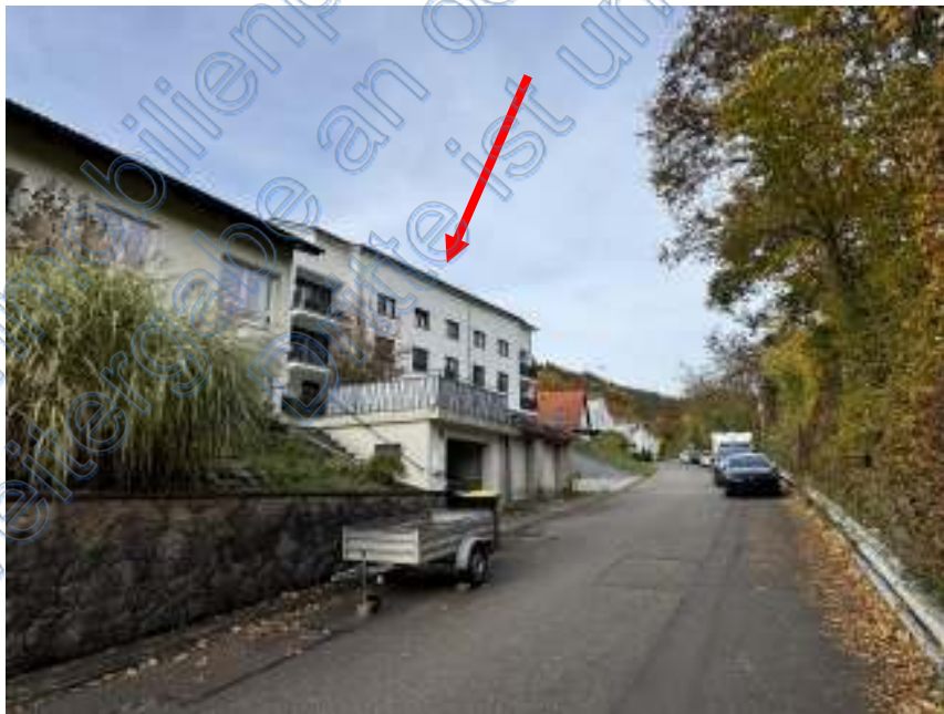
Bild 16: Umgebungsbebauung mit Blick nach Norden
