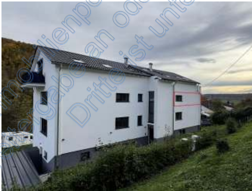
Bild 2: Gebäudeansicht von Norden mit rot markiertem Bewertungsobjekt
