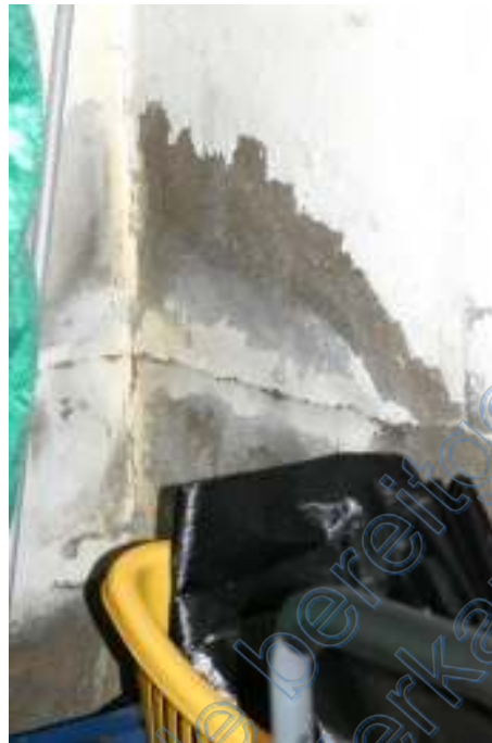
In der Garage, welche von den Mietern der Erdgeschosswohnung genutzt wird, sind im Inneren in einer Ecke Feuchtigkeitsspuren sichtbar.
