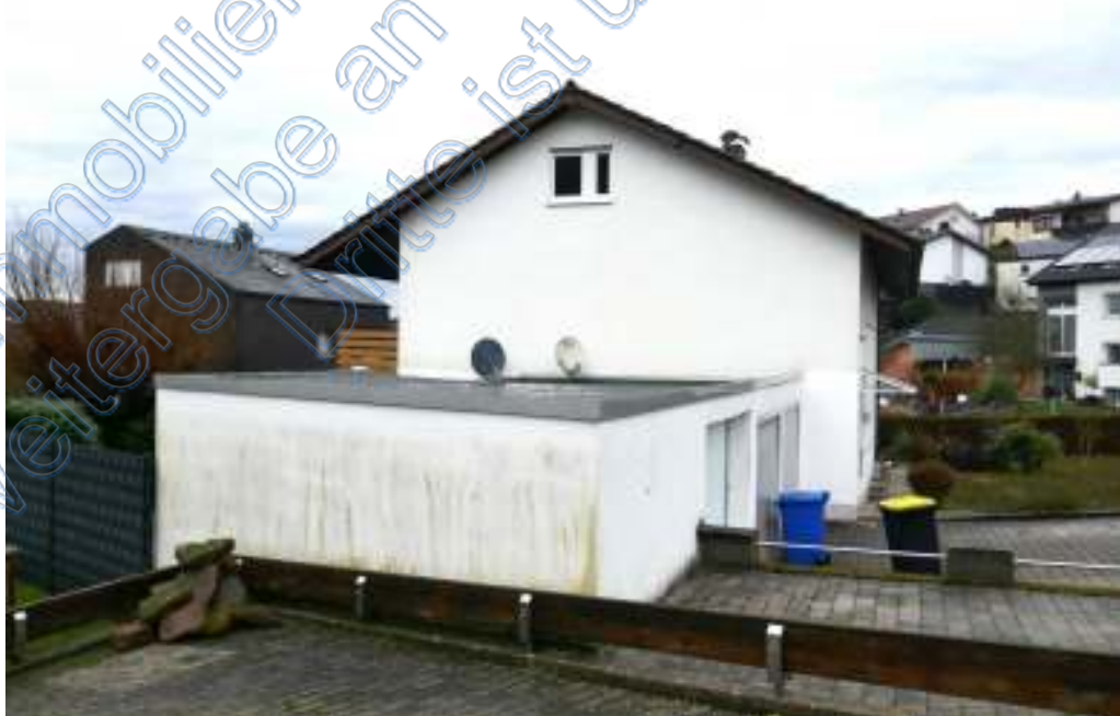
Blick von Süden auf das Wohnhaus mit Garagen. An der Außenfassade der Garage in konventioneller Bauweise sind Feuchtigkeitsspuren und Rissbildungen sichtbar.
