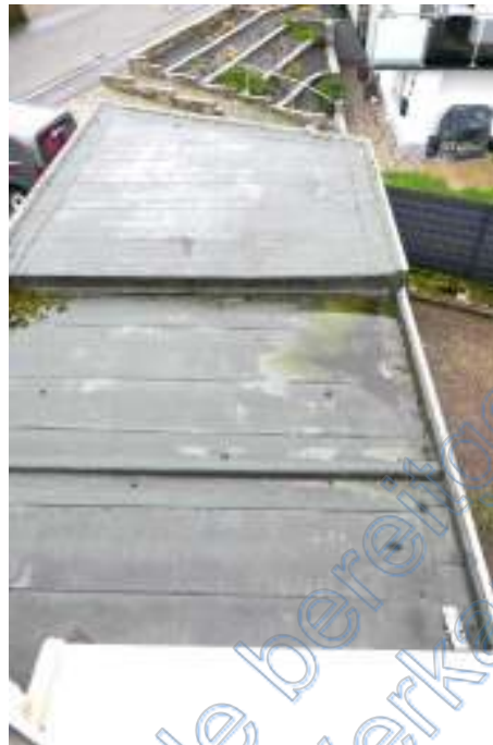
Blick auf die Dächer der Garagen. Das Wasser kann nicht abfließen, Wasser dringt ins Innere ein.
