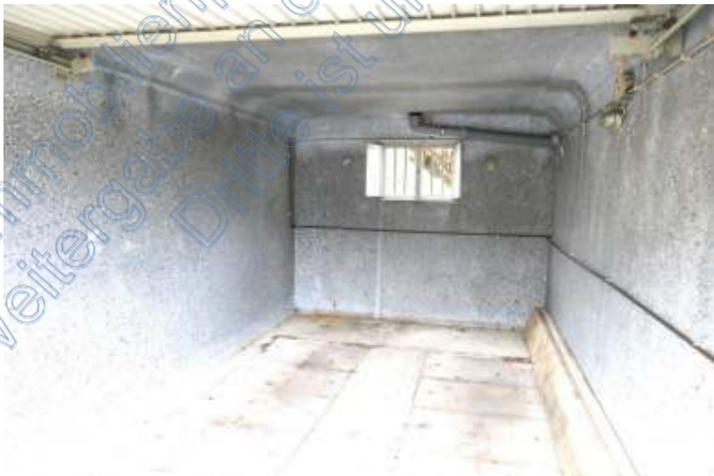
Blick in eine der Fertiggaragen. Die Betoneinlegeböden beider Garagen sind durchgebrochen.
