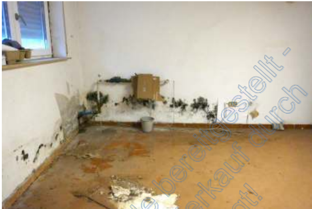
Blick in den im Grundriss als Hobbyraum ausgewiesenen Raum. Es sind Wasserschäden mit Schimmelbildungen vorhanden.
