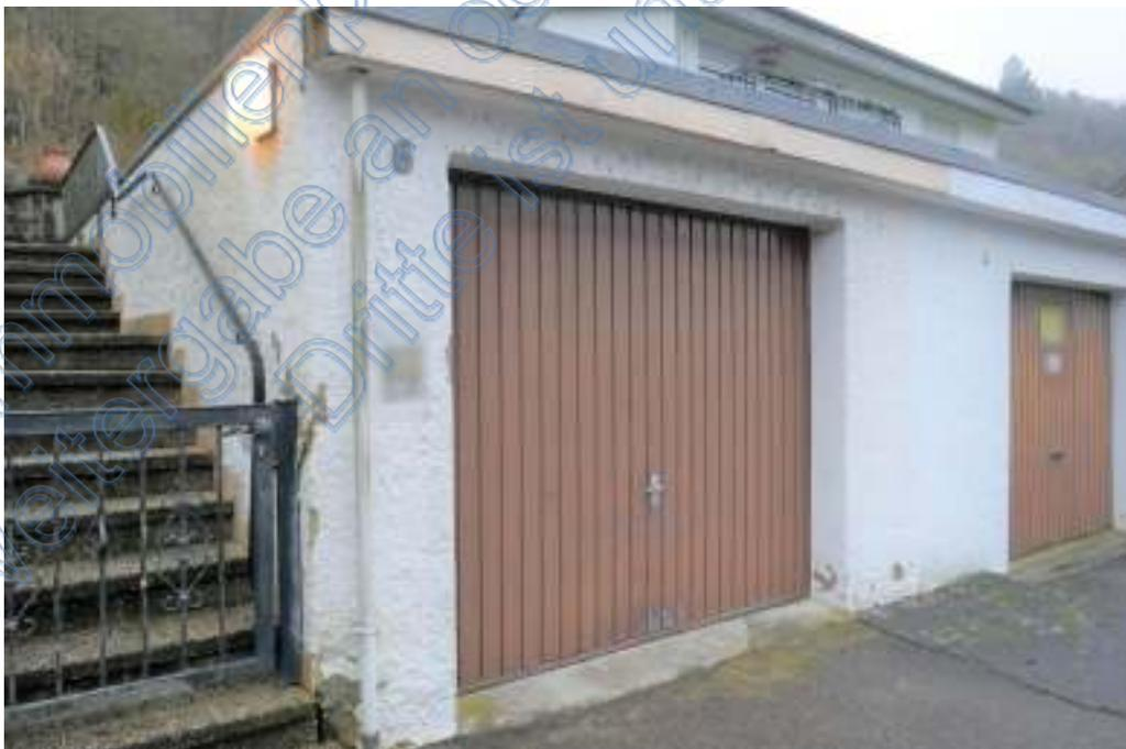
An der Fassade der Garage sind Farb- und Putzabplatzungen sichtbar.
