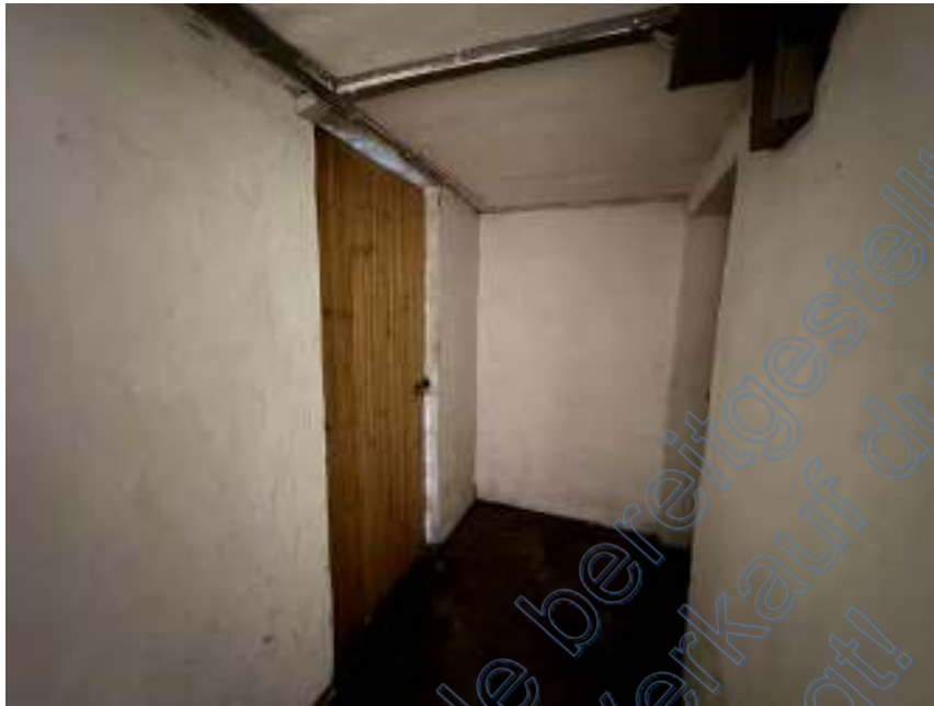
Bild 17: Zugang zum Kellerraum Nr. 7 (Teileigentum)
