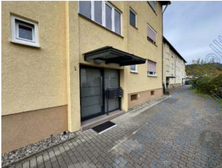
Bild 3: Zugang zum Gebäude "Forststr. 1"
