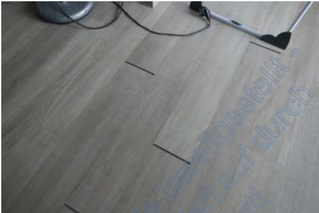
Die Laminatböden sind unsauber verlegt.
