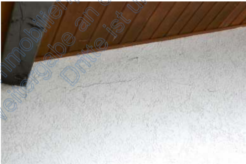
An der Hausfassade sind einige Rissbildungen sichtbar.
