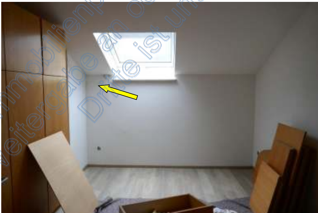
Blick in eines der Kinderzimmer. Im Bereich des Kamins ist ein Wasserschaden vorhanden (gelber Pfeil). Dieser zieht sich bis in den Wintergarten des Obergeschosses, wo Wasserspuren an der Wand erkennbar sind. Putz und Farbe lösen sich ab. Laut Baugutachter ist der Grund für den Wasserschaden die laienhafte Bearbeitung der Blechverwahrung an die Betonsteine.
