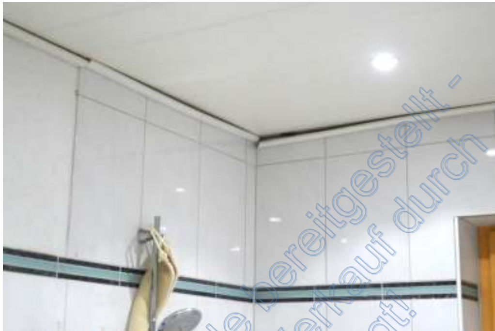
Der Wandabschluss der Deckenpaneele ist teilweise lose.
