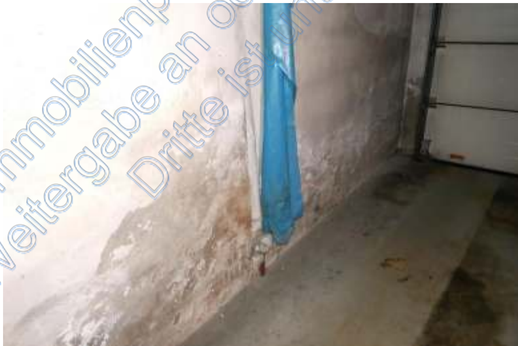
In der zweiten Garage sind Farb- und Putzabplatzungen sichtbar.
