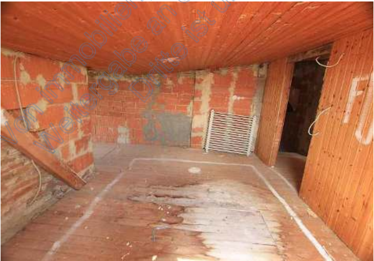
Bühne, Feuchtflecken auf dem Boden
