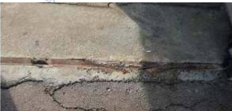
Durchgerostete Anschlagschiene
