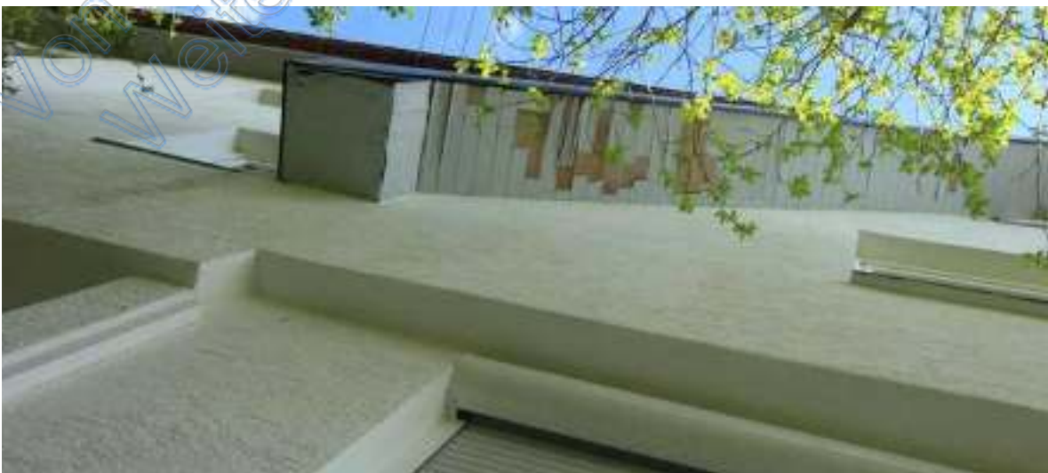
Schäden am Dachüberstand auf der Nordwestseite Mehrfamilienhaus
