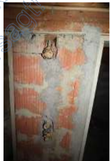
Begonnene Elektroverlegung
