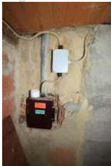
Begonnene Elektroverlegung in der Bühne im DG
