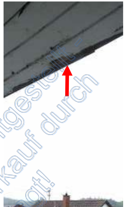
Dachschaden im Südwesten über dem Balkon im 1. OG mit Regendusche
