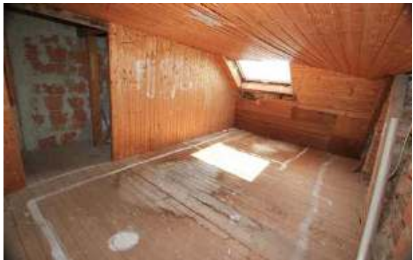
Bühne, Feuchtflecken auf dem Boden
