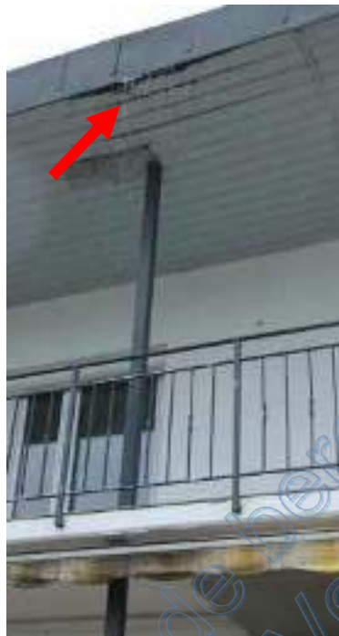
Dachschaden im Südwesten über dem Balkon im 1. OG mit Regendusche
