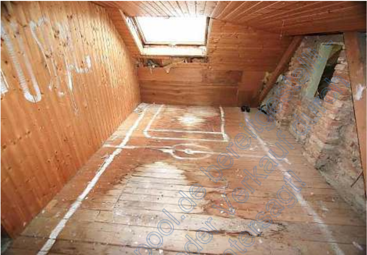
Bühne, Feuchtflecken auf dem Boden
