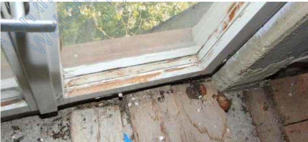
Anschluss altes Holzfenster und alter Dielenboden, fehlende Absturzsicherung
