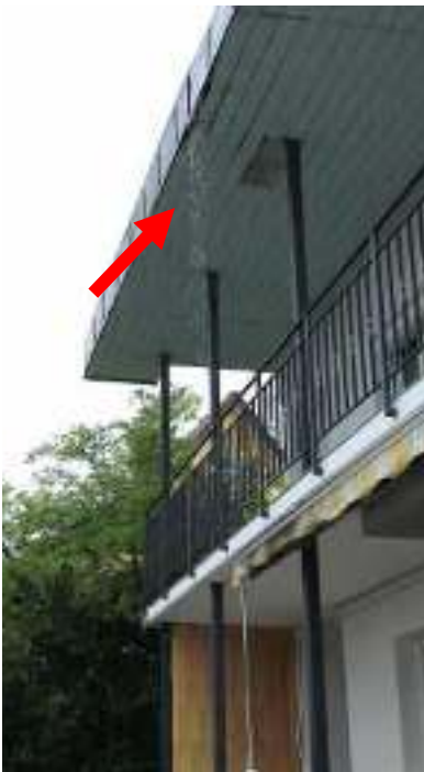
Dachschaden im Südwesten über dem Balkon im 1. OG mit Regendusche
