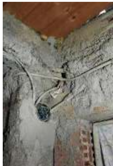
Begonnene Elektroverlegung in der Bühne im DG
