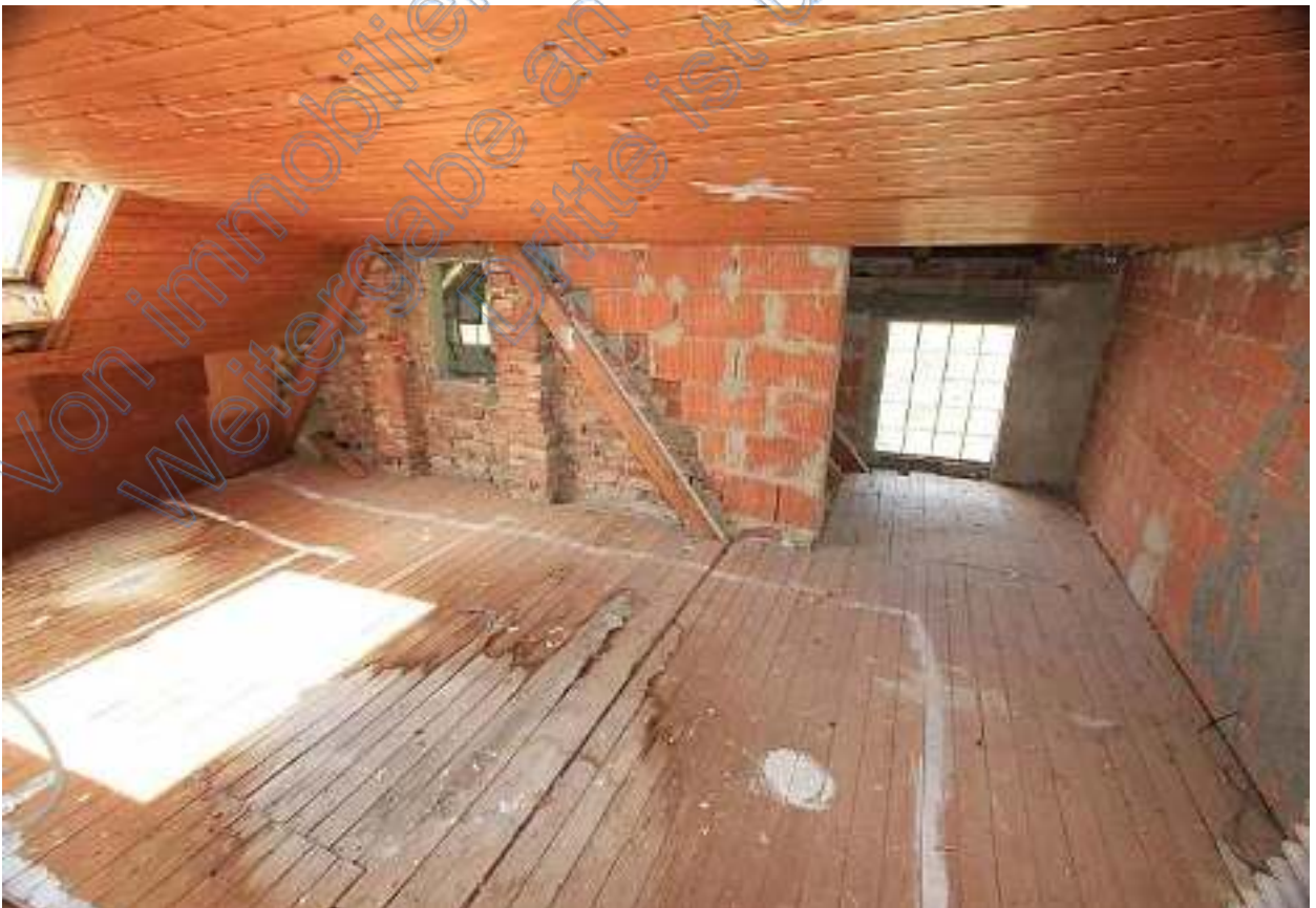
Bühne, Feuchtflecken auf dem Boden
