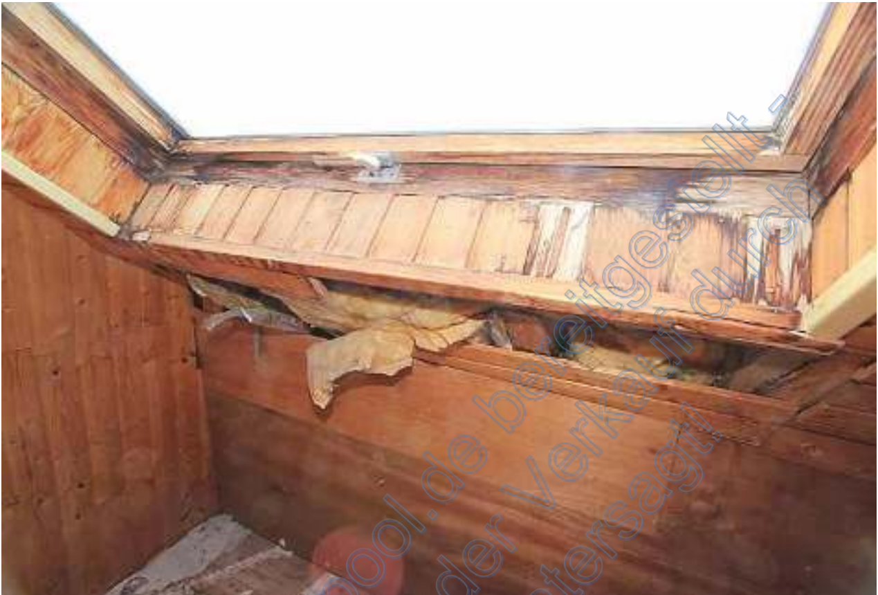
Marodes Dachfenster und schadhafte Innenverkleidung
