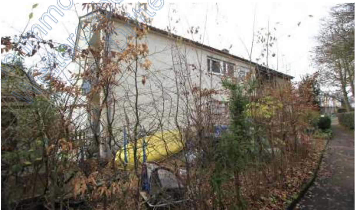
Wohnhaus von Nordosten
