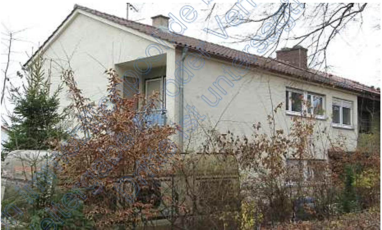
Wohnhaus von Nordosten
