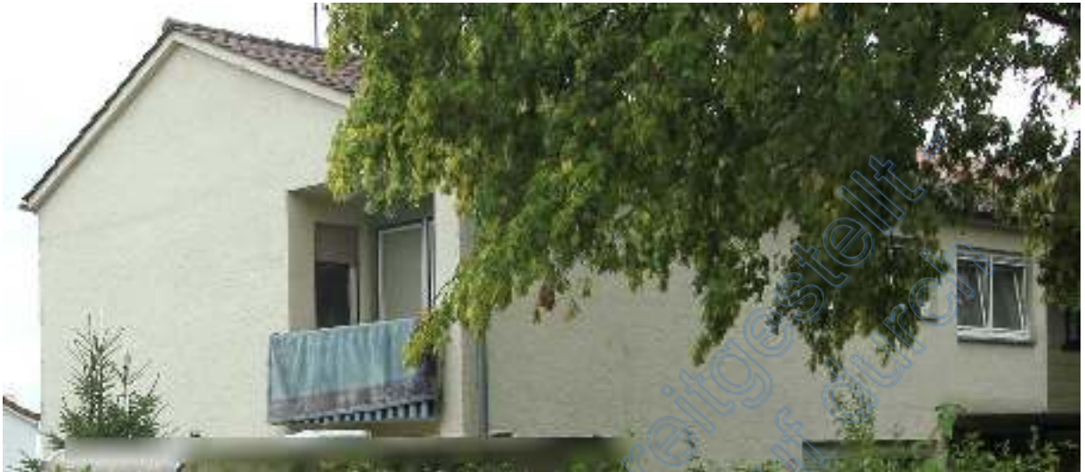
Wohnhaus von Nordosten
