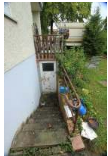
Kelleraußentreppe im Osten
