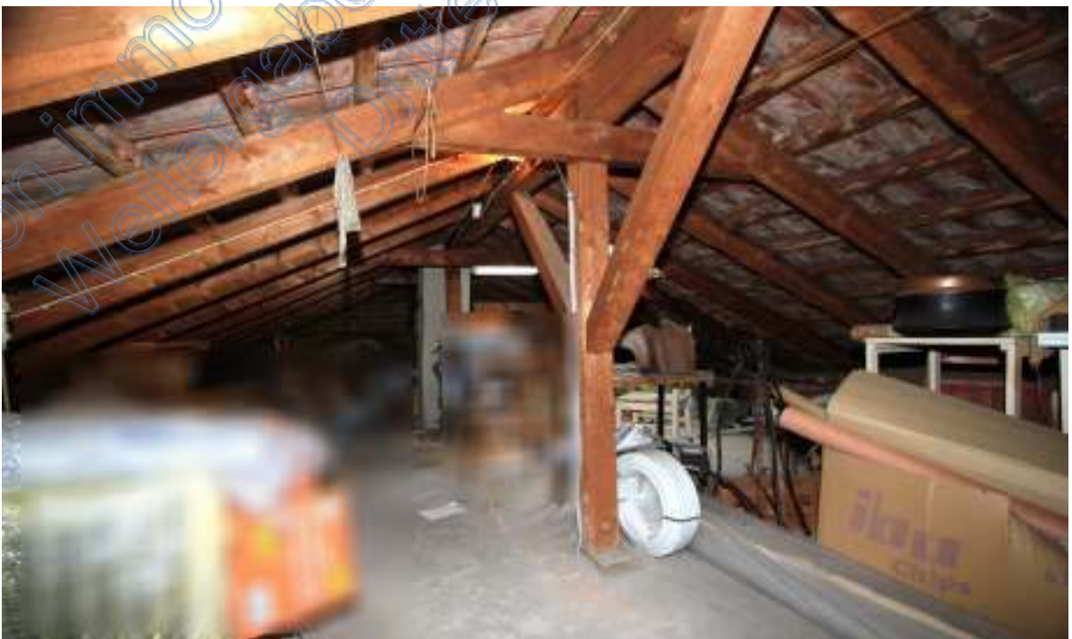
Ungedämmte Bühne im Dachgeschoss mit alten Dachziegeln
