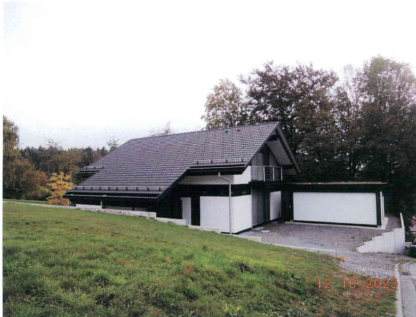
Bild 1: Straßenansicht aus südlicher Richtung
