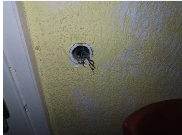
Schadhafte Elektroinstallationen (1. Obergeschoss Vorderhaus)
