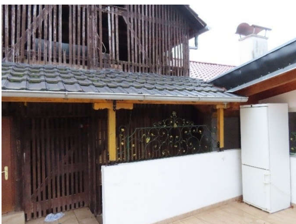
Scheune / Terrasse seitlicher Anbau
