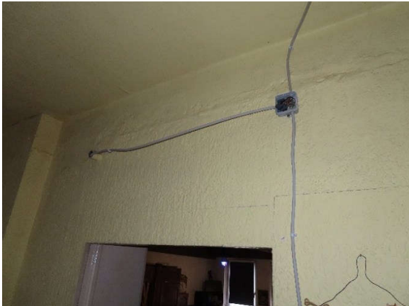
Schadhafte Elektroinstallationen (1. Obergeschoss Vorderhaus)
