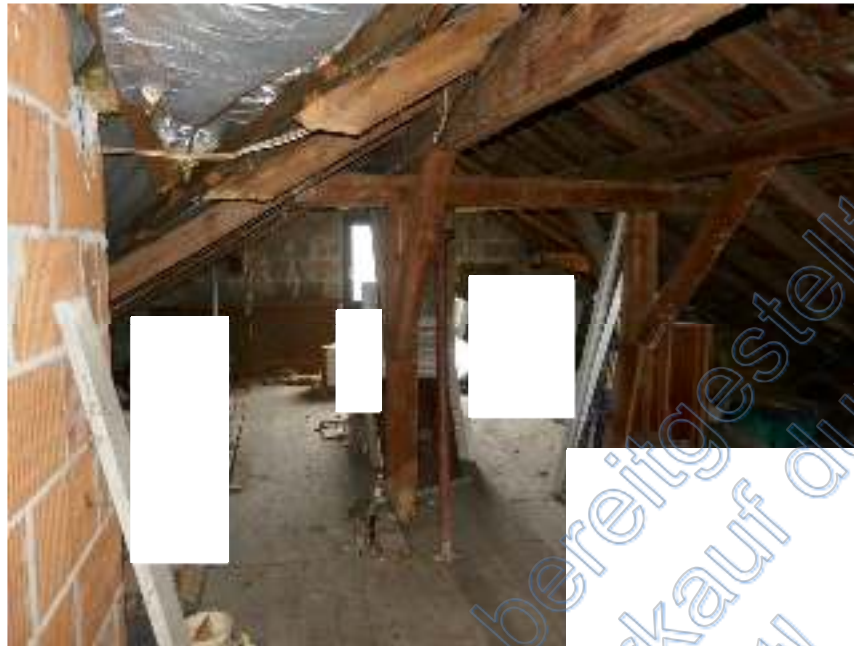
Bild 11: Speicher über dem "Altbau"
