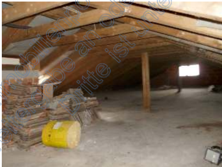
Bild 12: Speicher über dem "Neubau"
