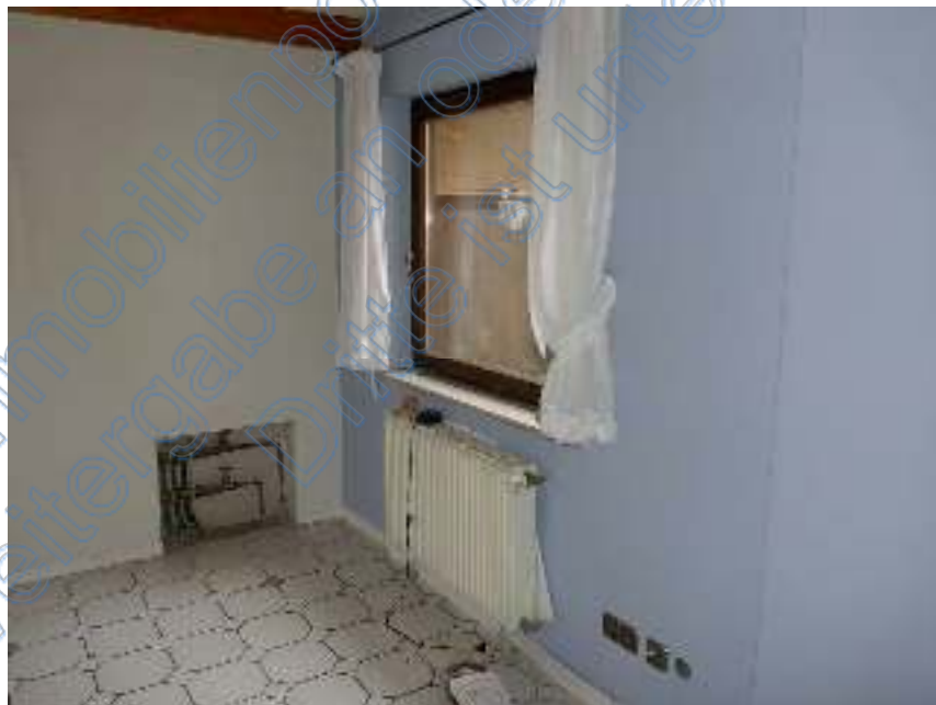
Bild 10: Küchenbereich im OG "Neubau"
