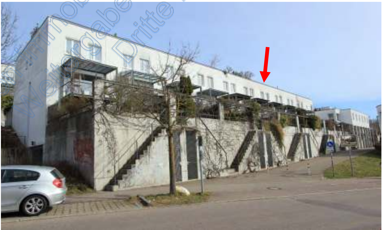
Reihenhausanlage von Südwesten, roter Pfeil Haus 12/7
