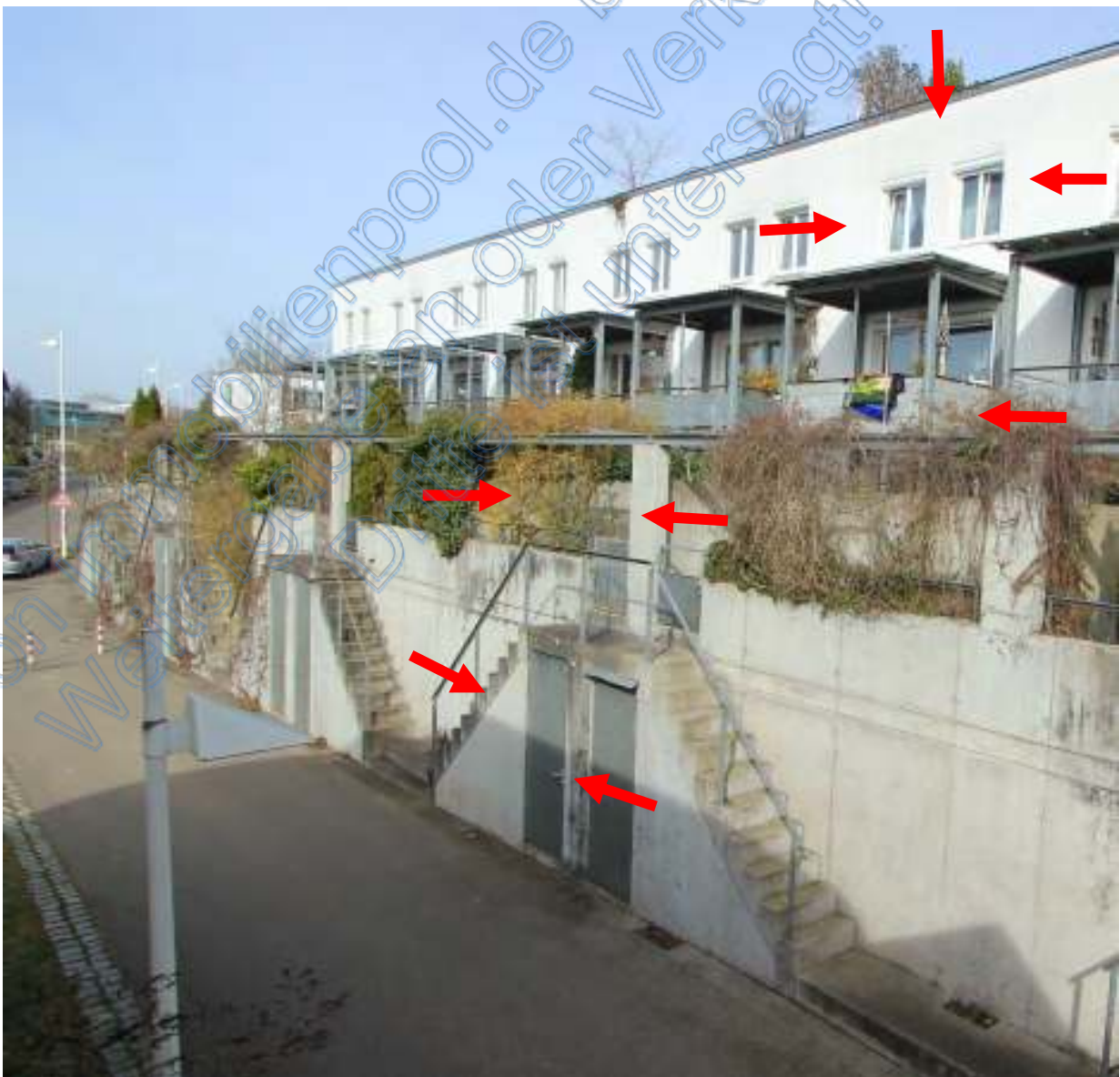
Südseite Reihenhausanlage, Pfeile Mittelhaus 12/7 mit Außentreppe
