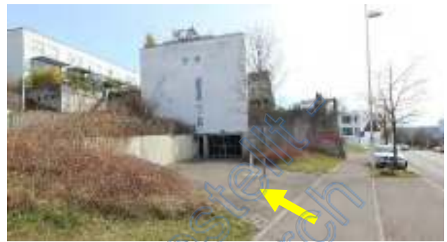
Tiefgaragenzufahrt Flst. 5347/10 von Westen
