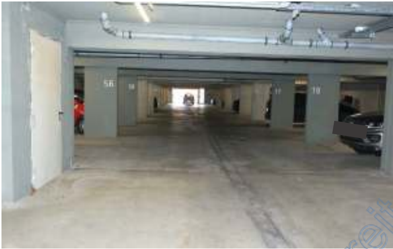
Blick in der Tiefgarage nach Westen, hinten Ausfahrt
