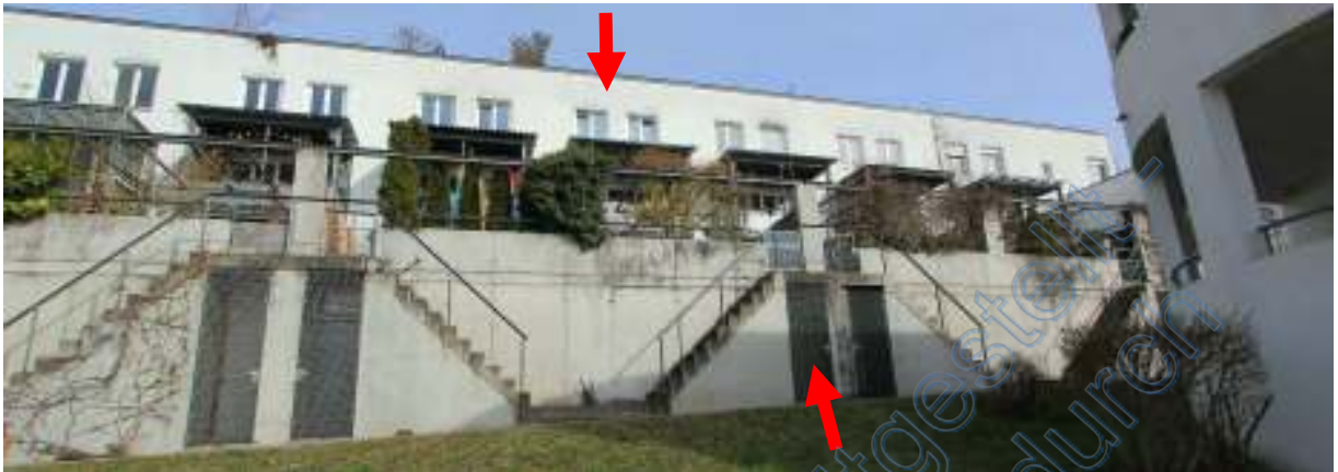
Südseite Reihenanlage, Pfeil Mittelhaus 12/7
