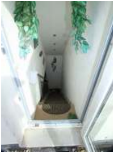
Treppe zum Dach von oben
