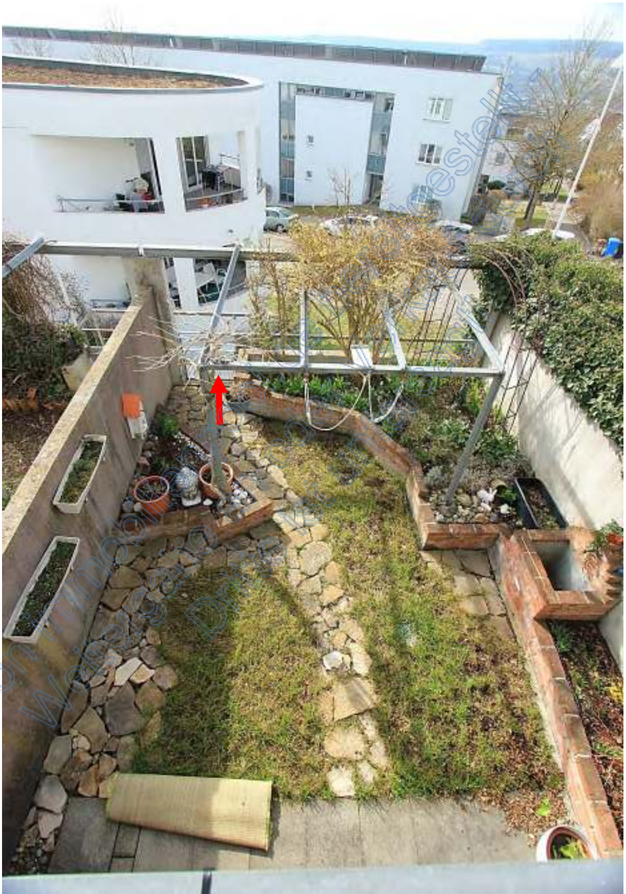
Blick vom Balkon im EG hinunter auf die Gartenterrasse mit Pergola Pfeil Ausgangstor zur Außentreppe
