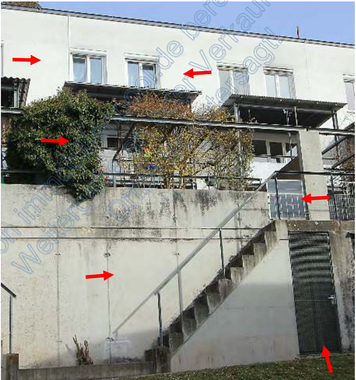
Südseite Mittelhaus 12/7 mit Außentreppe, Pfeil rechts unten Tür zum Abstellraum UG
