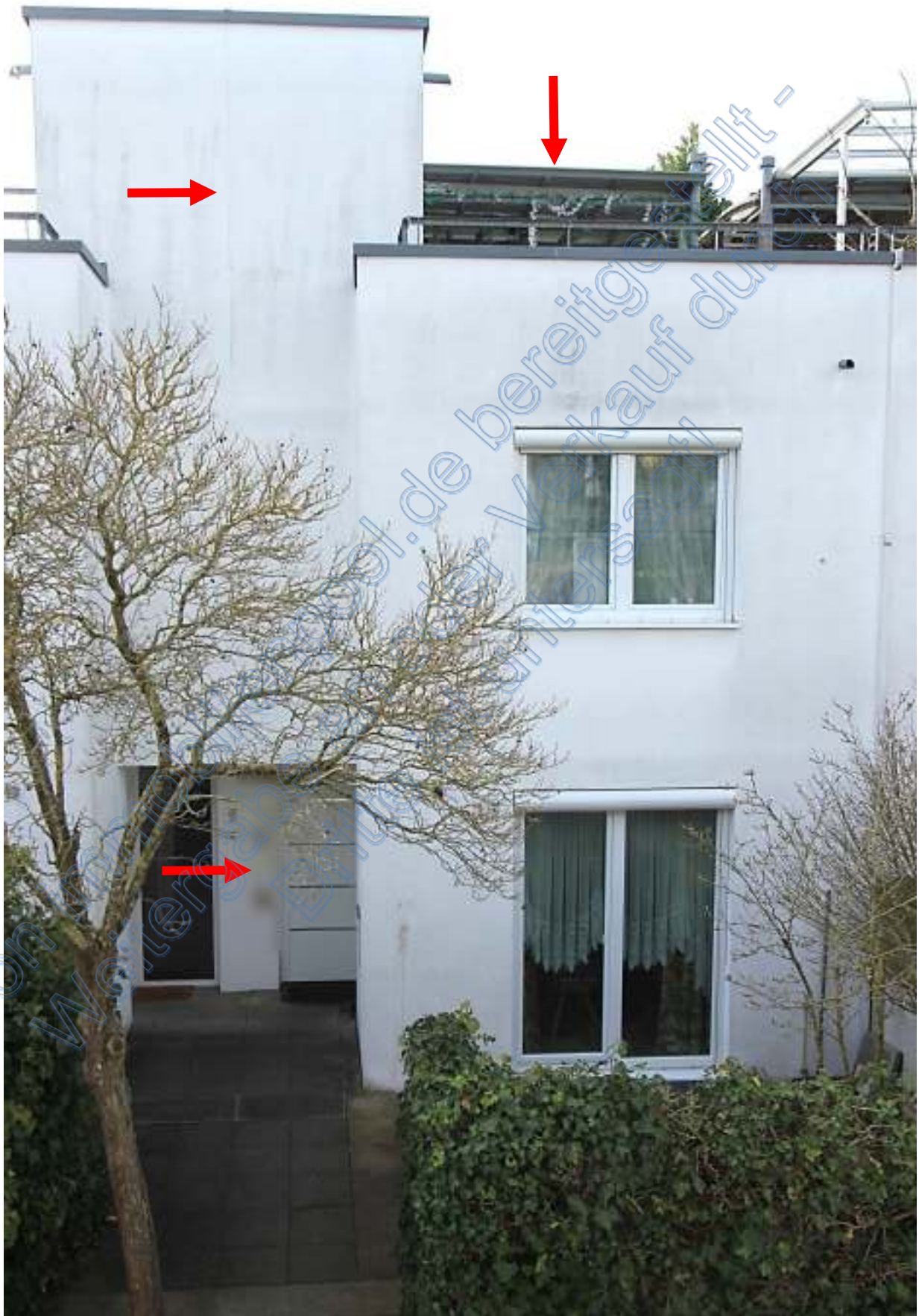
Nordseite Reihenhauses 12/7, Pfeil oben rechts überdachter Sitzplatz Dachterrasse
