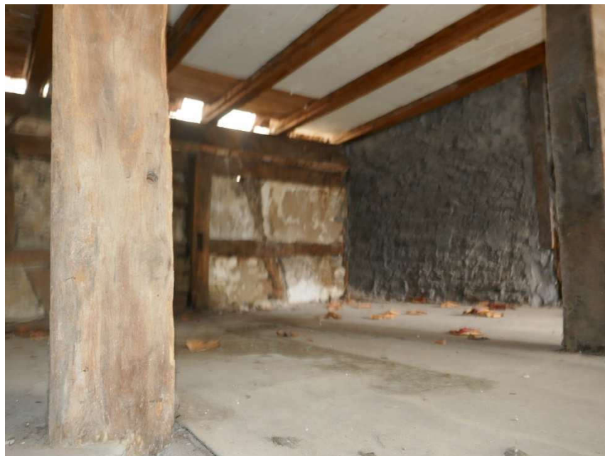
Bild 10: Innenansicht OG rückwärtiger Anbau
