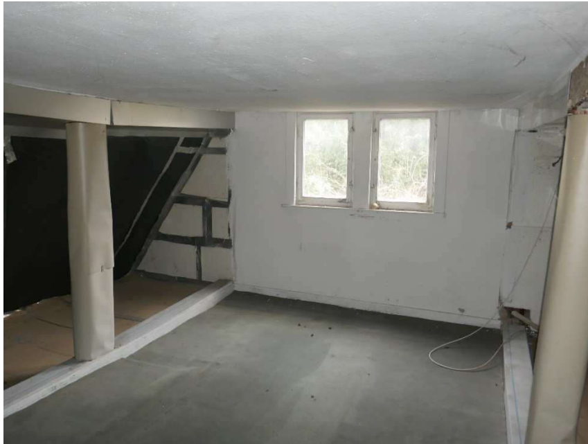
Bild 5: Innenansicht Dachgeschoss Vorderhaus
