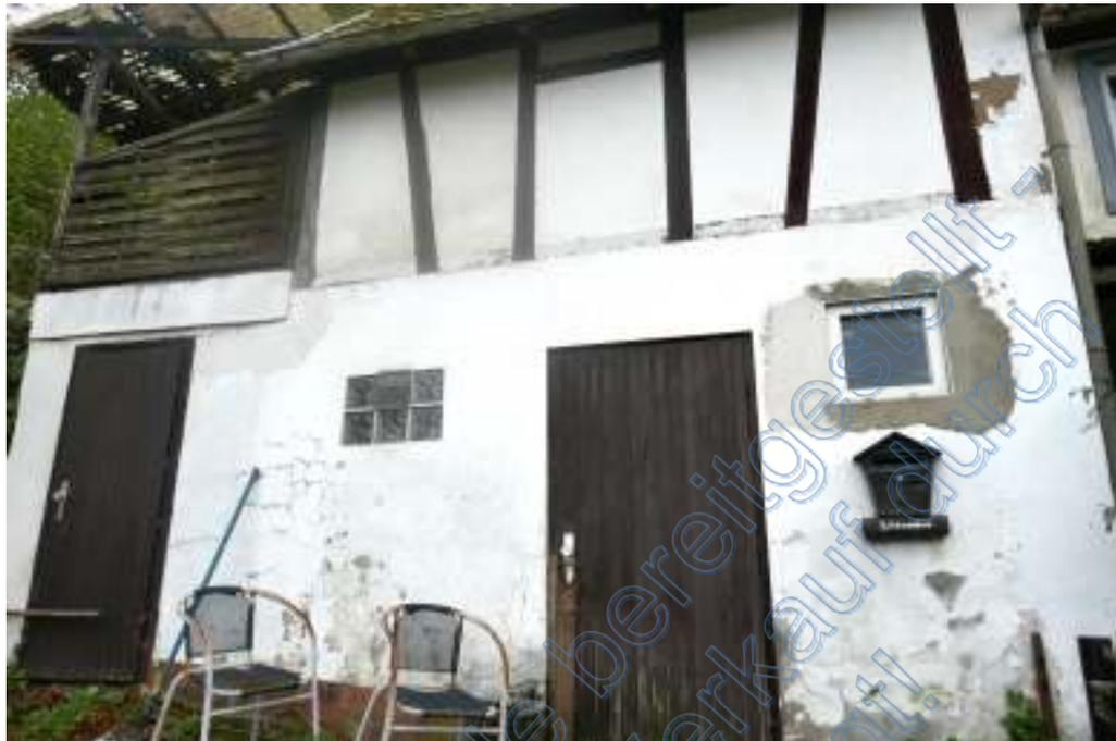
Blick auf den Wohnhausanbau. An der Außenfassade sind Feuchtigkeitsspuren sowie Farb- und Putzabplatzungen vorhanden.
