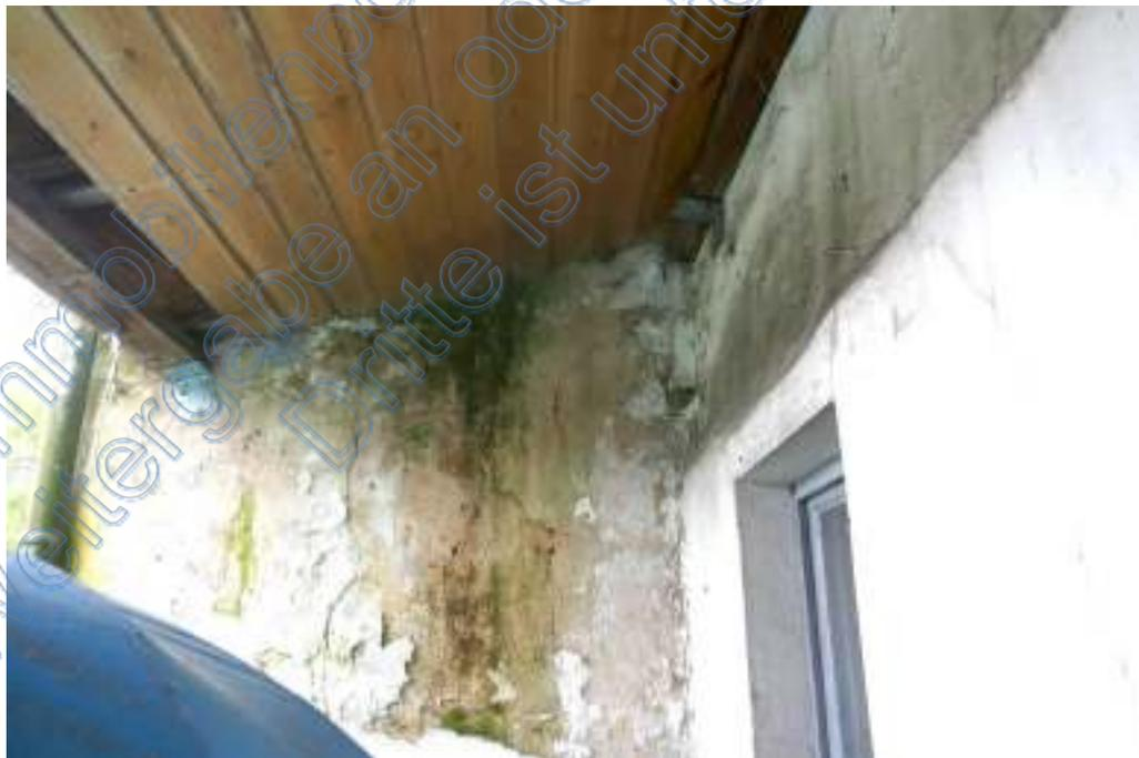
An dem Wohnhaus (Bild oben) und dem Anbau (Bild unten) sind ebenfalls Feuchtigkeitsspuren sowie Farb- und Putzabplatzungen sichtbar.
