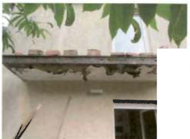
Schäden Balkonbodenplatte
