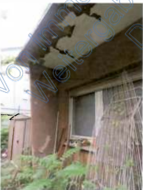
Schäden Balkonbodenplatte
