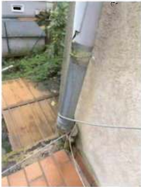
Schäden Regenfallrohr
