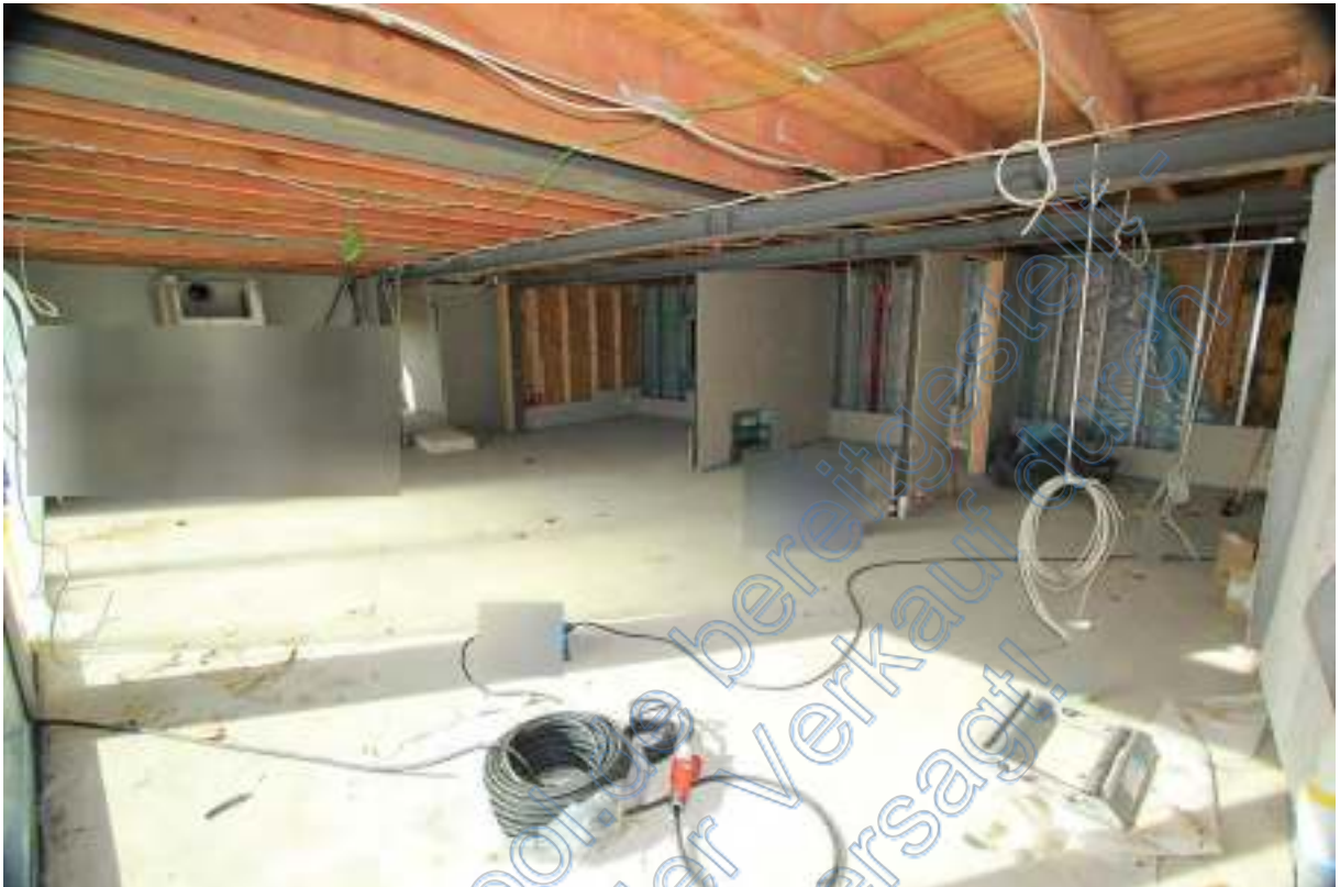
Küche/Essen, Blick nach Nordwesten zu den Nebenräumen im Bau, links hinten Kamin
