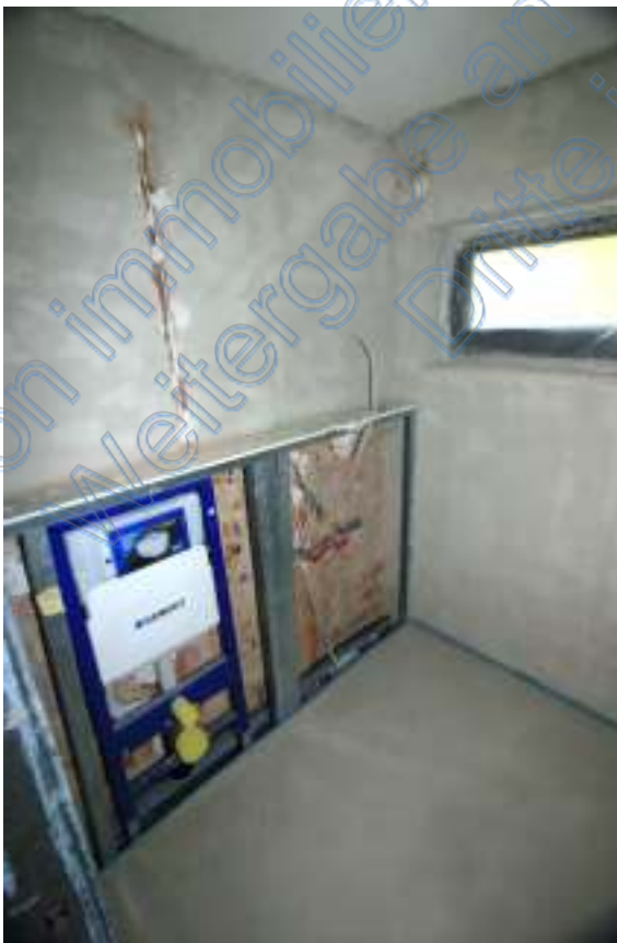
WC Unterputzkasten + Beckenanschluss
