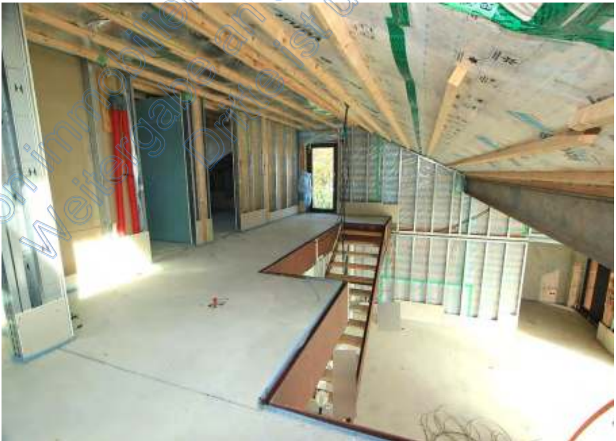
Galerie noch ohne Geländer, Blick nach Osten, links Kinderzimmer mit Bad
