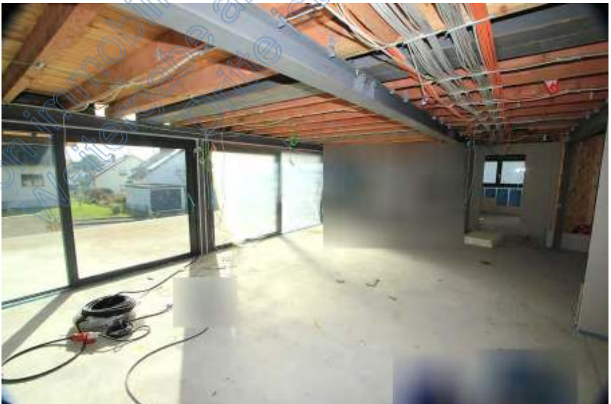
Küche/Essen mit Terrassenfenster und Schiebetüren, Holzdecke mit Stahlträgern
