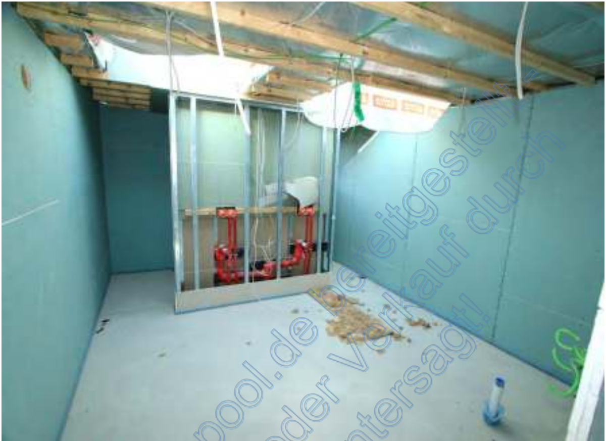
Elternbad im Ausbau
