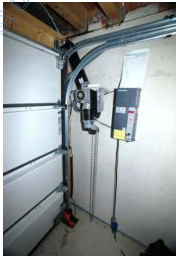
Elektrischer Garagentorantrieb
