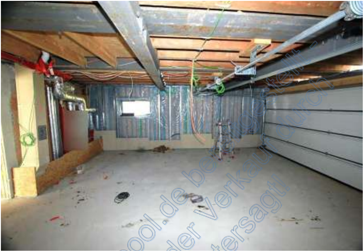
Doppelgarage, Blick nach Norden, rechts Sektionaltor
