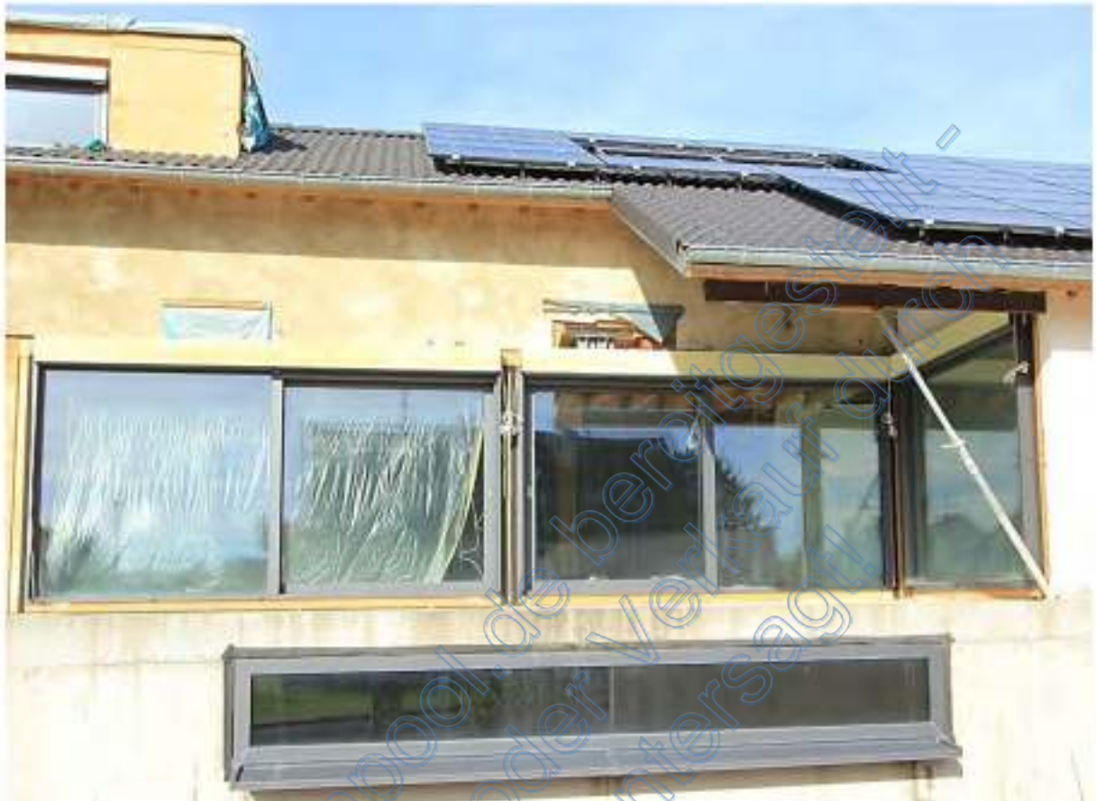
Südwand Wohnhaus; unten Kellerraumfenster unter der Terrasse, oben Essküchenbereich
