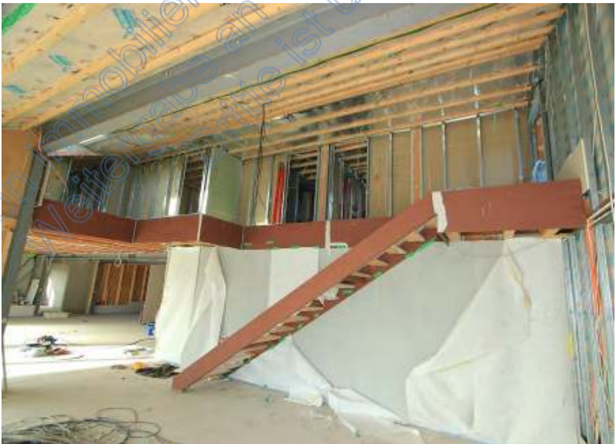
Wohnzimmer mit hoher Decke (Luftraum) und Treppe zur Galerie im DG
