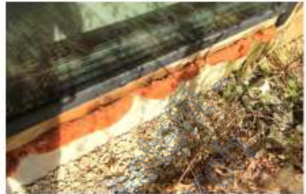
Unverputzter Fensteranschluss
