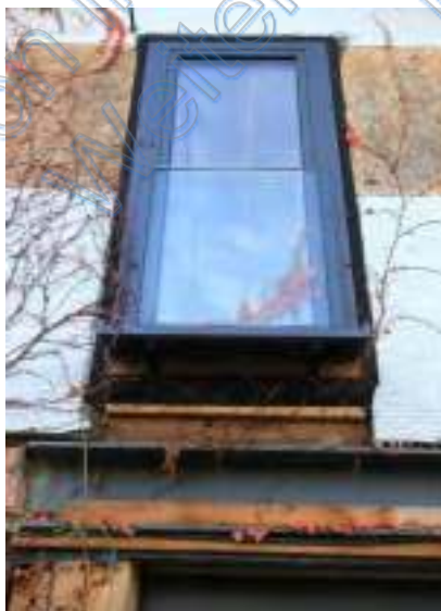
Giebelfenster im DG
