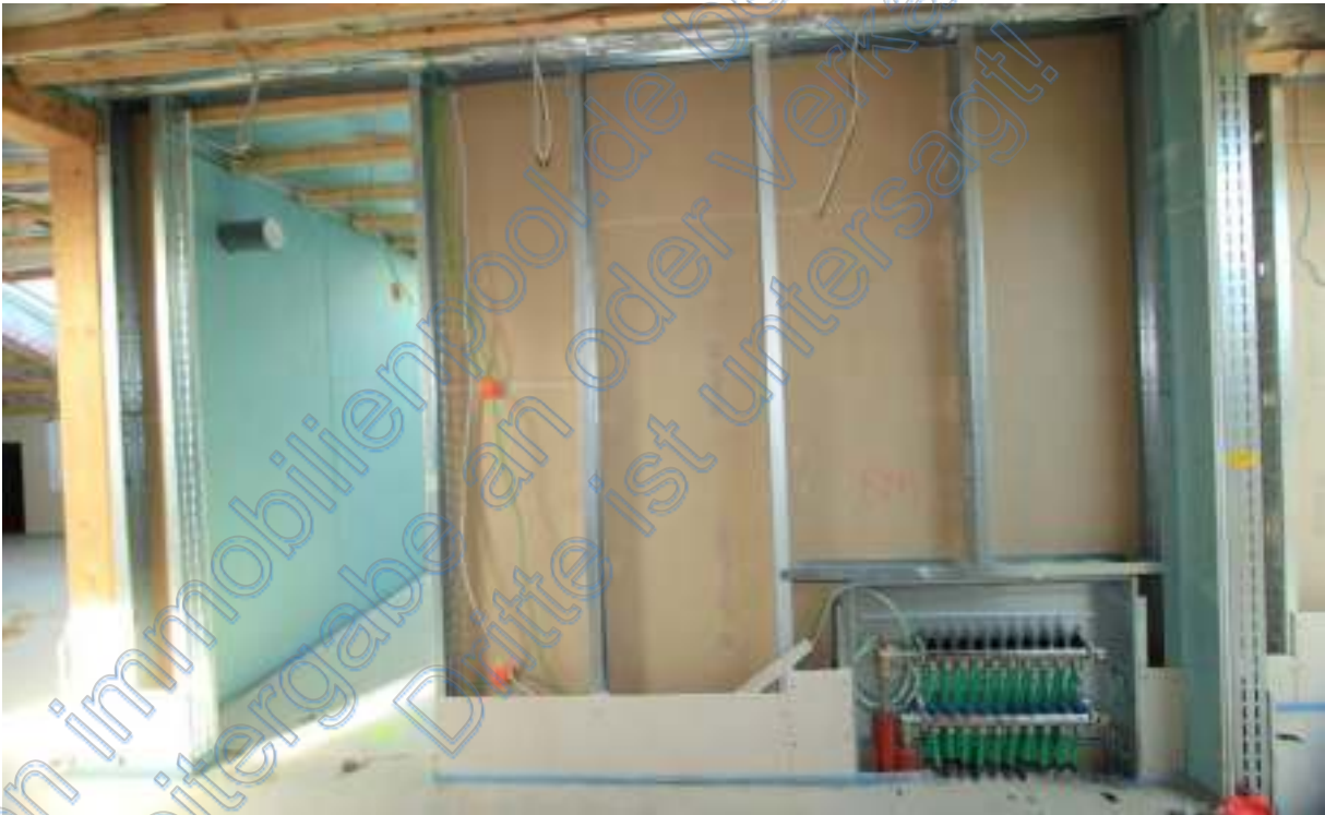
Badezimmerwand im Rohbau
