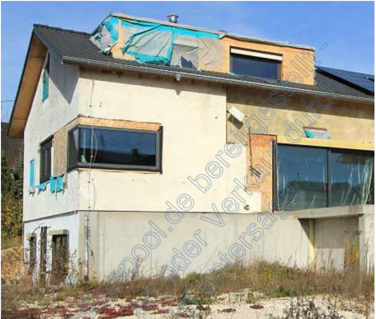
Westlicher Wohnhausteil von Süden
