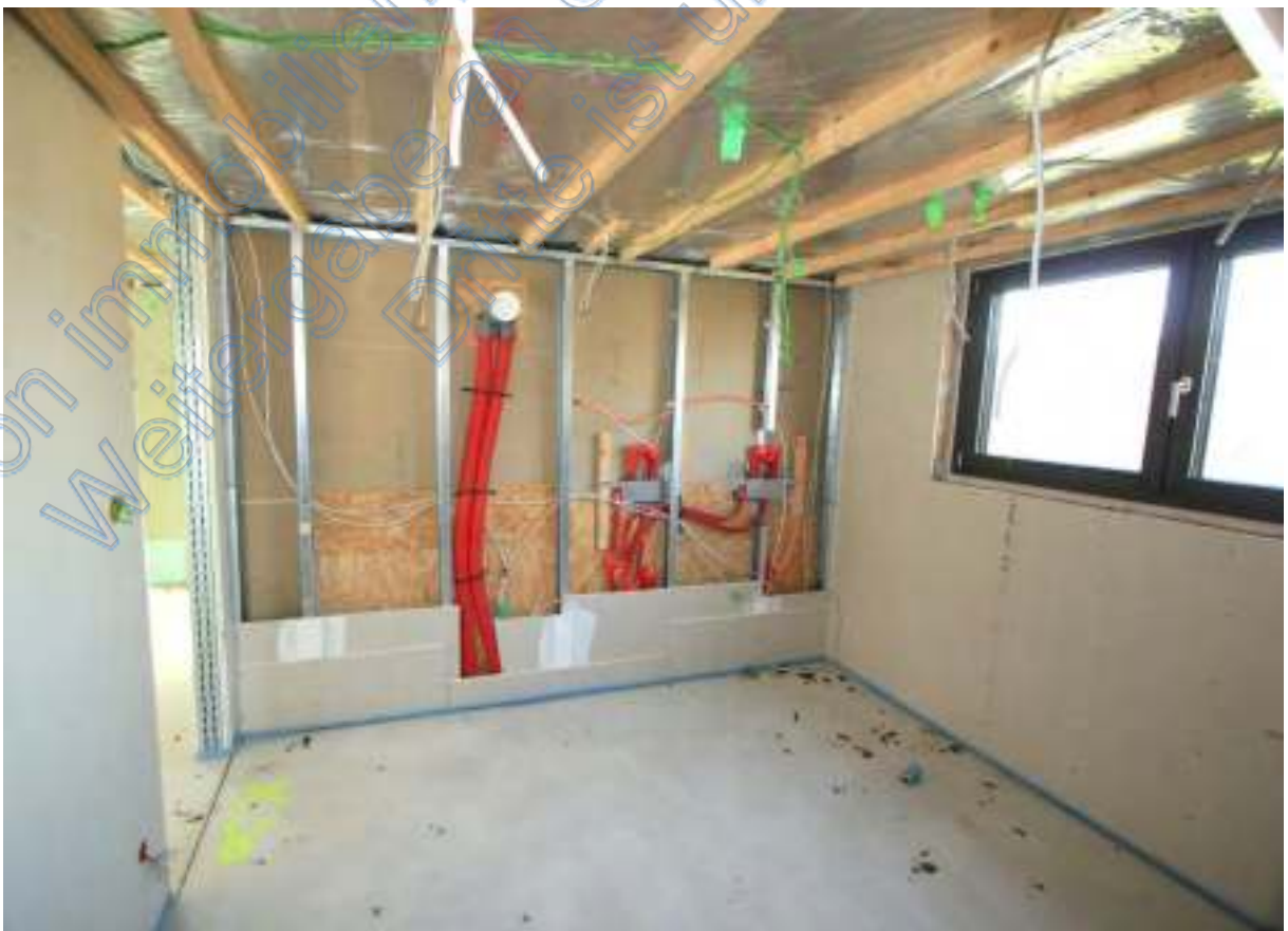
Kinderzimmer 1 im Osten neben der Galerie, Blick zur Trennwand zum Bad
