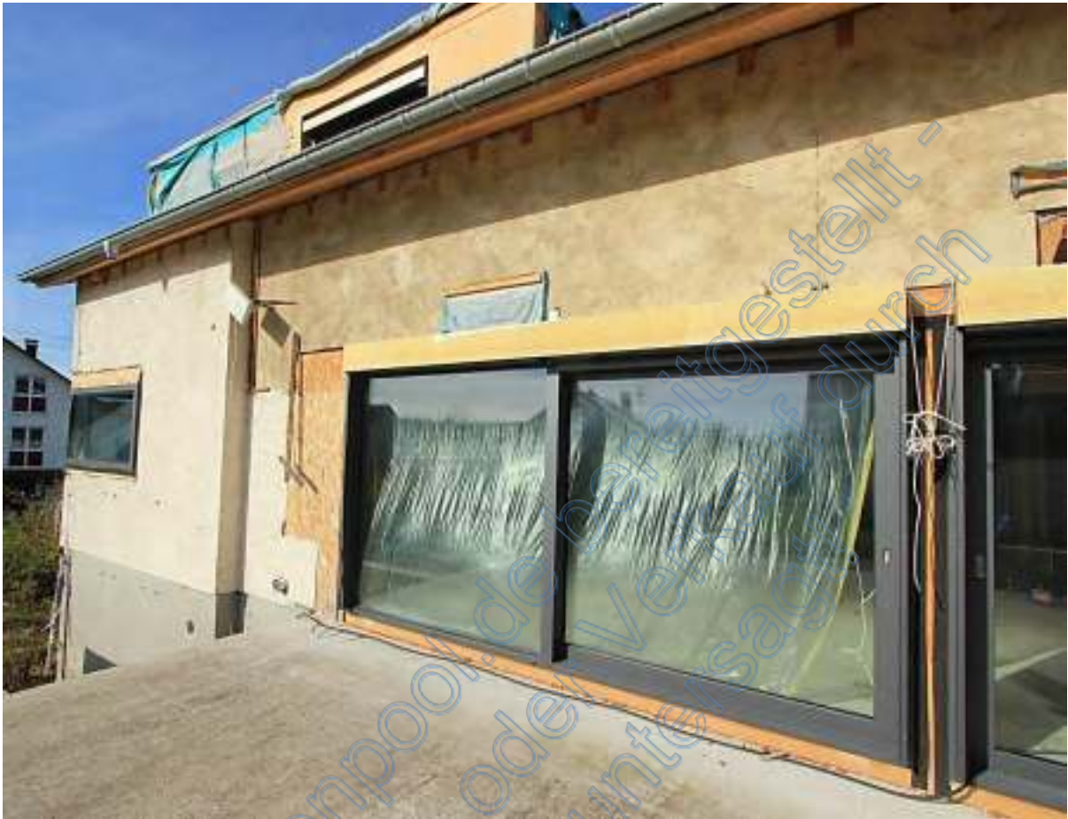
Schiebetür vor dem geplanten Essbereich
