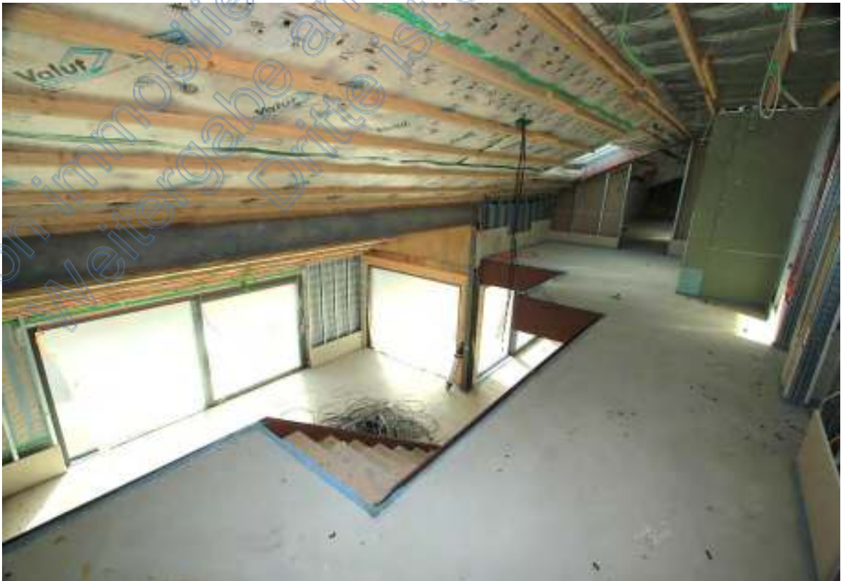
Galerie noch ohne Geländer, Blick nach Westen, links unten Wohnzimmer
