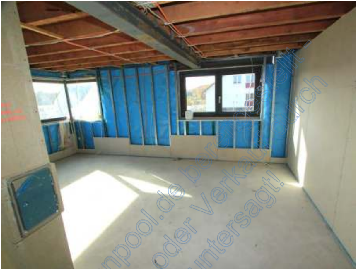
Schlafen/Küche/Essen/Wohnen Gästewohnung mit Holzbalkendecke mit Stahlträger
