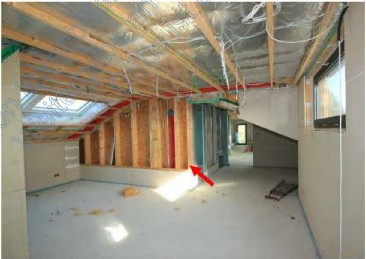
Blick vom Ankleidebereich nach Osten, Pfeil Bad
