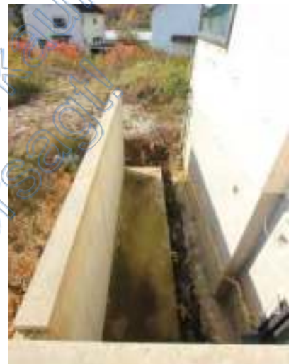
Sichtwand und Zugang zum UG
