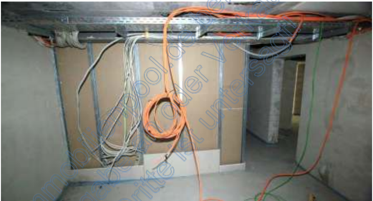
Bunker mit neuer Zwischenwand zum Nebenraum
