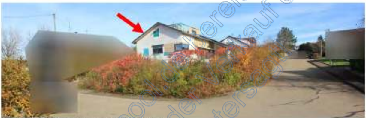
Grundstück mit Wohnhaus von Südwesten
