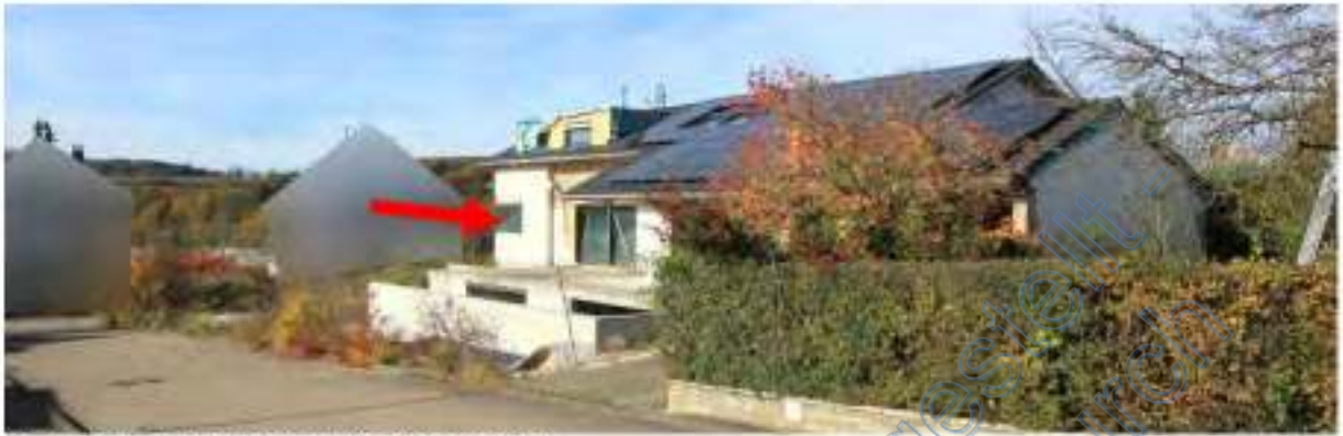
Grundstück von Osten, Pfeil Wohnhaus
