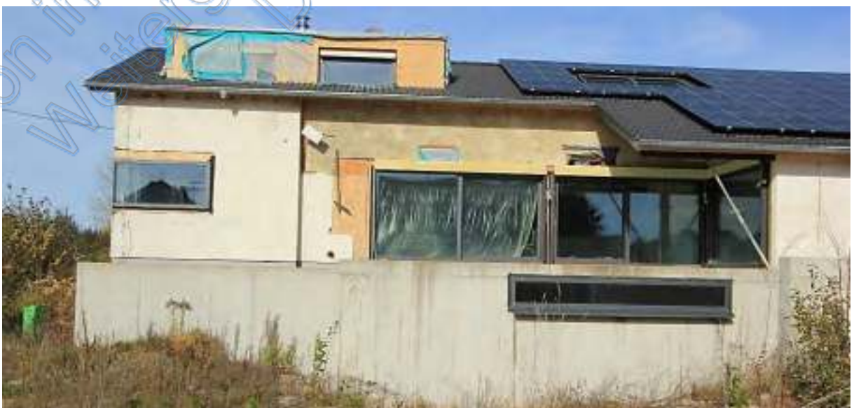
Südseite Wohnhaus mit Kellerwand und Dachgaube
