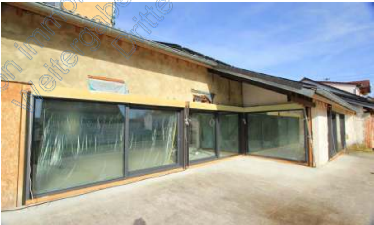
Terrasse EG noch ohne Abdichtung und raumhohe Verglasung des Wohn/Essbereichs
