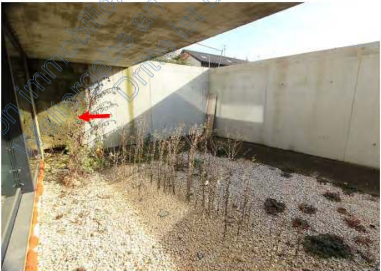
Lichthof und Sichtschutzwand vor dem UG, Pfeil alte Betonwand
