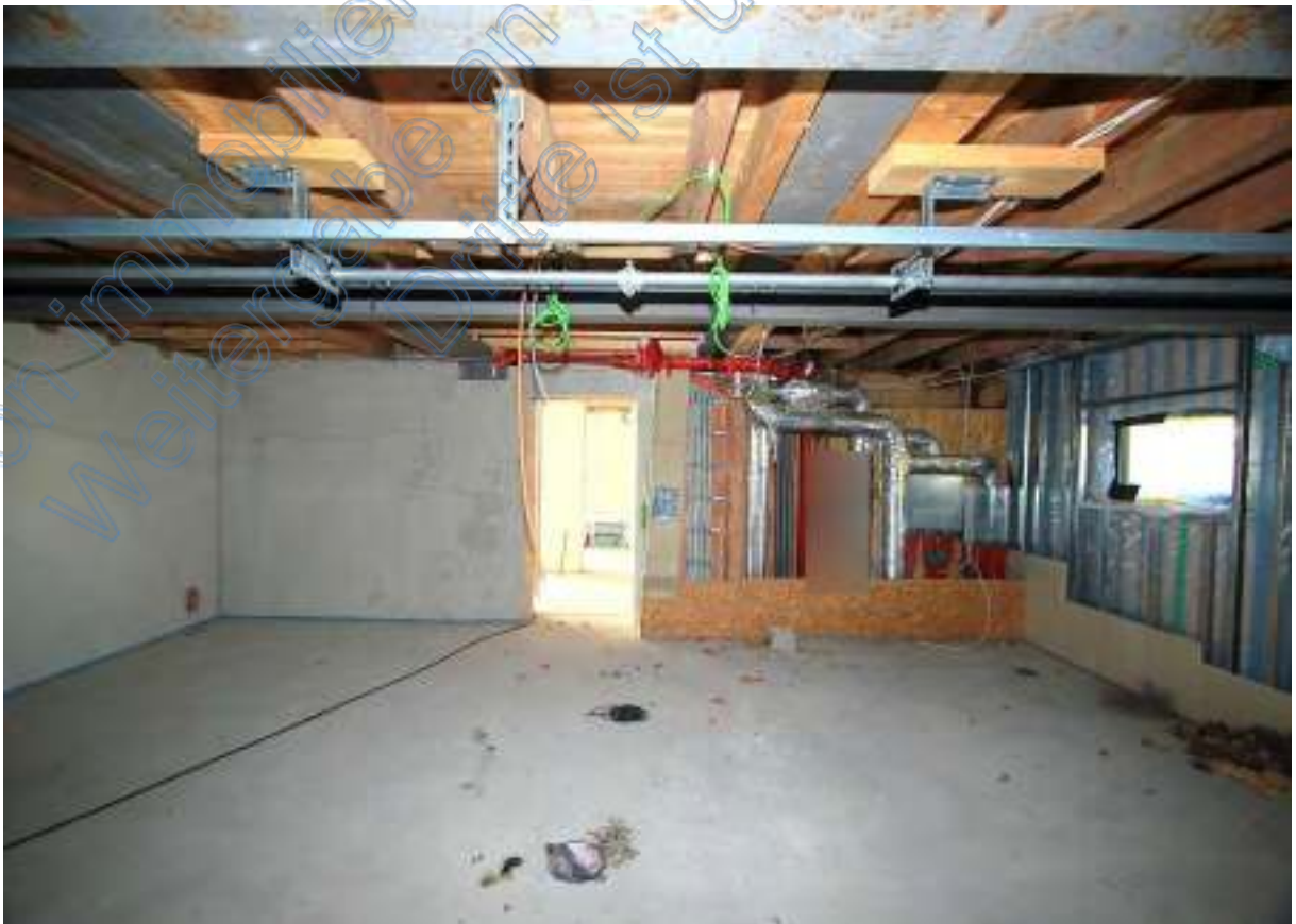
Doppelgarage, Blick nach Westen, hinten Ausgang zum Abstellraum
