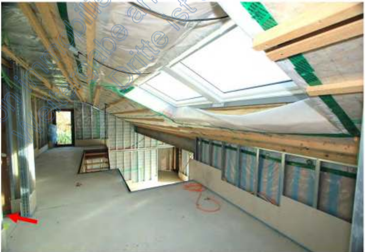
Flur vor der Galerie, Blick nach Osten, Pfeil Zugang Kinderzimmer 2
