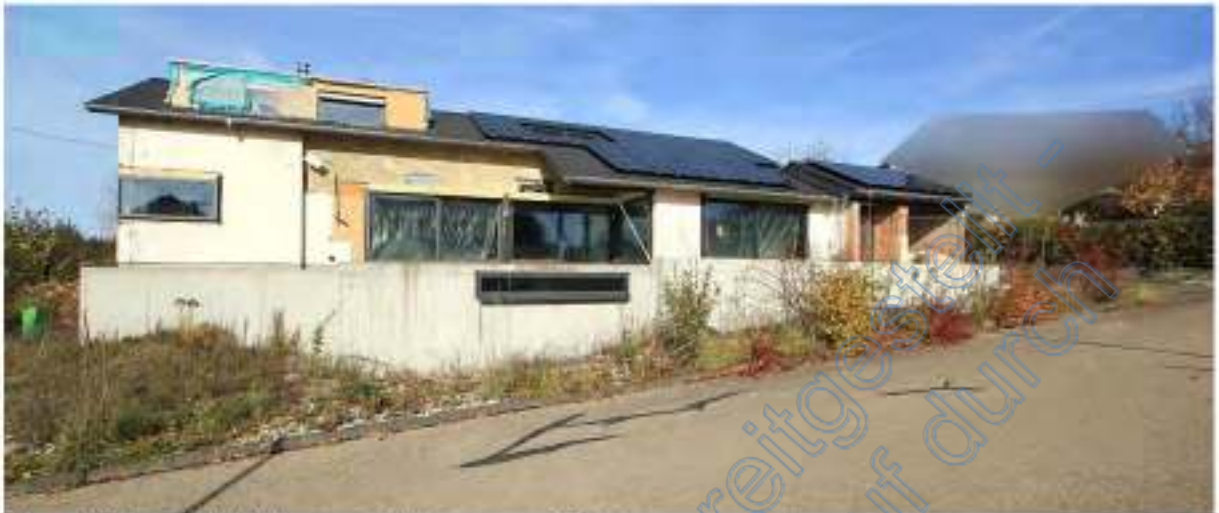
Grundstück mit Wohnhaus im Umbau von Süden
