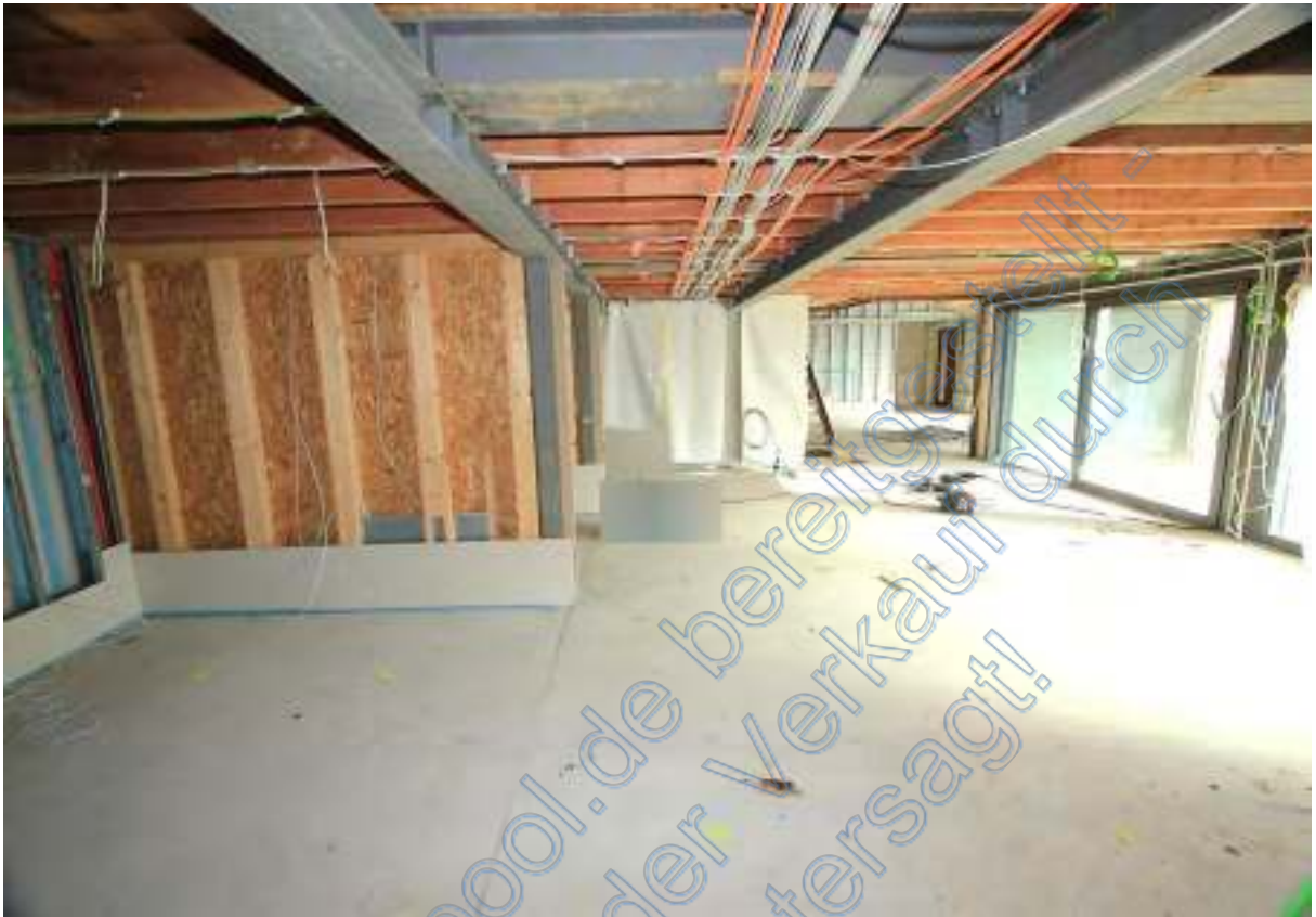
Küche/Essen, Blick nach Osten, links Hauswirtschaftsraum
