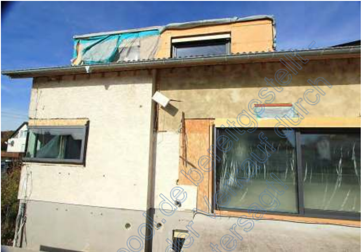
Westliche Südwand Wohnhaus mit unfertiger Dachgaube
