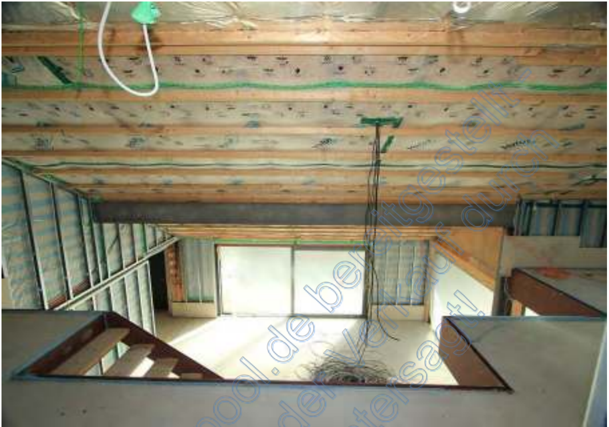
Galerie noch ohne Geländer, Blick nach Süden zum Wohnzimmer im EG
