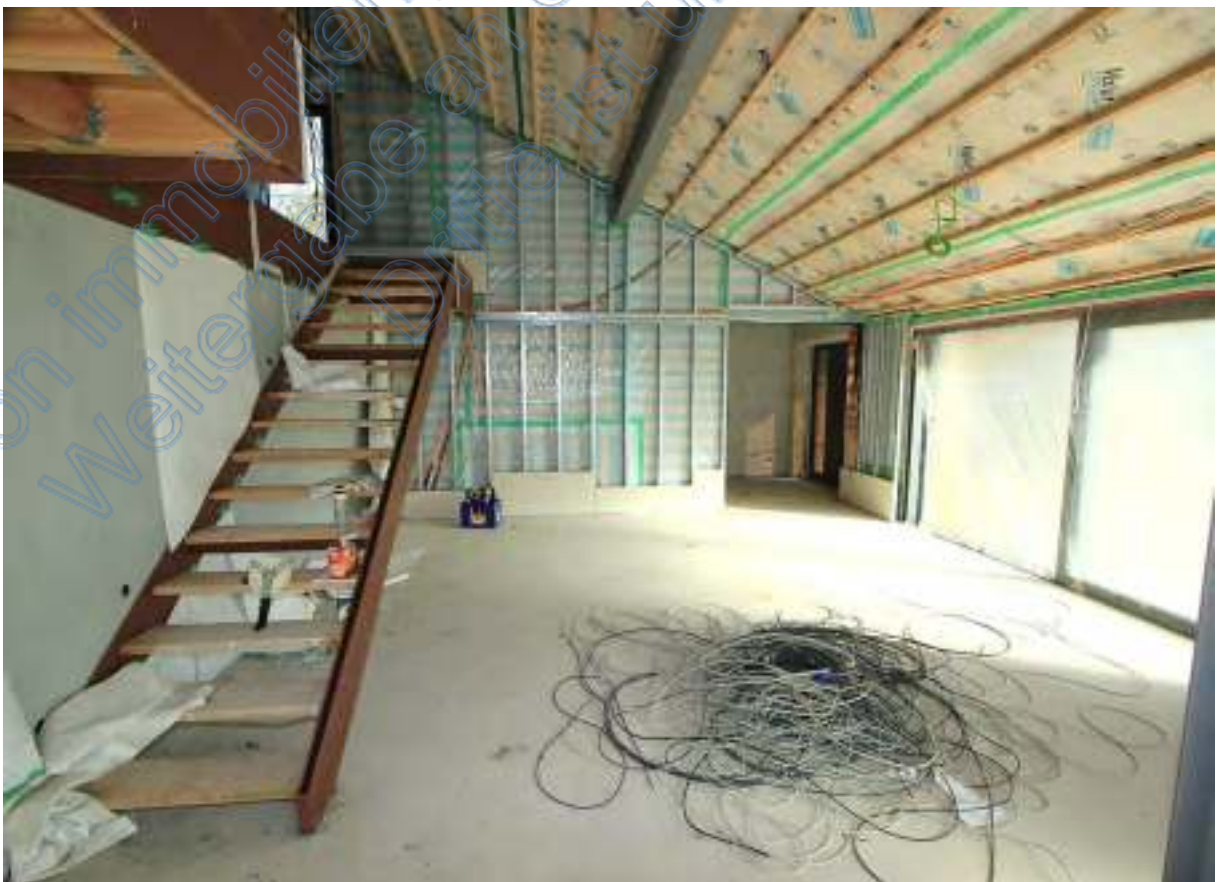
Wohnzimmer mit hoher Decke (Luftraum) und Treppe zur Galerie im DG
