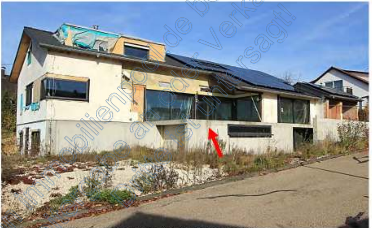
Wohnhaus im Umbau von Süden, Pfeil unterkellertes Terrassenanbau
