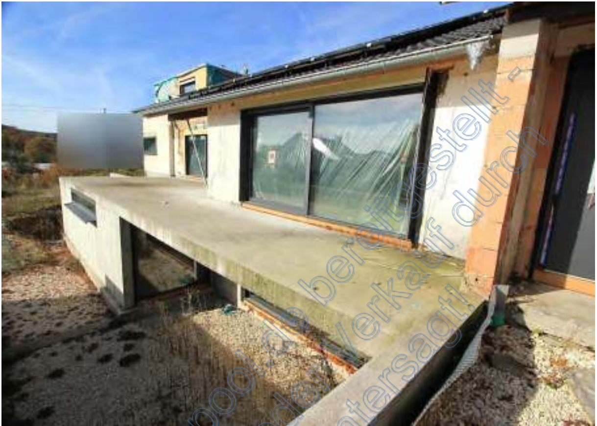
Südseite Wohnhaus mit Terrasse im EG, rechts Hauseingang
