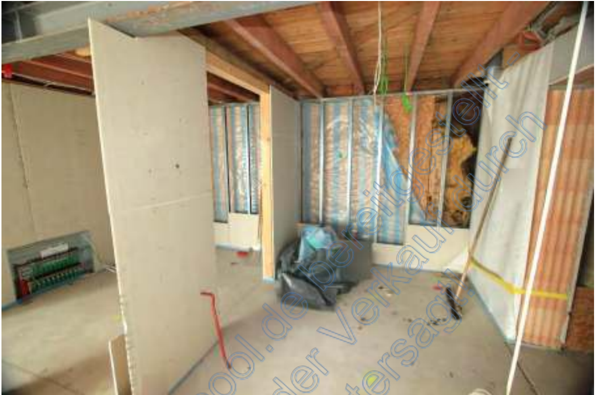
Geplanter Abstellraum mit Durchgang zum Speis (links), rechts Zugang zur Garage
