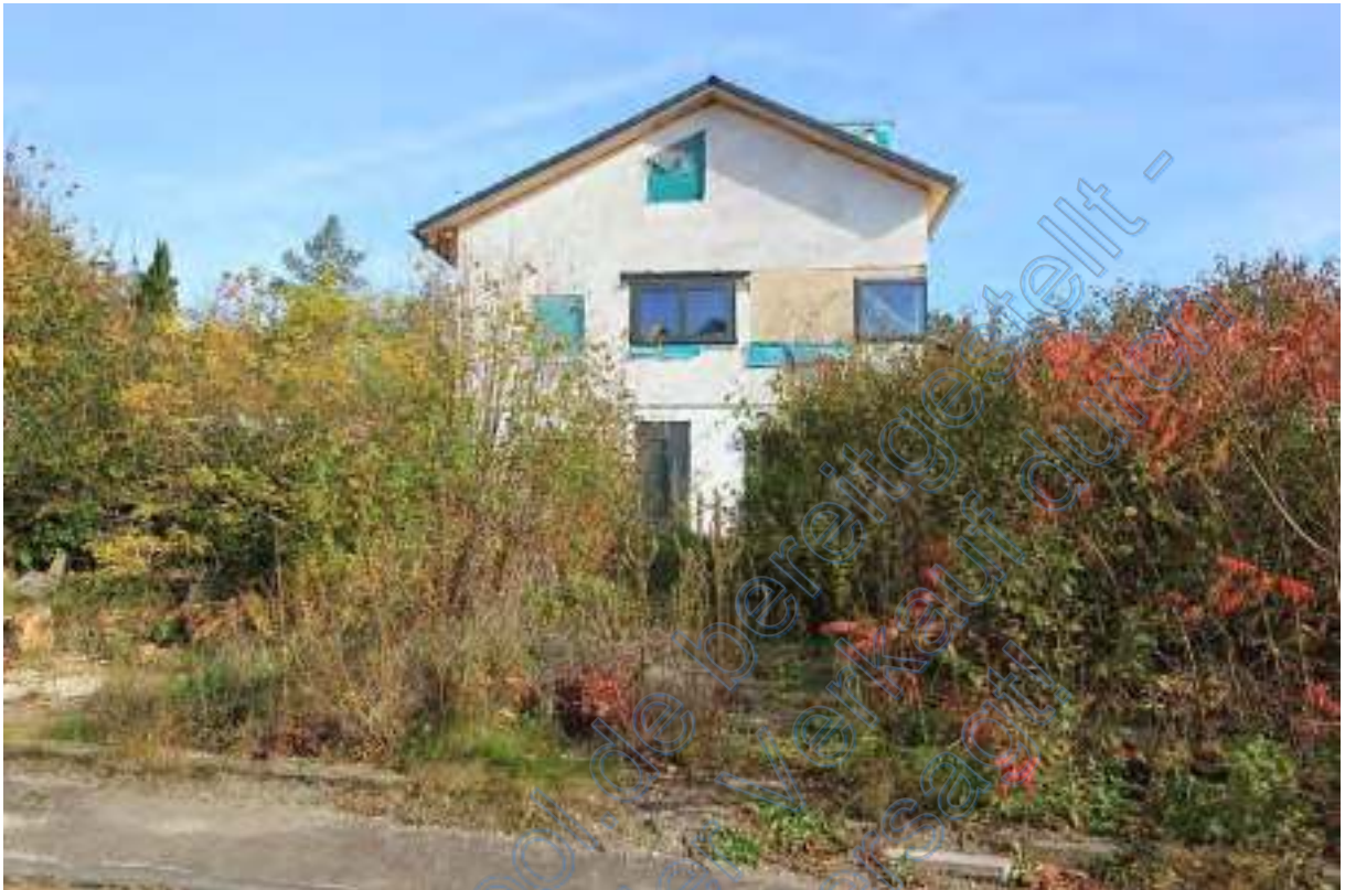
Grundstück mit Wohnhaus von Westen
