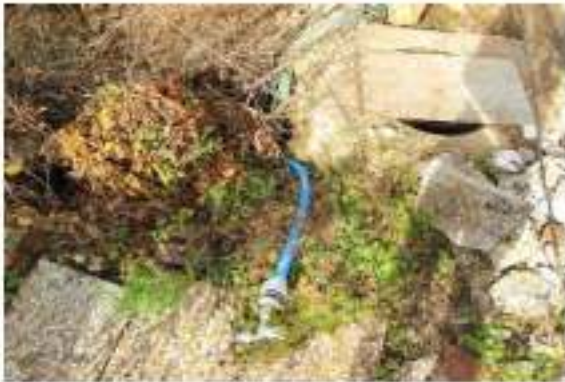
Wasserschlauch im Westen
