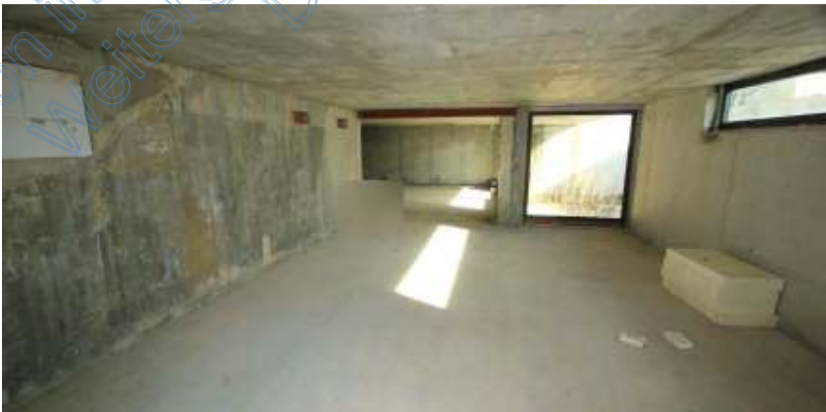
Kellerraum unter Terrasse EG, Blick nach Osten, hinten Wellnessraum
