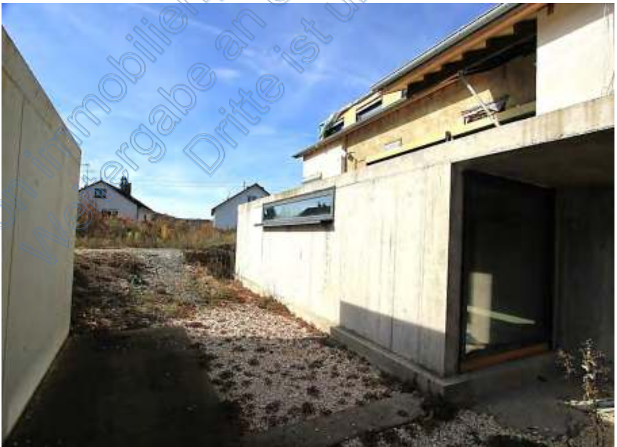
Lichthof und Sichtschutzwand vor dem UG, rechts Keller unter der Terrasse EG
