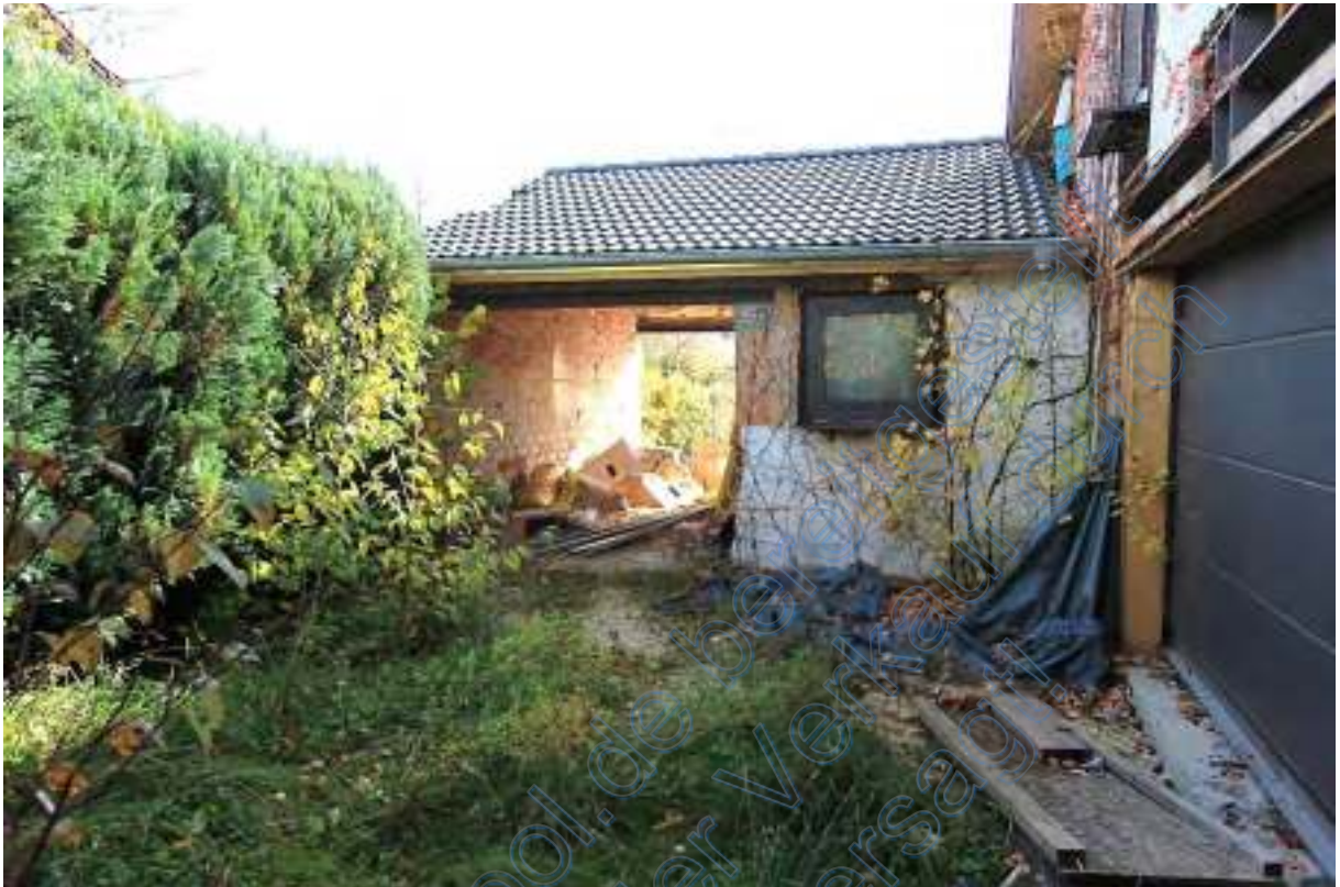
Nordseite Durchfahrt und Eingang Wohnhaus, rechts Doppelgarage
