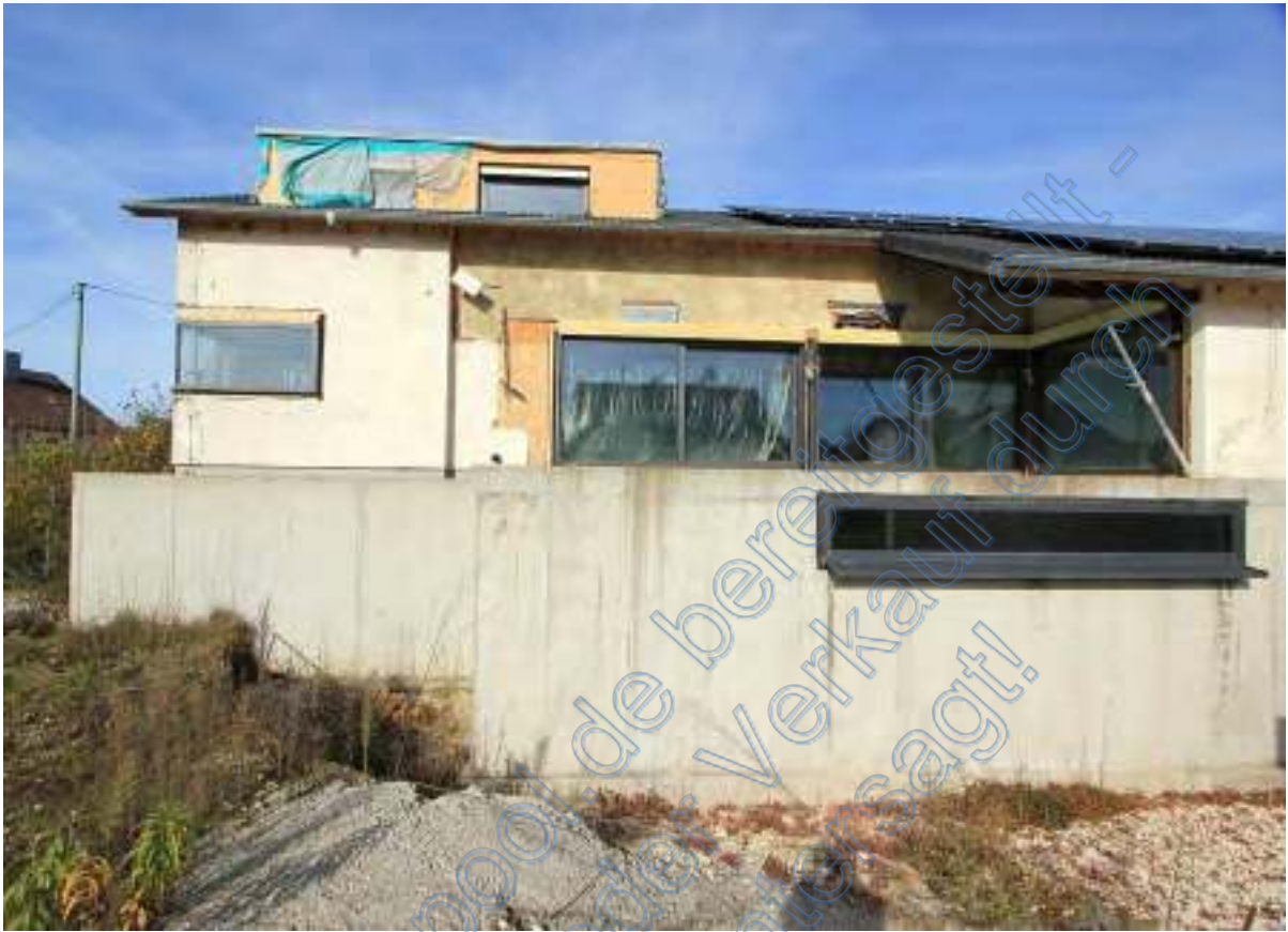
Westliche Südwand Wohnhaus mit Kellerraum unter der Terrasse
