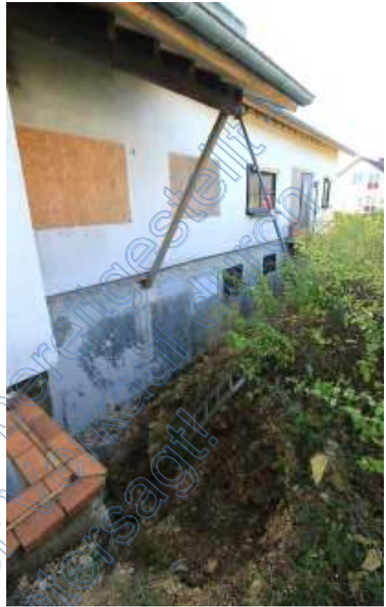
Graben vor der Nordseite Wohnhaus
