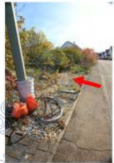
Gelände am Straßenrand
