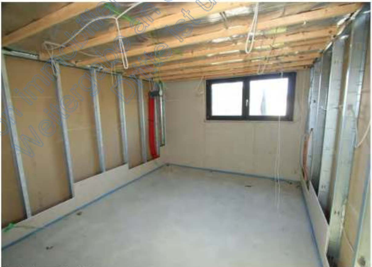
Kinderzimmer 2 im Norden
