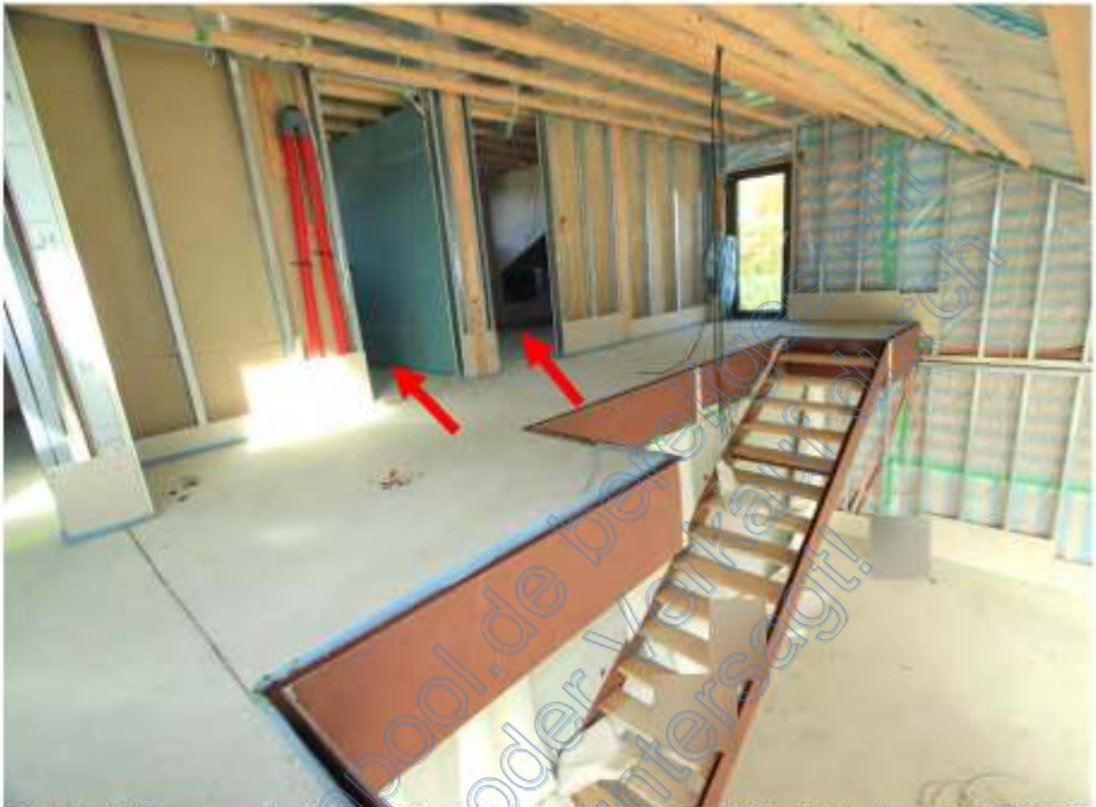
Galerie mit Treppe noch ohne Geländer, Blick nach Nordosten, Pfeile Kinderzimmer 1 mit Bad
