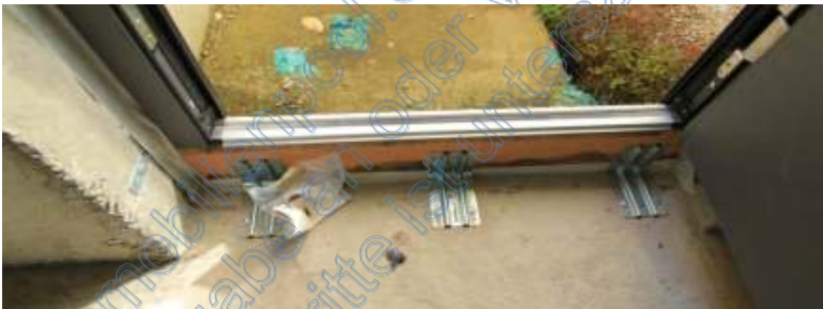
Ausgang Kellerraum unter Terrasse EG
