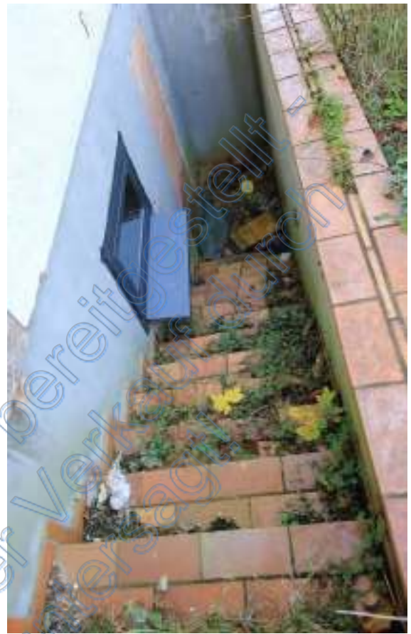
Alte stillgelegte Kelleraußentreppe
