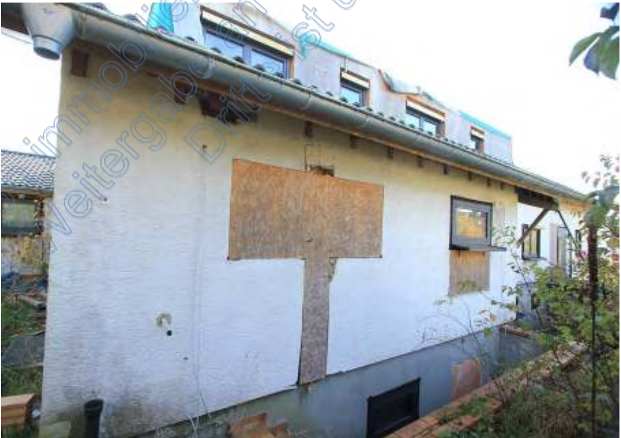
Nordfassade Doppelgarage im Wohnhaus, unten alte Kelleraußentreppe
