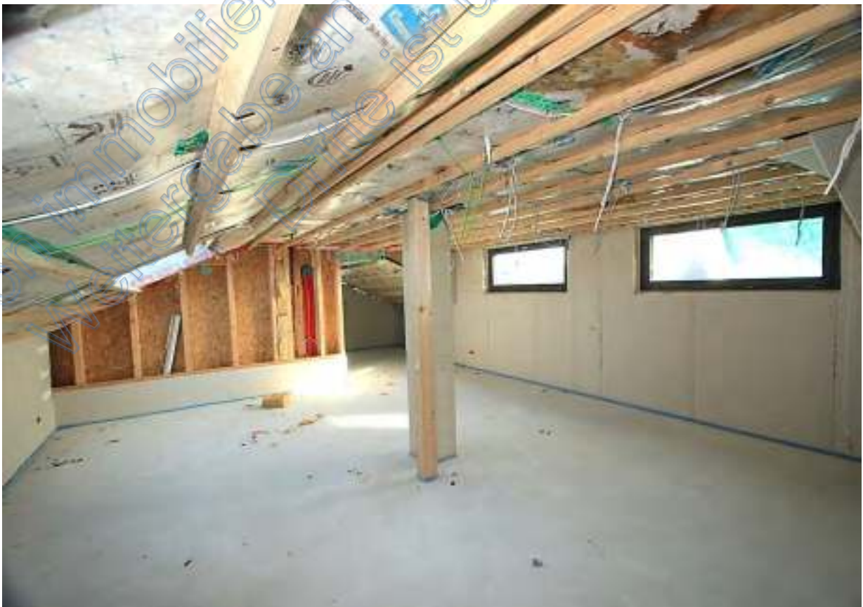
Blick vom Schlafbereich nach Osten zum geplanten Ankleidebereich vor der Badwand
