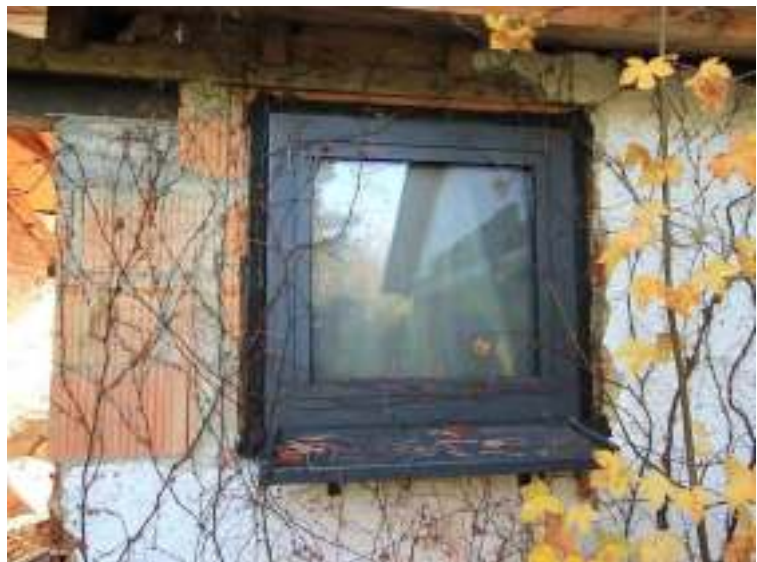
Fenstereinbau im Eingang Wohnhaus
