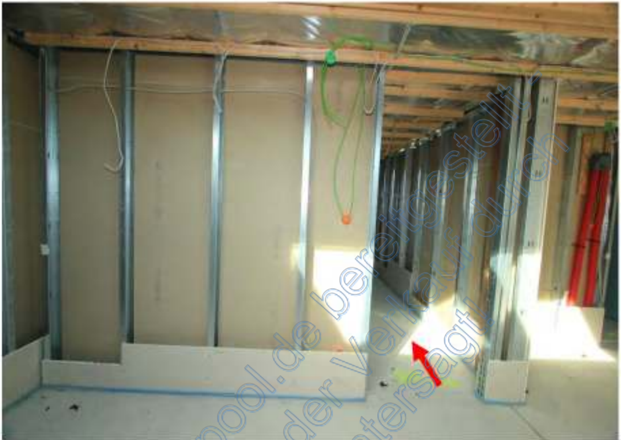
Flur vor der Galerie, Blick nach Norden, Pfeil Zugang Kinderzimmer 2
