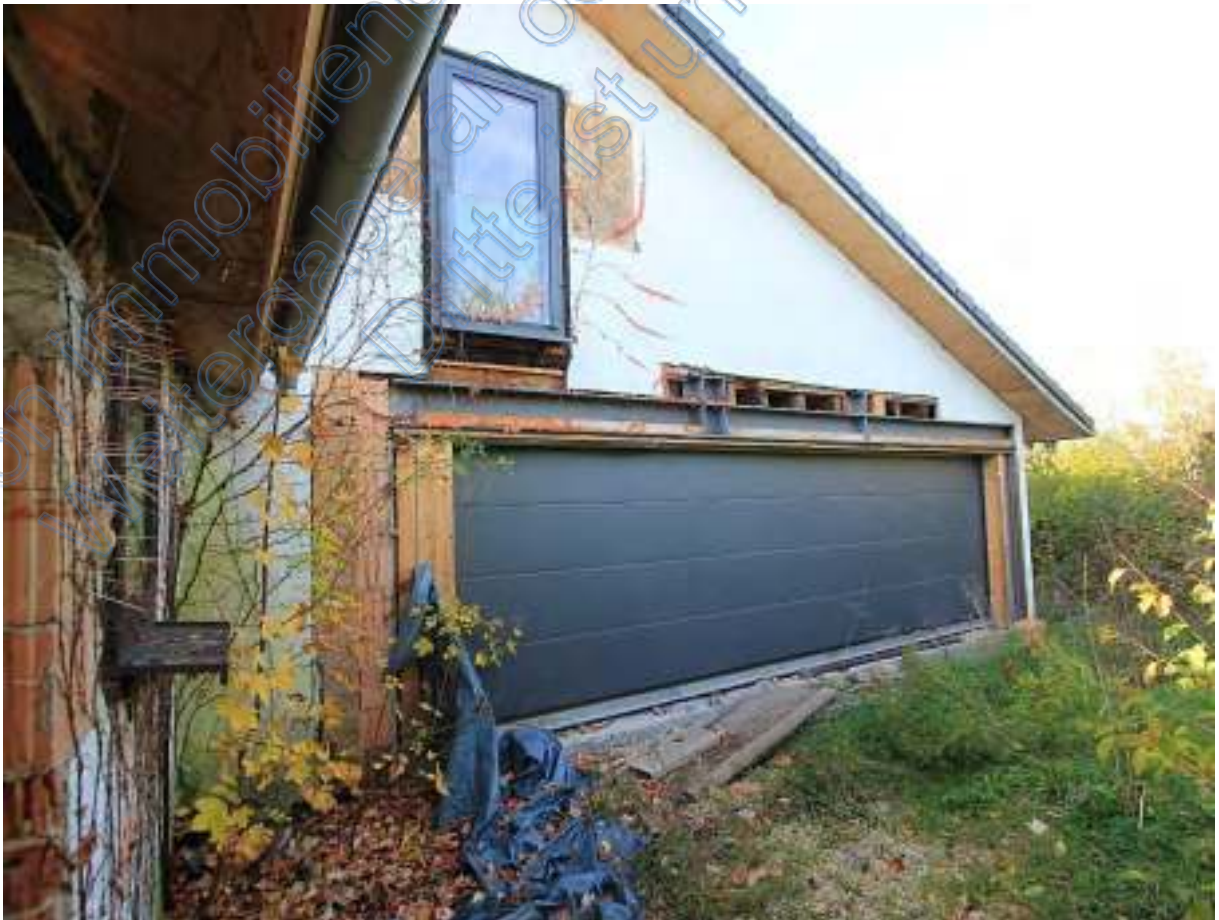
Ostseite des Gebäudes mit Sektionaltor der Doppelgarage
