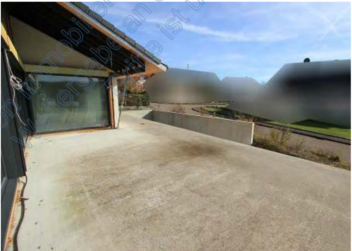
Terrasse EG noch ohne Abdichtung, Blick nach Osten
