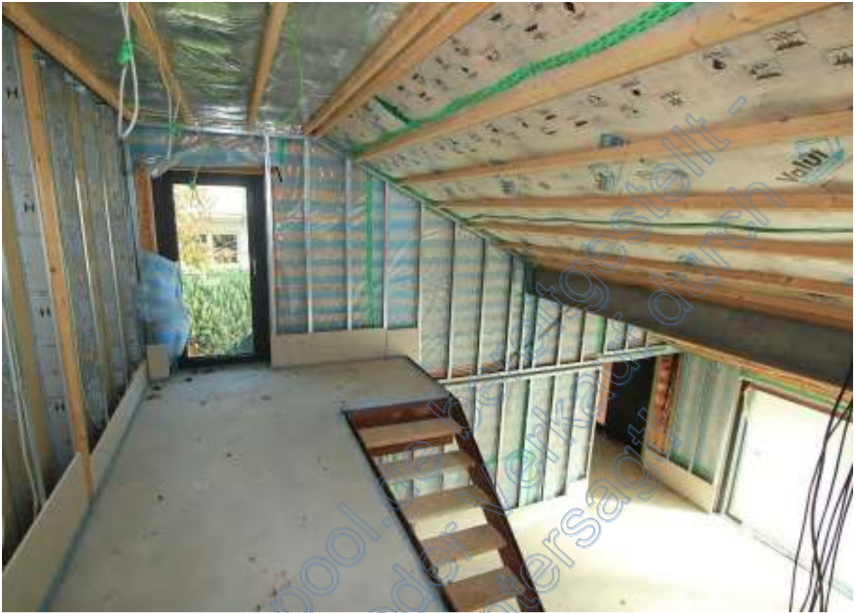
Galerie, Blick nach Osten, rechts unten Wohnzimmer
