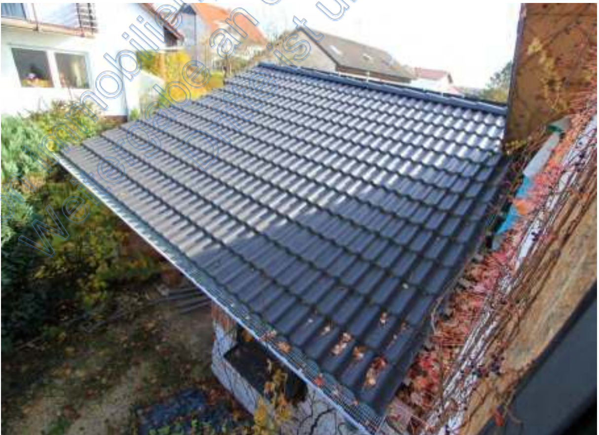
Dach der Durchfahrt und des Haupteingangs im Osten von oben
