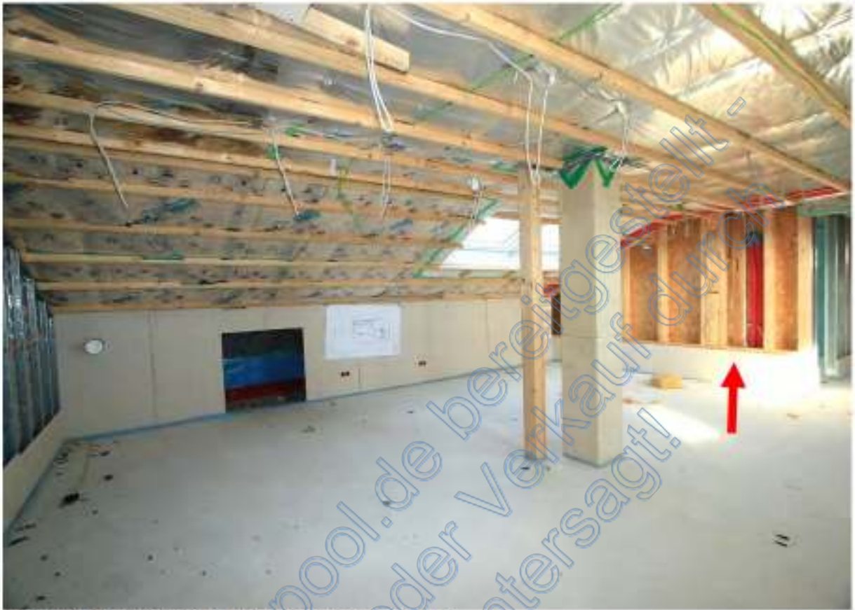
Blick vom Schlafbereich nach Nordosten, Pfeil Bad
