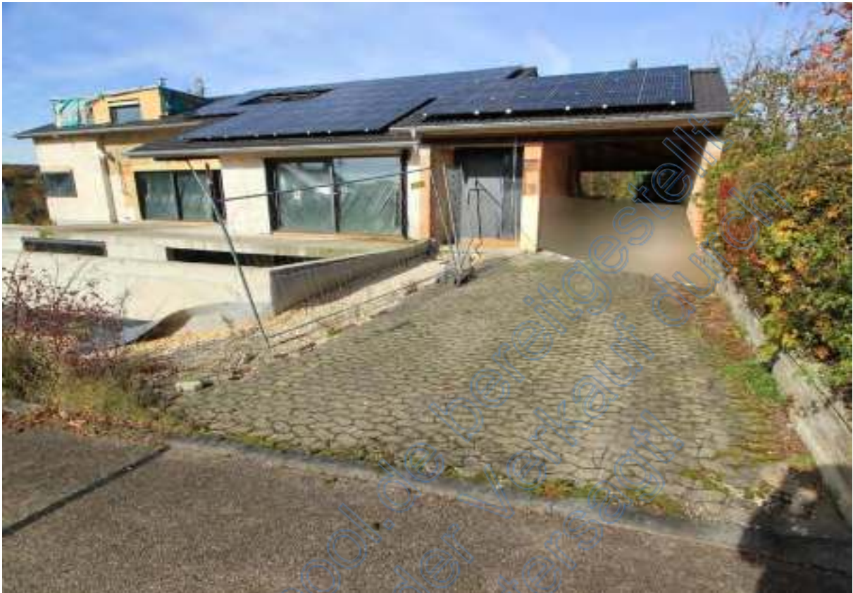
Wohnhaus mit (noch alter) Garagenzufahrt von Südosten, PV-Anlage auf dem Dach
