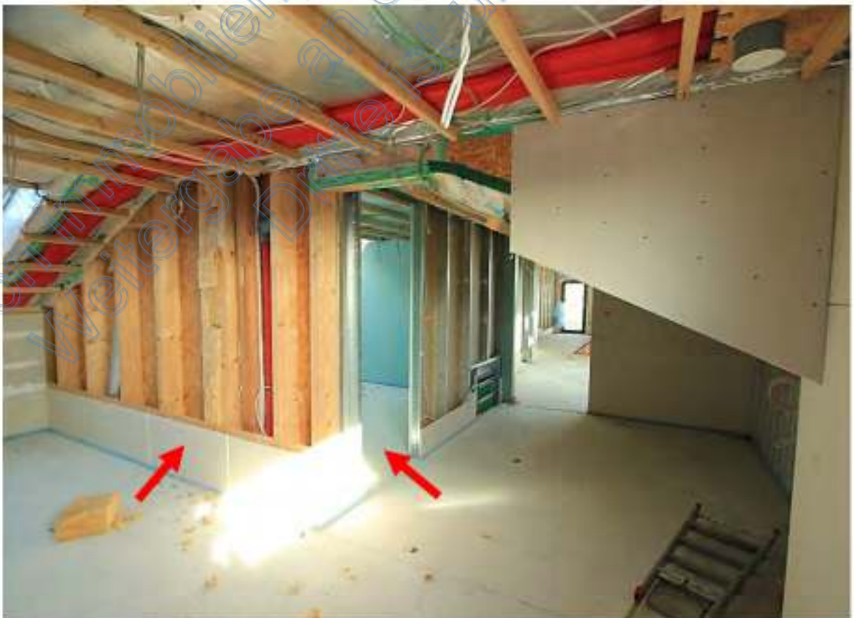
Blick zum Elternbad (Pfeile), rechts Zugang zur Master Suite
