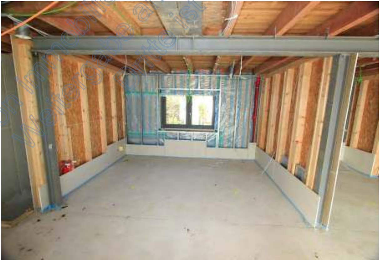
Hauswirtschaftsraum im Norden im Bau
