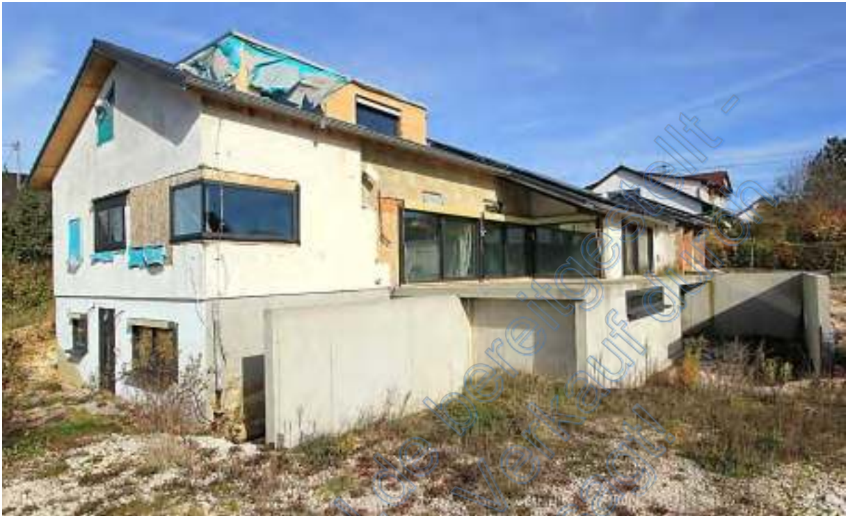
Wohnhaus mit Betonwänden im UG von Südwesten
