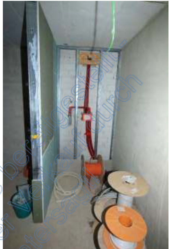
Geplante Dusche vor dem Saunaraum
