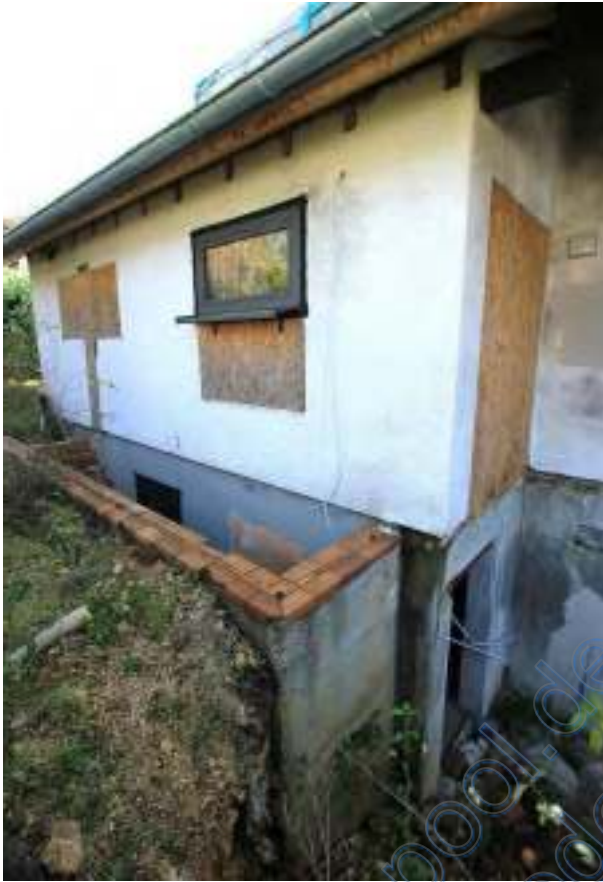
Nordseite Doppelgarage, davor alte Kellertreppe
