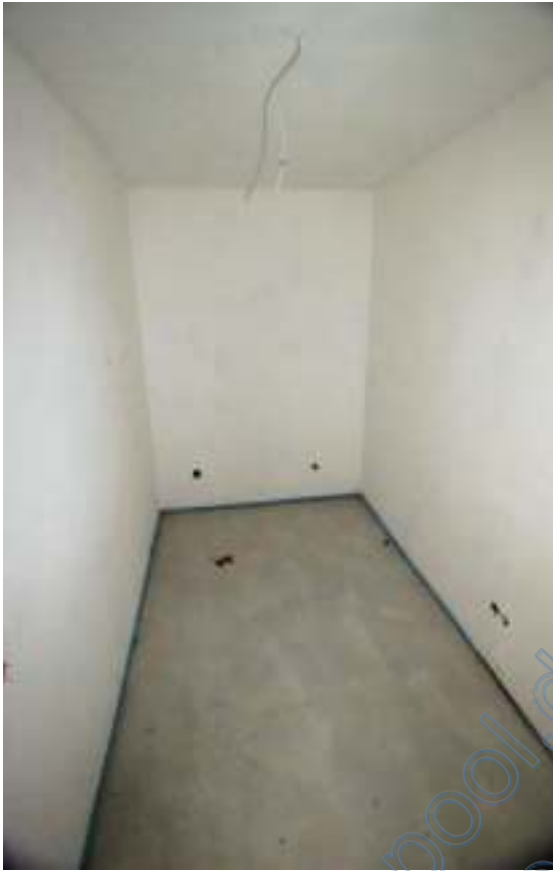
Abstellraum als Durchgangsraum
