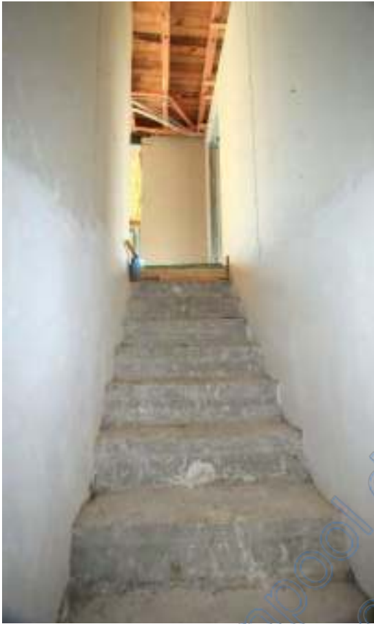
Treppe zum EG (Kellertreppe)
