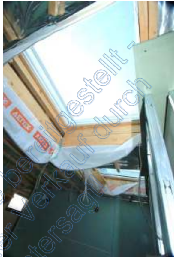
Dachfenster im Bad
