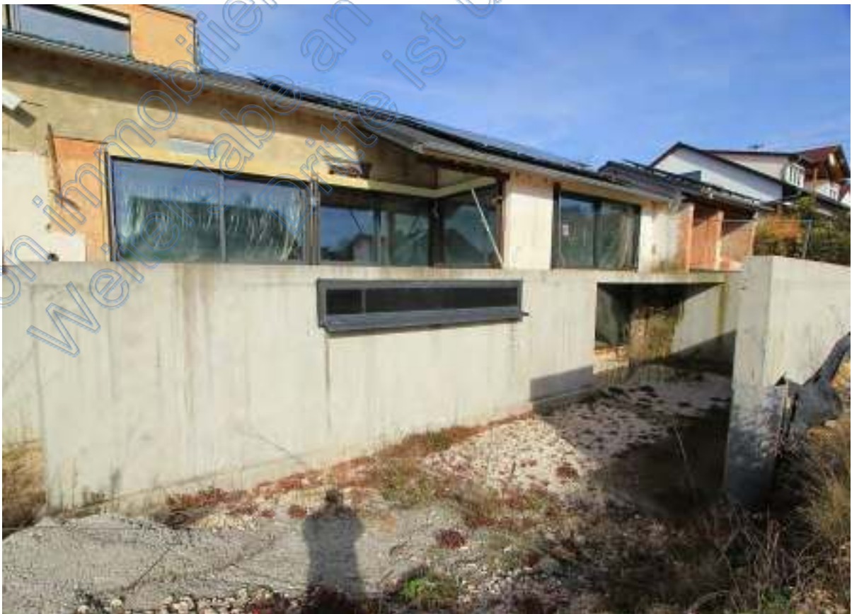
Wohnhaus von Südwesten mit Lichthof und Sichtschutzwand vor dem UG
