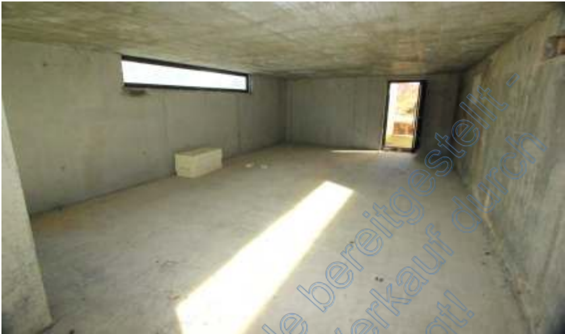
Kellerraum unter Terrasse EG, Blick nach Westen, hinten Ausgangstür
