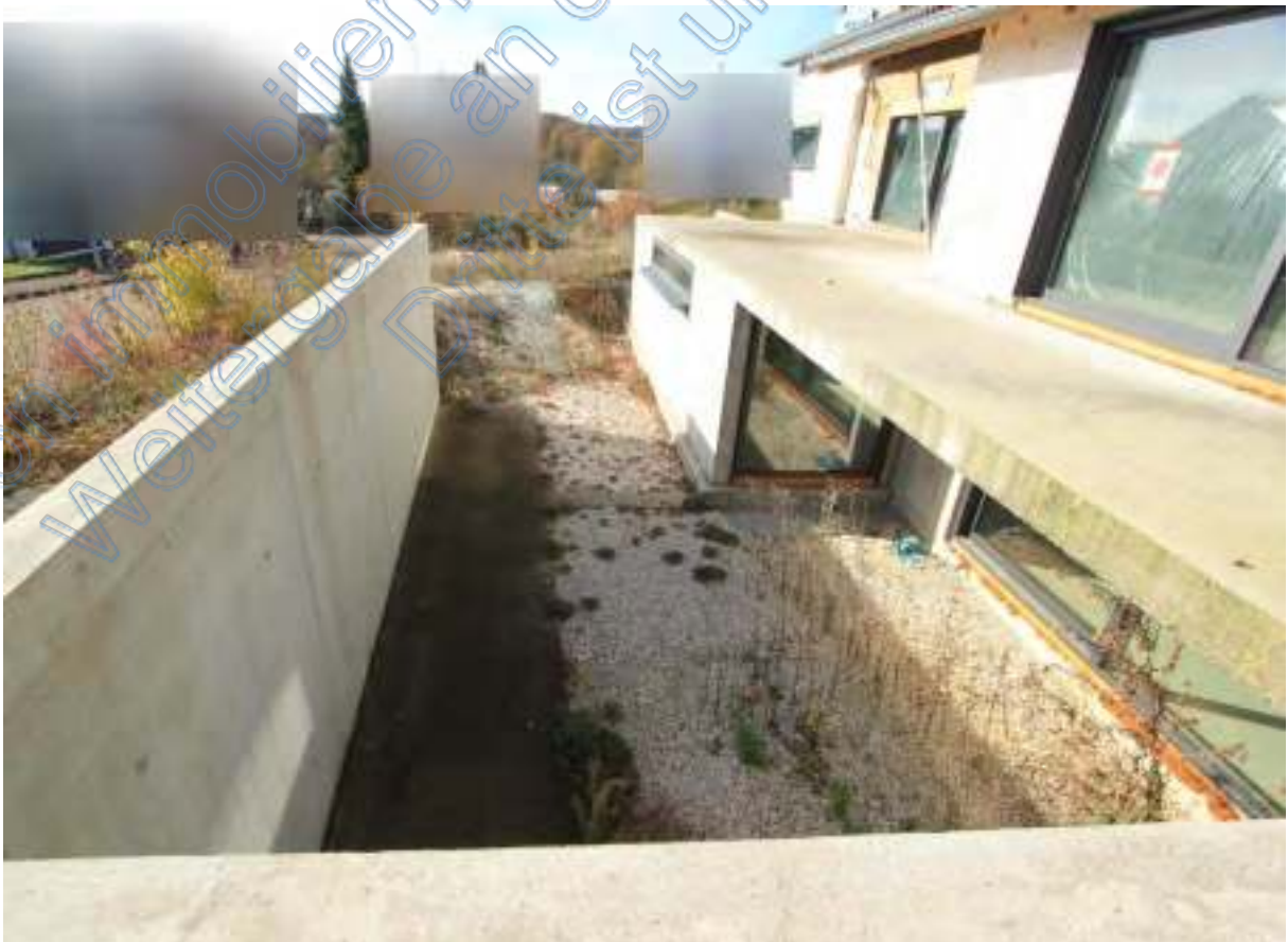
Blick nach Westen zum Lichthof im UG, rechts Terrasse EG
