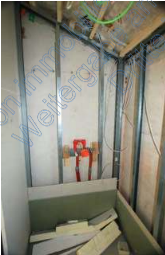
Gäste-WC im Ausbau
