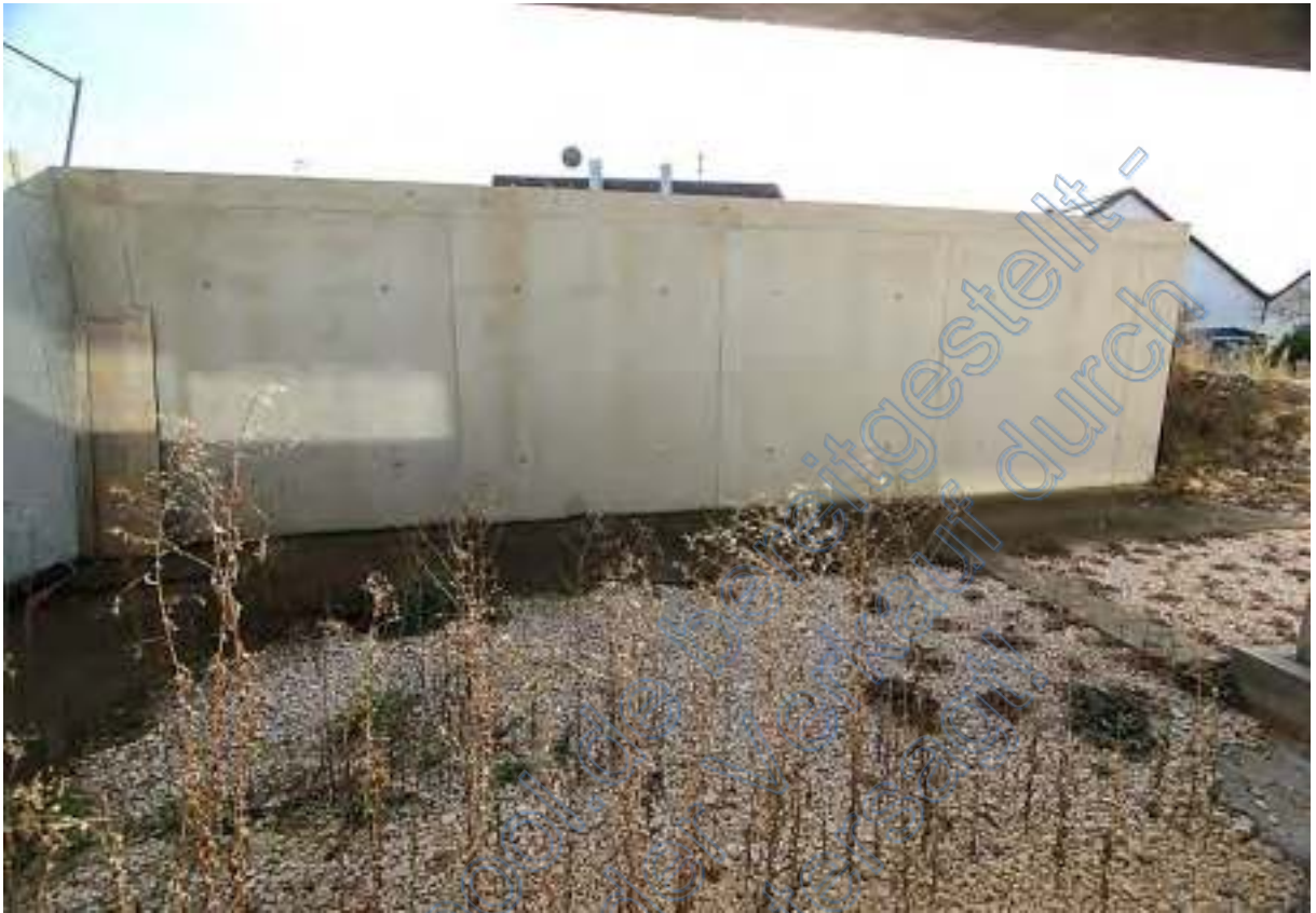
Lichthof und Sichtschutzwand vor dem UG, Blick nach Süden
