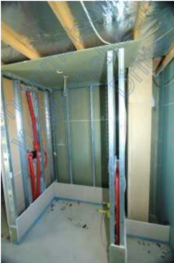
WC-Bereich im Kinderbad
