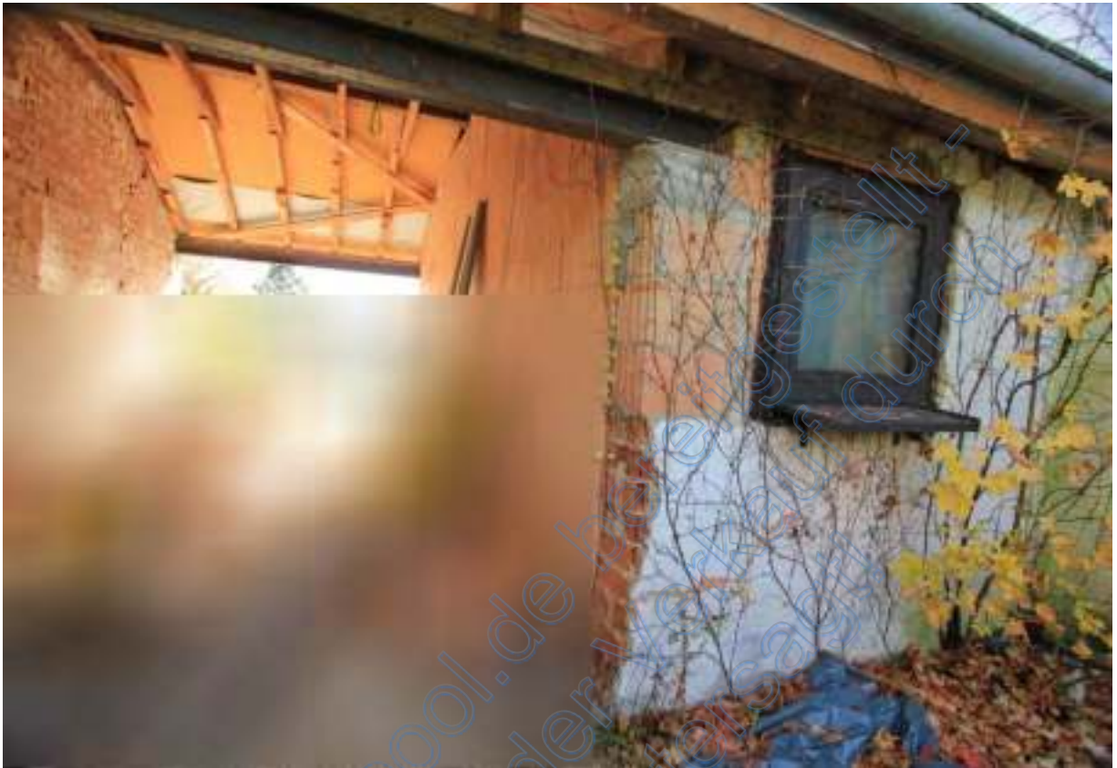
Durchfahrt im Osten von Norden, rechts Eingangsbereich Wohnhaus
