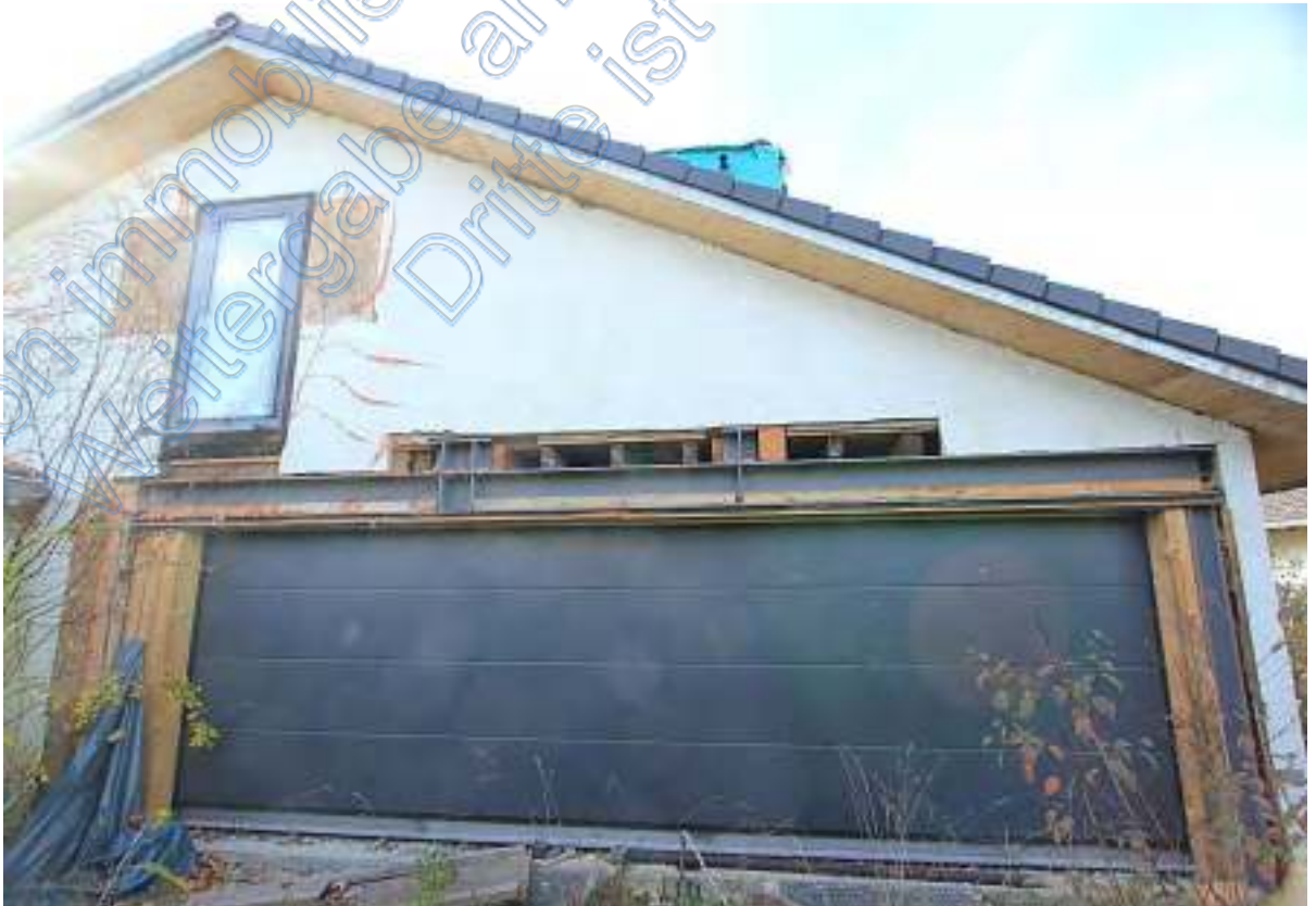
Ostseite des Gebäudes mit Doppelgaragen-Sektionaltor
