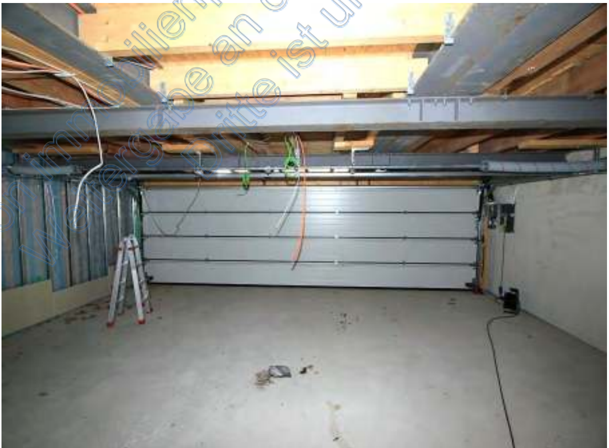
Doppelgarage, Blick nach Osten zum Sektionaltor, Decke mit Stahlträger
