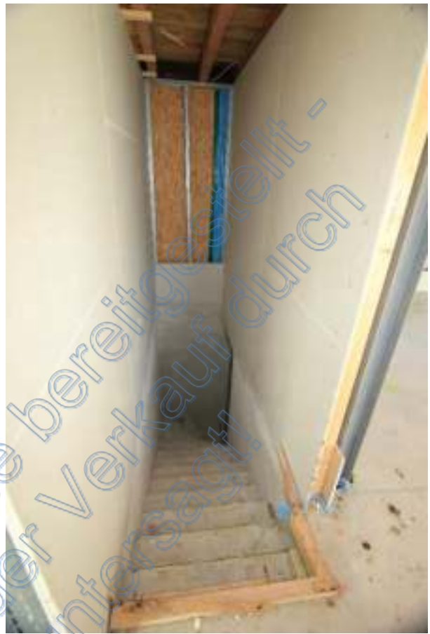
Treppe zum UG von oben (Kellertreppe)
