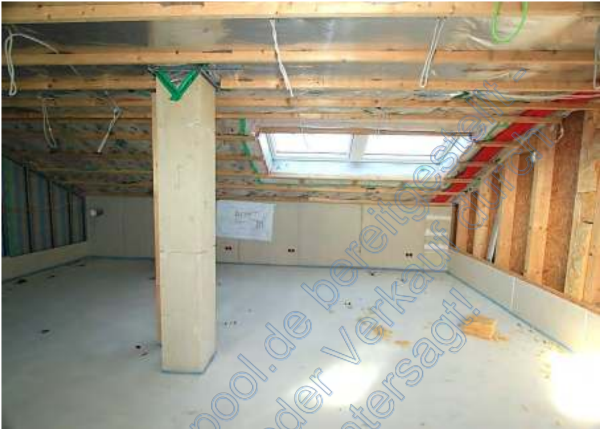
Links Schlafbereich, rechts geplante Ankleide neben der Badwand, Blick nach Norden
