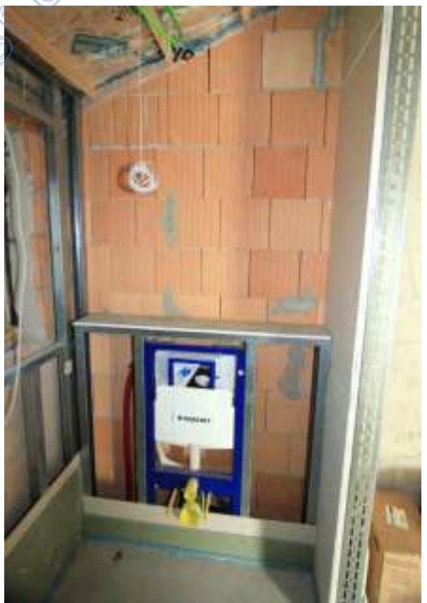
Gäste-WC im Ausbau
