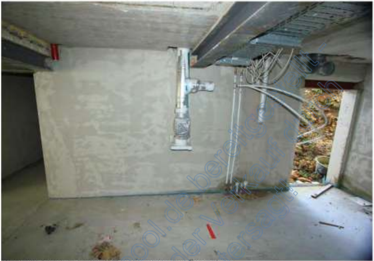
Heizungsraum mit offenem Ausgang im Norden, links Flur
