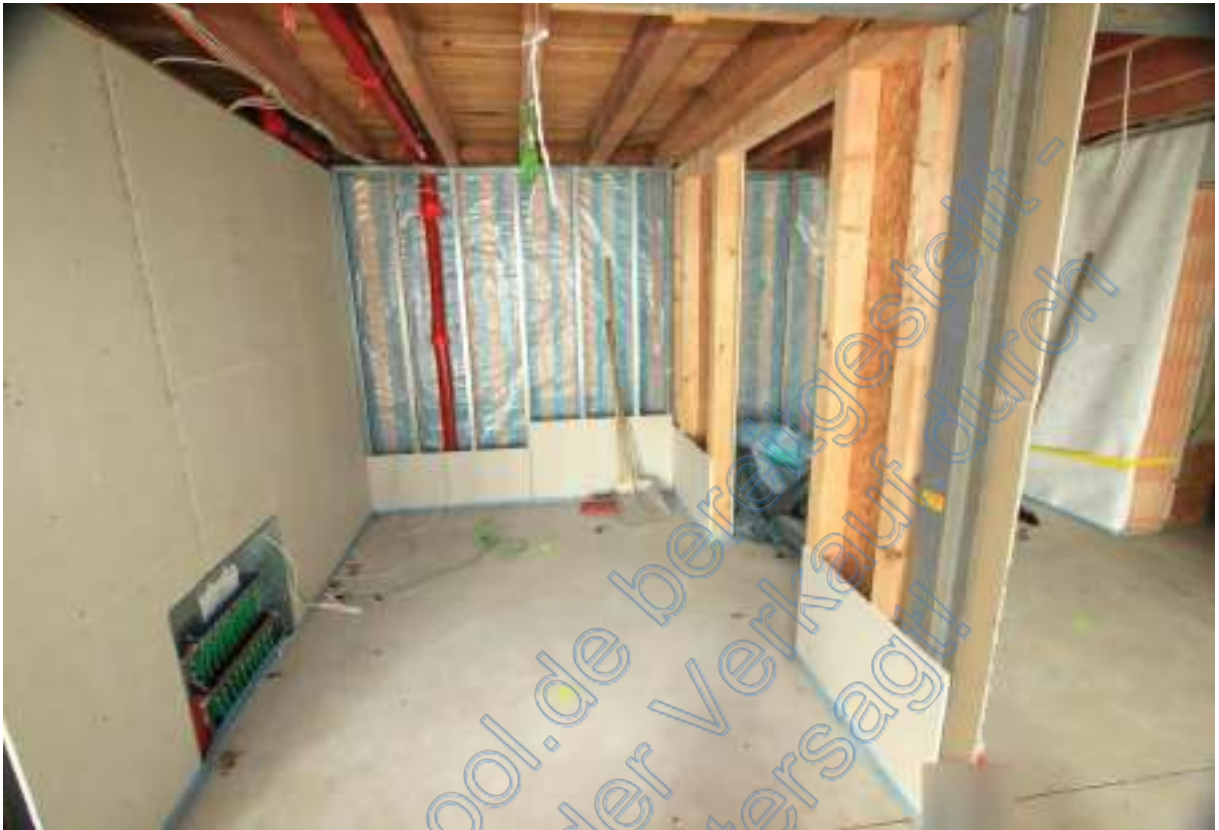
Geplanter Speis, Einbauschränke fehlen noch
