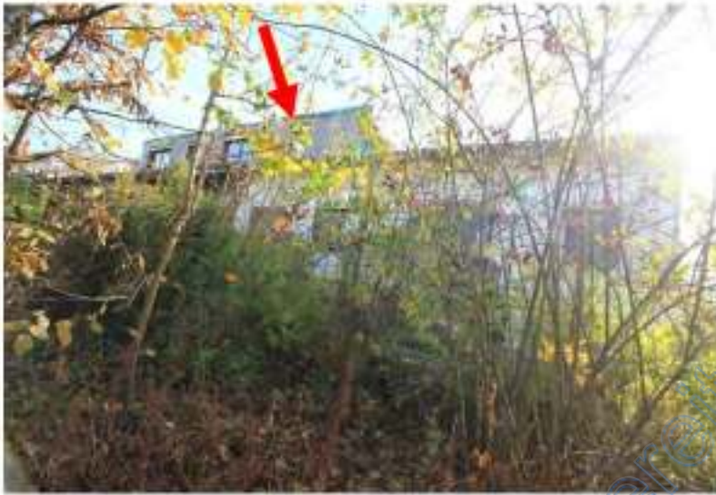
Blick von Nordwesten, Pfeil Wohnhaus
