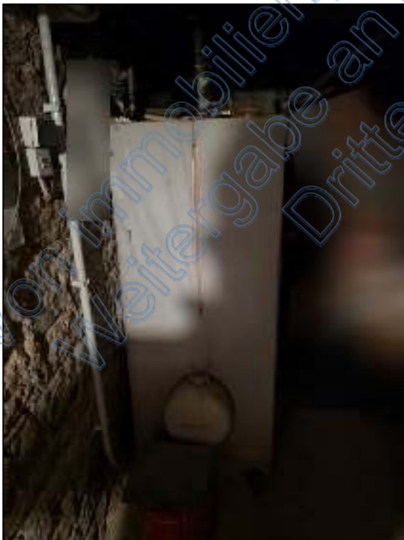
Warmwasserspeicher
