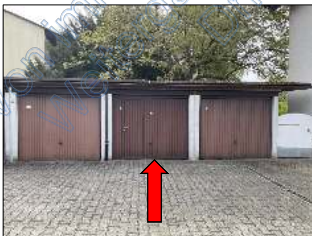
Außenansicht Garage Nr. 18.
