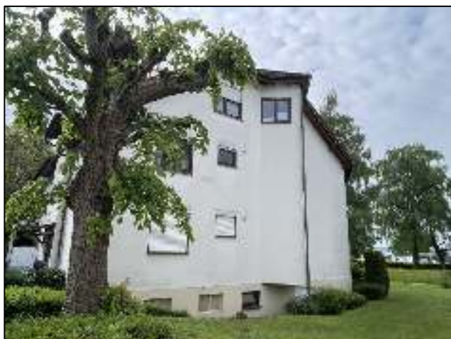
Außenansicht Haus A aus Nord-West.
