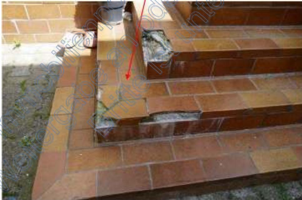
Bild 12: schadhafter Plattenbelag
