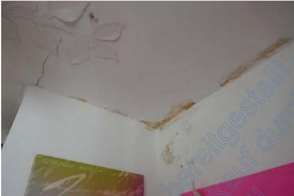
Bild 9: Feuchtigkeitsschaden Treppenhaus linkes Wohngebäude (Decke zum Dachspitz)
