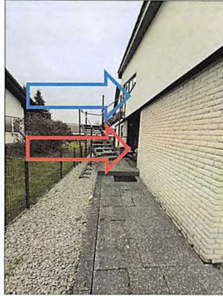
Foto Nr.: 18 Außenbereich entlang der nordwestlichen Giebelwand (roter Pfeil zur Haustür der Wohnung 1, blauer Pfeil zur Haustür der Wohnung 2)
