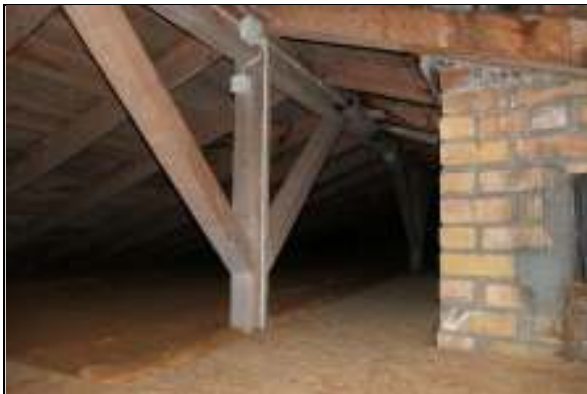
Dachraum (keine Stehhöhe, Dämmung Decke OG)
