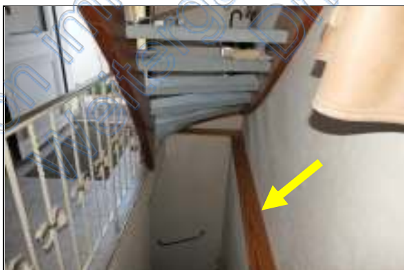
Bereich UG-EG (Mauerabsatz wg. Wandstärke)
