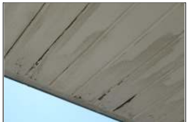
Durchfeuchtung Balkonunterseite
