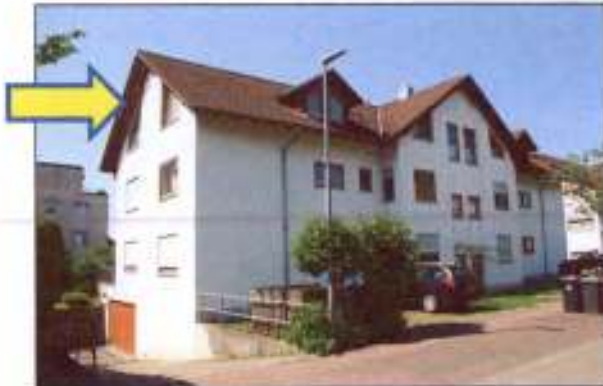
Blick von Nordosten
