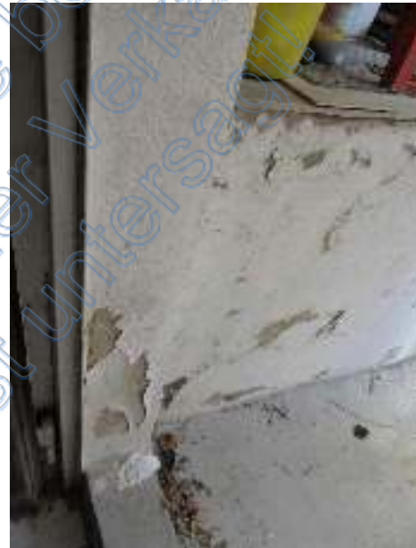
Putz-/Anstrichschäden Fassadenbereich
