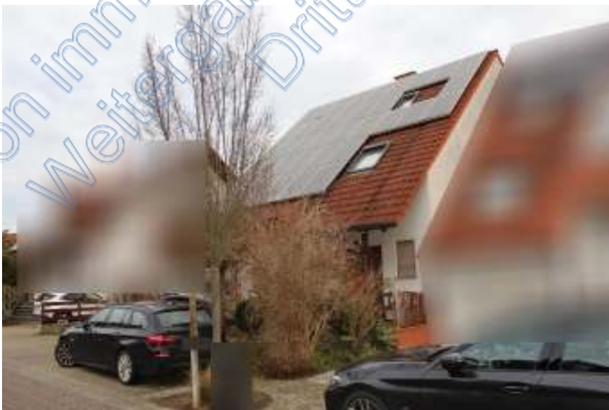
Foto 2: Blick auf das Einfamilienhaus von der Straße "In der Holzrott" aus
