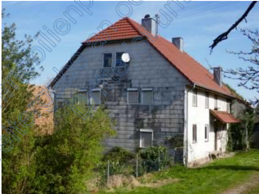
Bild 2: Wohngebäude mit Ansicht von Süden
