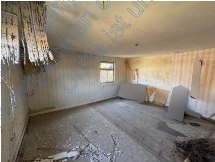
Bild 12: Zimmer im Obergeschoss
