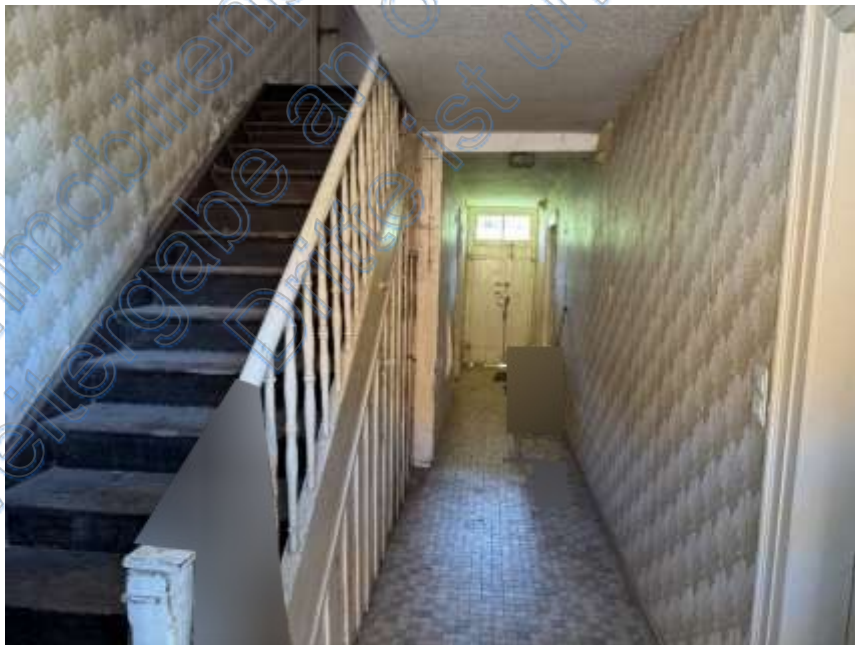
Bild 4: Flurbereich im Erdgeschoss mit Treppe zum Obergeschoss
