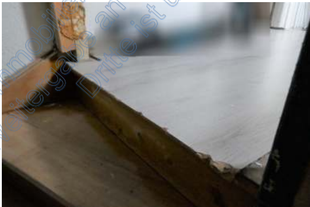
Auch im Dachgeschoss sind die Fußböden unfachmännisch verlegt.
