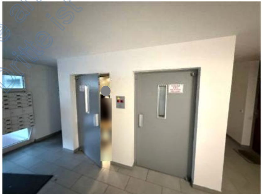
Foto 4 des SV: Treppenhaus, Personen-Aufzüge (EG); Anonymisierung d.d. SV
