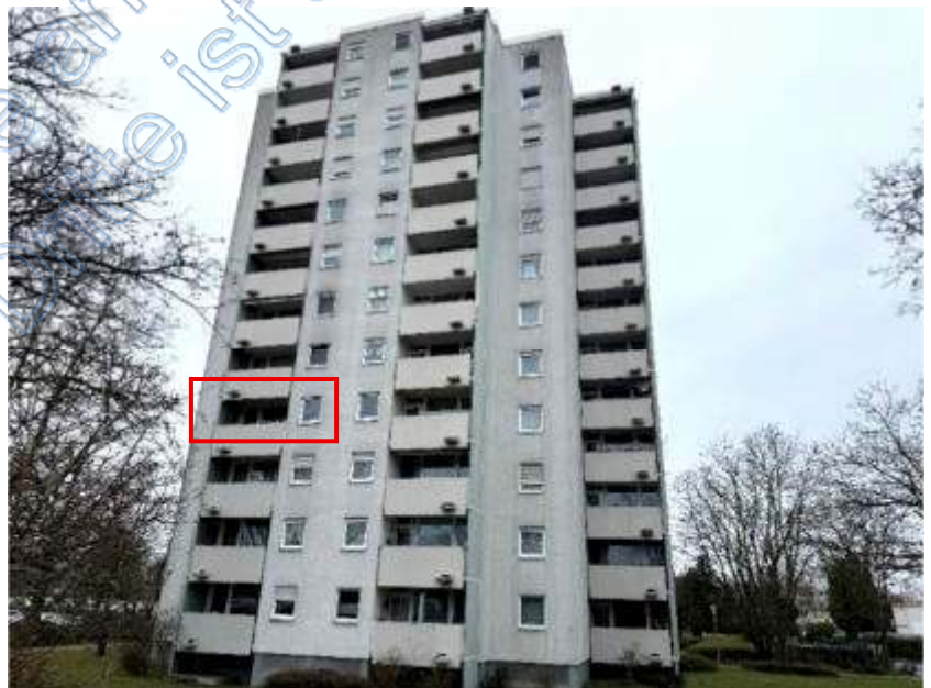
Foto 2 des SV: Ansicht von Südosten, Gebäuderückseite; Detail Wohnung Nr. 15; Roteintragung d.d. SV
