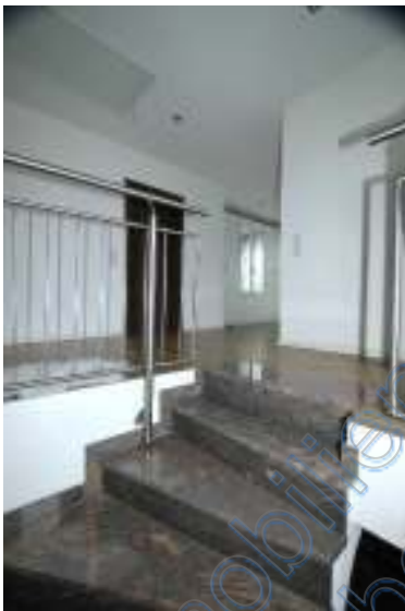
Treppenaufgang zum OG
