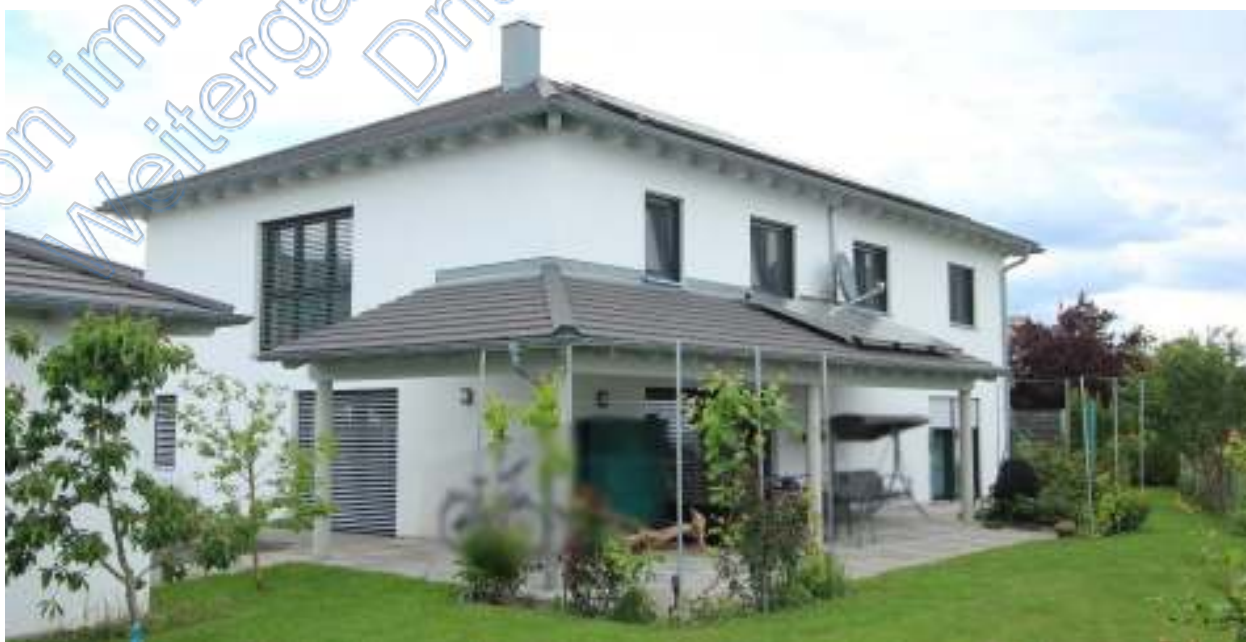
Wohnhaus mit überdachter Terrasse von Südwesten
