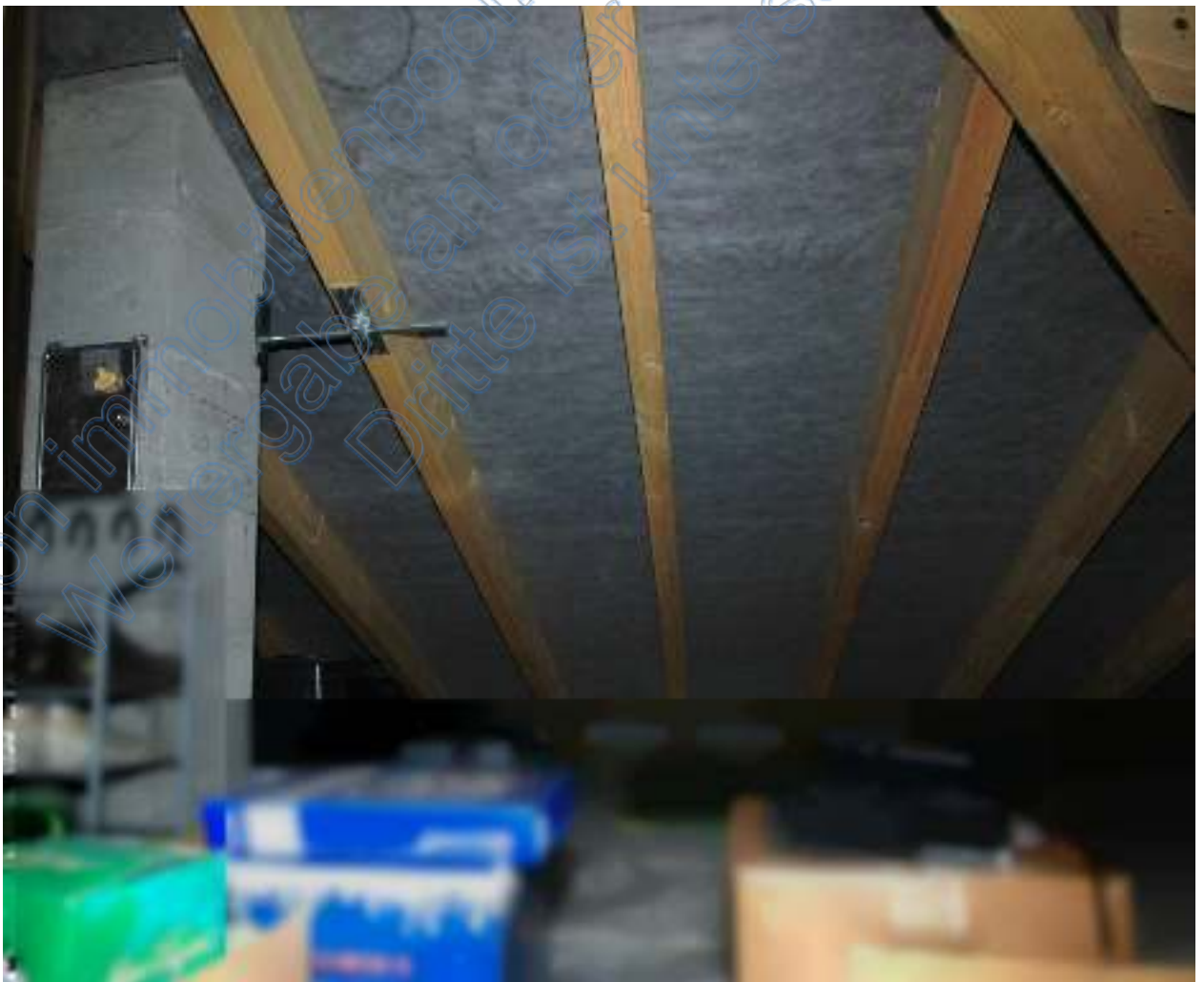
Bühne im Dachraum
