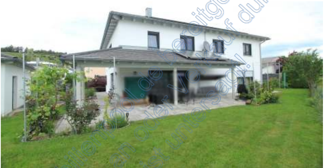
Wohnhaus mit überdachter Terrasse von Süden
