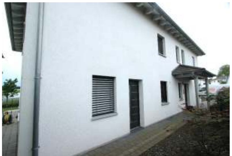
Nordseite Wohnhaus, rechts überdachter Hauseingang
