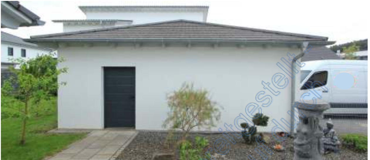
Ostseite der Doppelgarage
