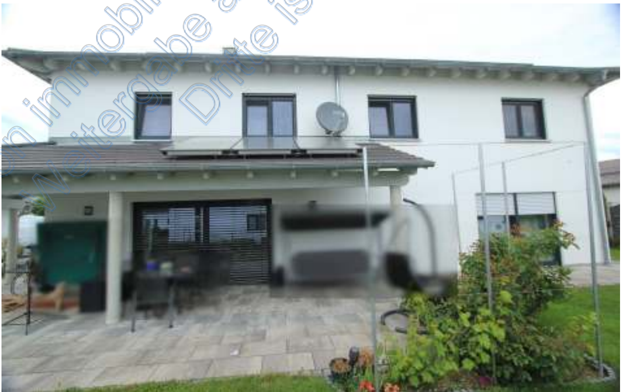
Südseite Wohnhaus mit überdachter Terrasse
