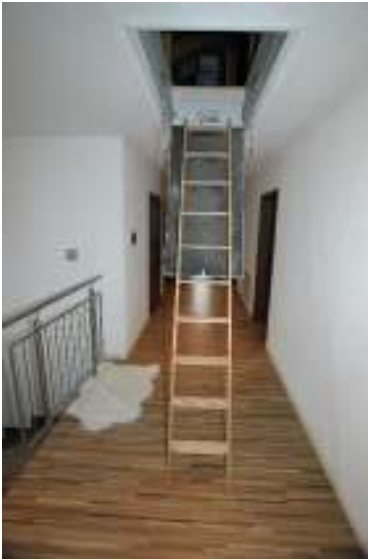
Bodentreppe zum Dachspitz
