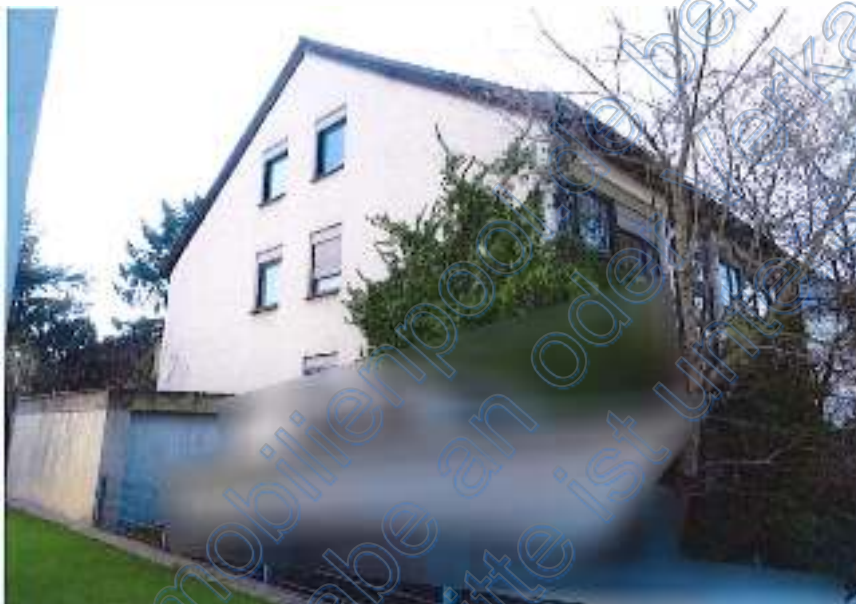
Foto 4: Ansicht Wohnhaus und Garage von der Straße aus
