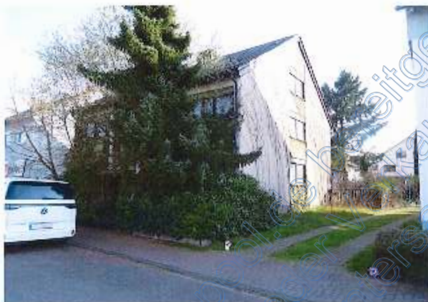
Foto 1: Ansicht von der Straße aus
