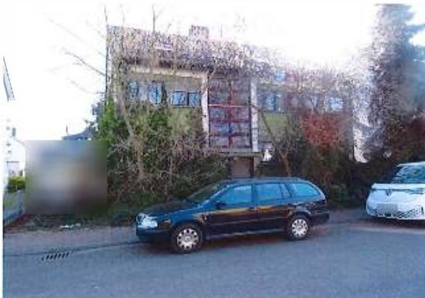
Foto 3: Ansicht von der Straße aus
