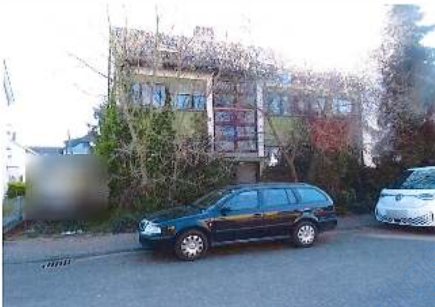
Foto 3: Ansicht von der Straße aus
