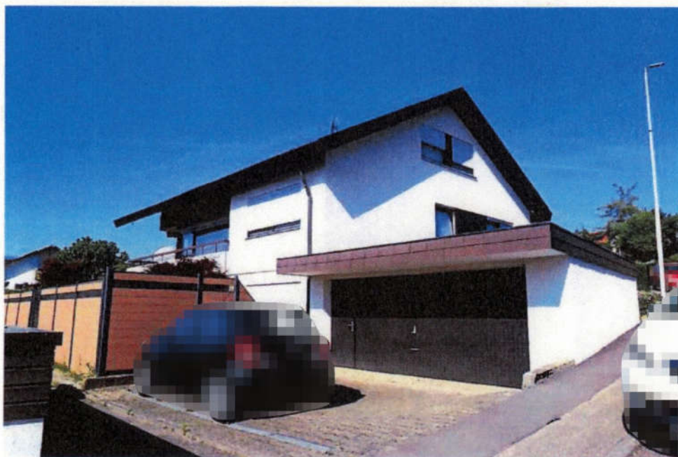
Ostansicht des Wohnhauses nebst Garage.
