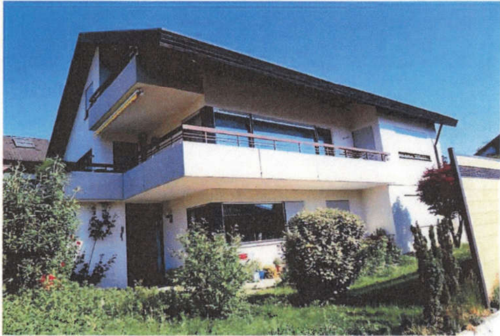
Blick auf das Wohnhaus mit Einliegerwohnung im Untergeschoss von Süden.
