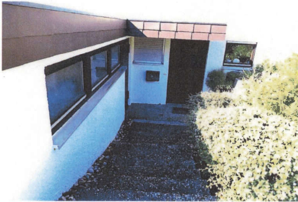
Blick auf den Zugang zur Einliegerwohnung im Untergeschoss.
