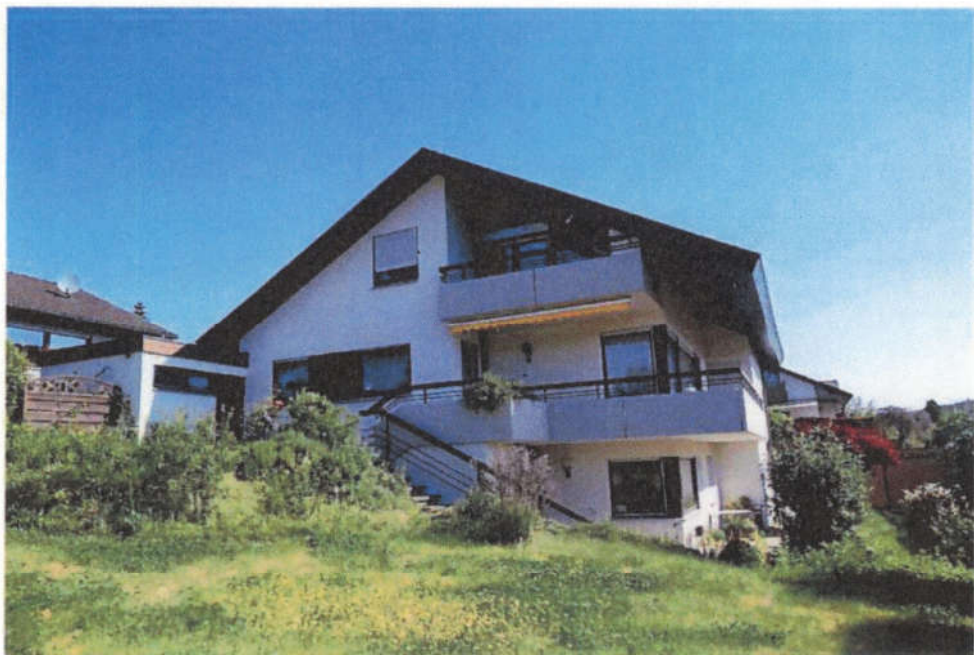
Seitenansicht des Wohngebäudes von Südwesten mit Garage (links).
