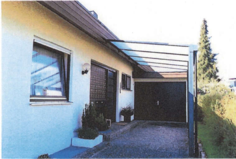
Blick auf den Wohnhauszugang mit Zufahrt/Zugang zur Garage.
