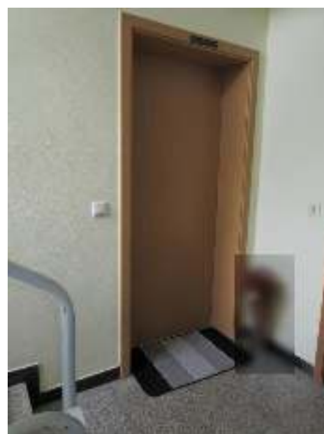
Abschlussstür der Wohnung Nr. 30
