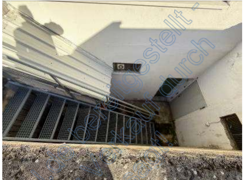
Foto 5 des SV: Ansicht von Südwesten; Kellertreppe
