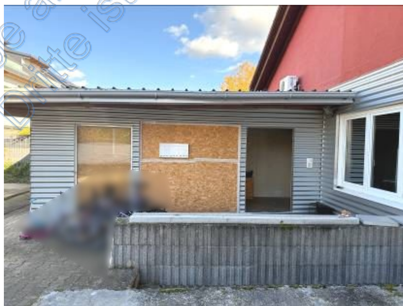
Foto 8 des SV: Eingangs-Einhausung/Anbau
