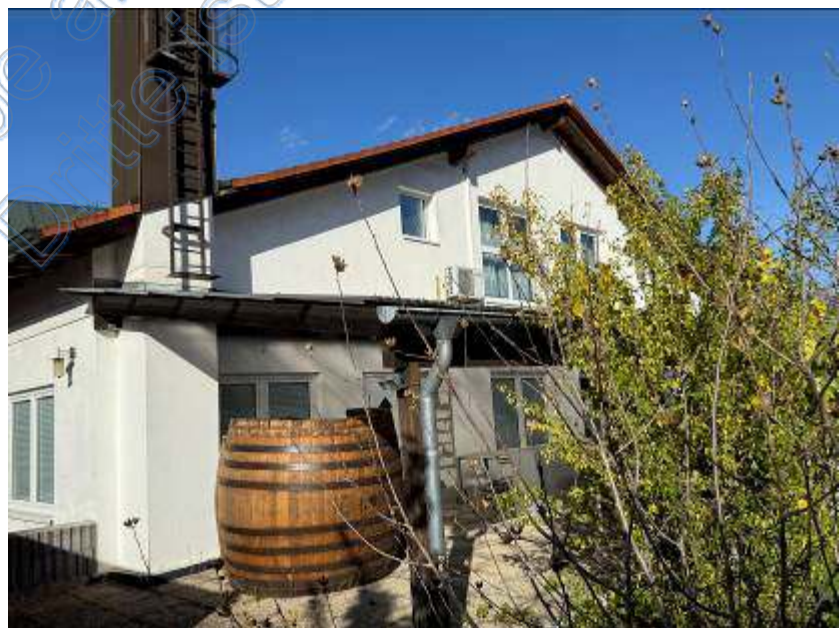
Foto 6 des SV: Ansicht von Süden, Gebäuderückseite
