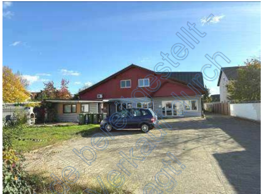
Foto 1 des SV: Anwesen Sauerbruchstraße 3; Ansicht von Nordwesten, Straßenansicht
