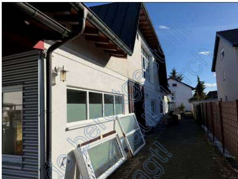
Foto 3 des SV: Ansicht von Westen
