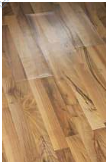
Schäden am Laminatboden
