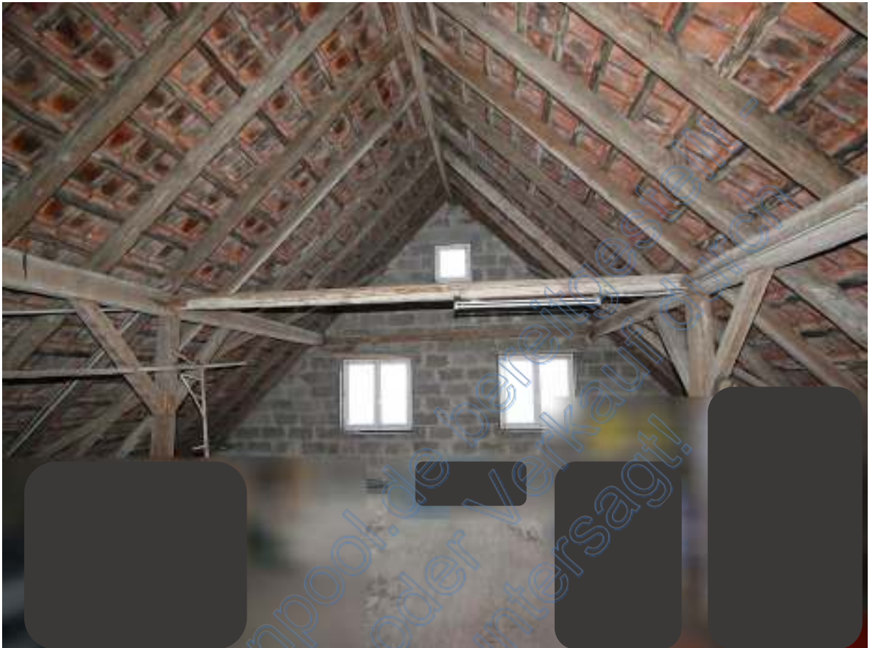
Bühne im DG ohne Zwischendecke zum Dachspitz, Blick zur Westgiebelwand
