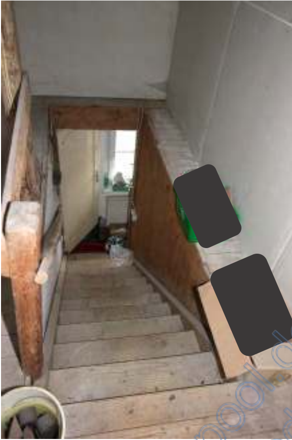
Treppe vom OG zum DG
