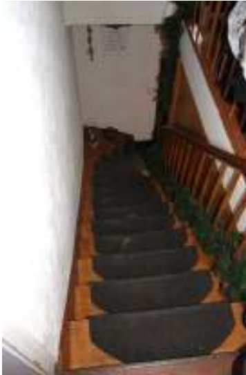
Treppenabgang zum EG
