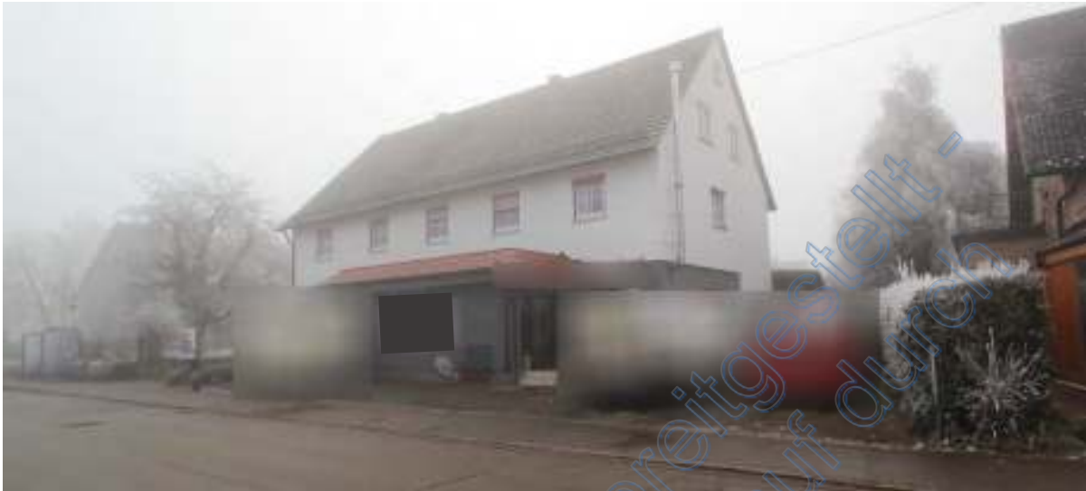
Grundstück mit Wohn/Geschäftshaus von Nordwesten
