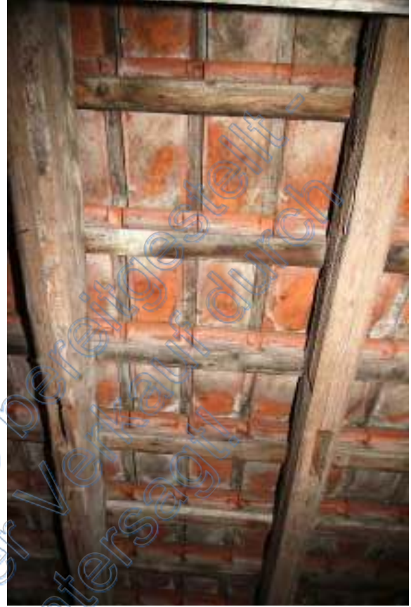
Alte Dachziegeldeckung im DG
