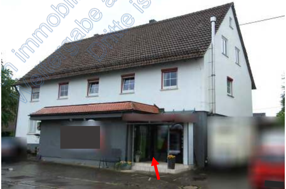
Wohn/Geschäftshaus von Nordwesten, Pfeil überdachter Ladeneingang
