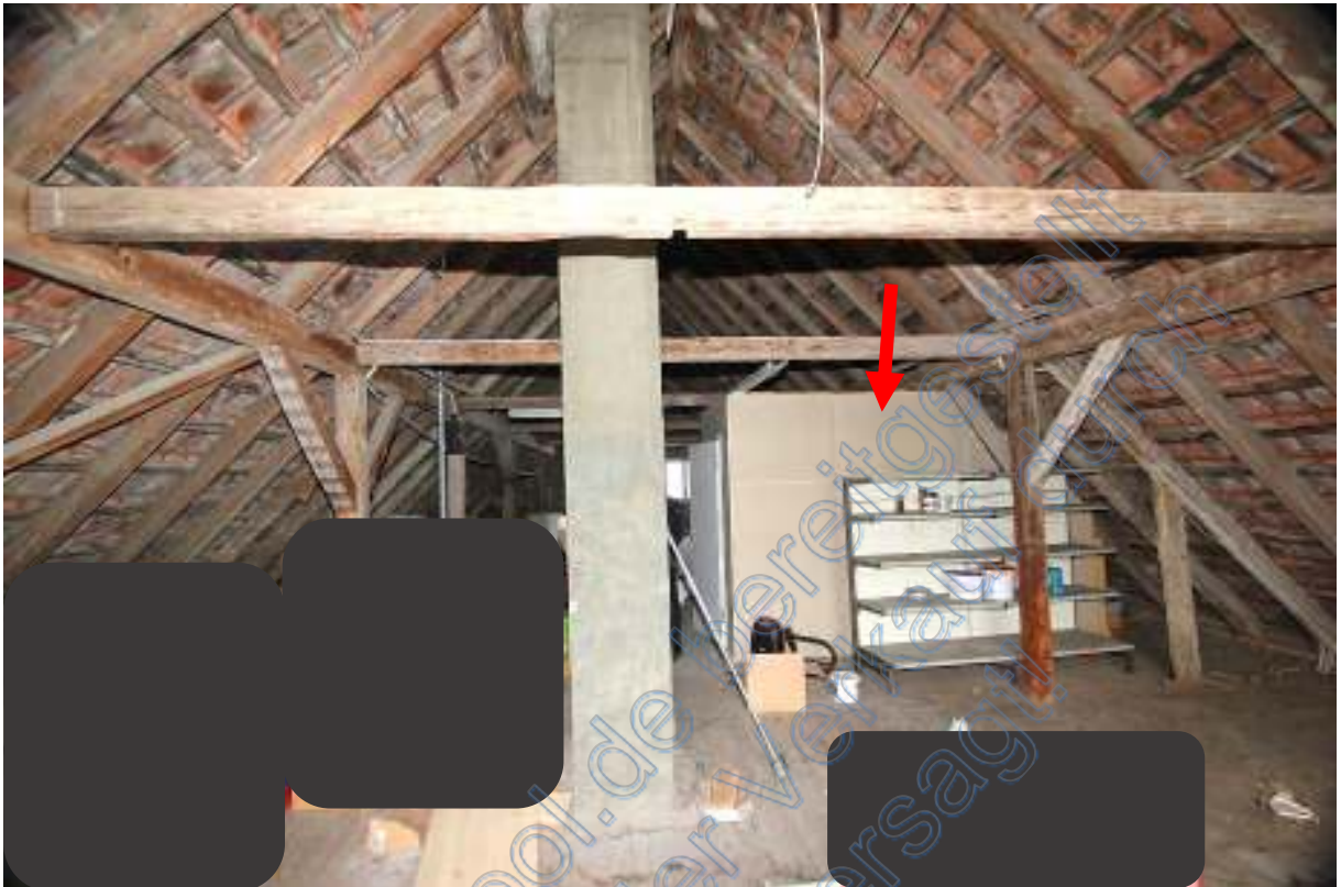
Bühne im DG ohne Zwischendecke zum Dachspitz, Pfeil Treppenabgang
