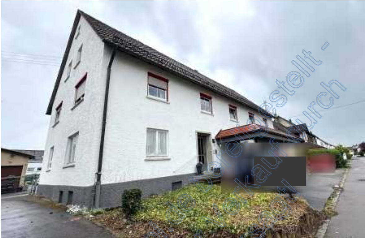
Wohn/Geschäftshaus mit Ladenraumbau von Nordosten
