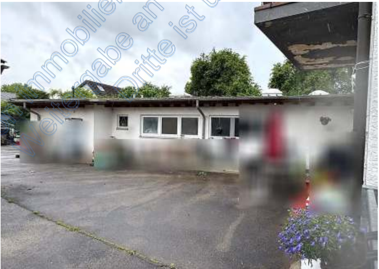
Hof im Süden mit Ostseite Metzgereianbau
