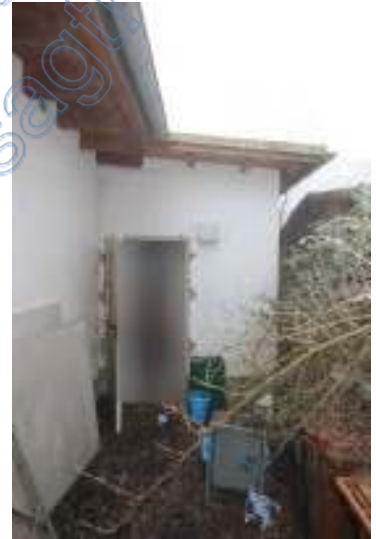
Ostseite hinterer Metzgerei Anbau mit Türen und Außenflächen
