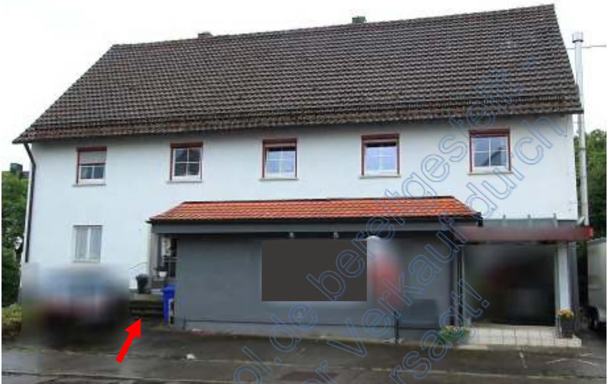
Nordseite Wohn/Geschäftshaus mit Ladenraumanbau, links davon Hauszugang
