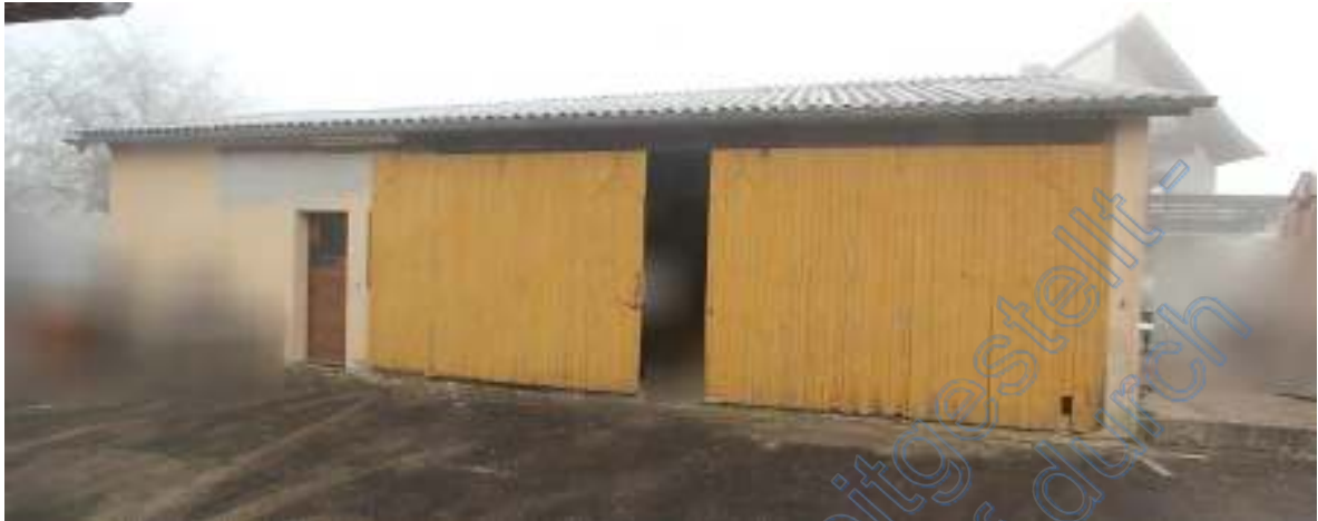
Westseite Garagen/Lagergebäude mit 2 Holzschiebetoren
