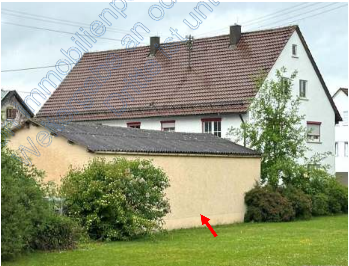
Wohn/Geschäftshaus und Garagen/Lagergebäude von Südosten
