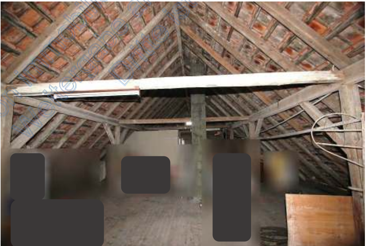
Bühne im DG, offen bis in den Dachspitz, Blick nach Osten
