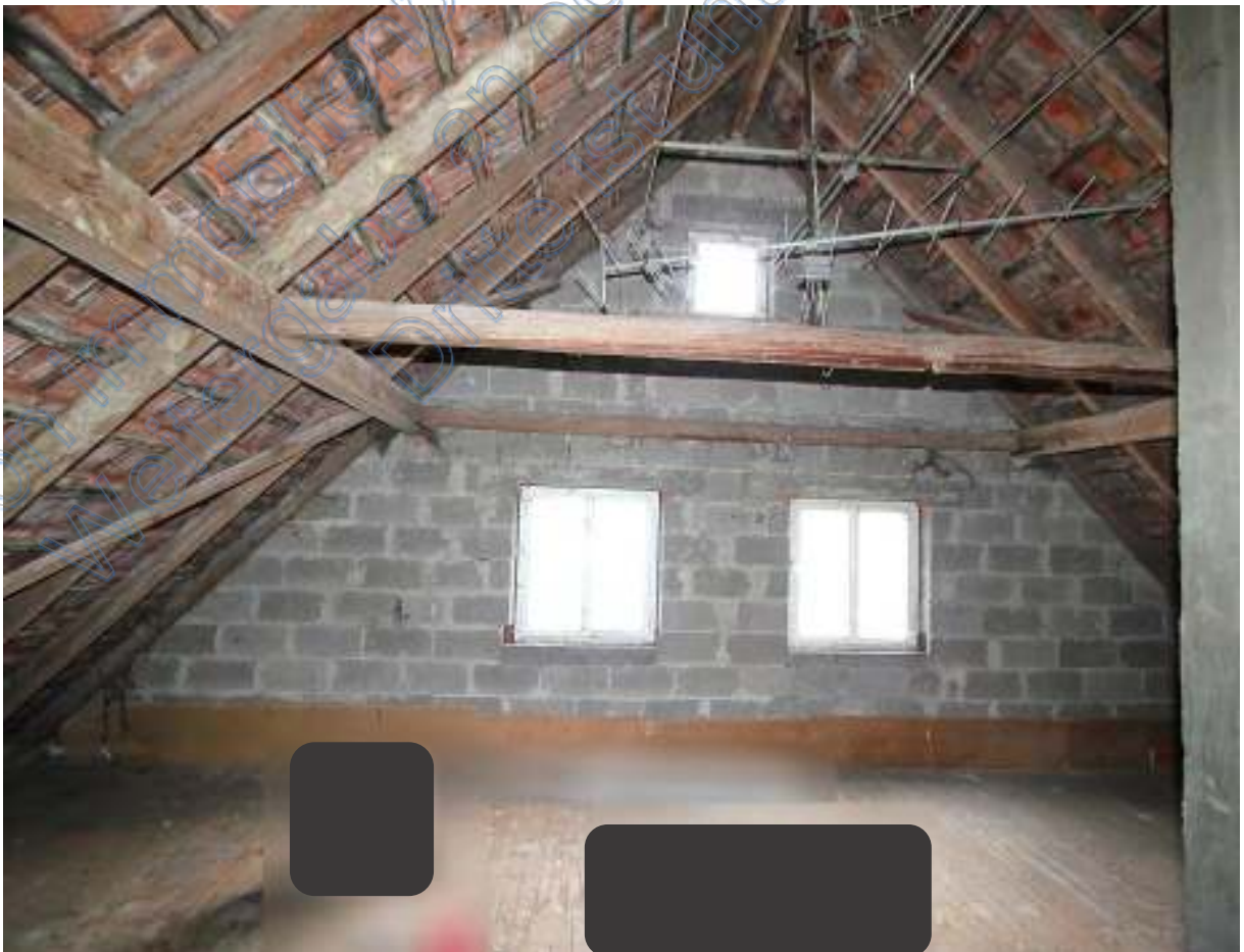
Bühne im DG ohne Zwischendecke zum Dachspitz, Blick zur Ostgiebelwand
