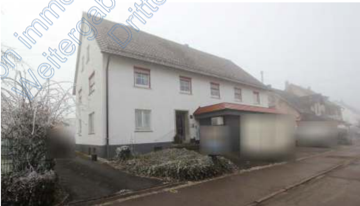
Grundstück mit Wohn/Geschäftshaus und Ladenanbau von Nordosten
