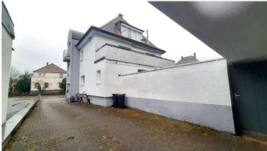
Bild 13: Teilansicht Gebäuderückseite (von Garagentor aus)
