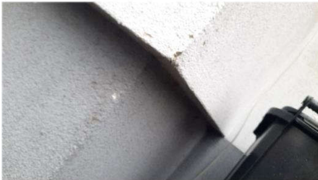
Bild 14: Wärmedämmverbundsystem an Umfassungswänden (nach Augenschein)
