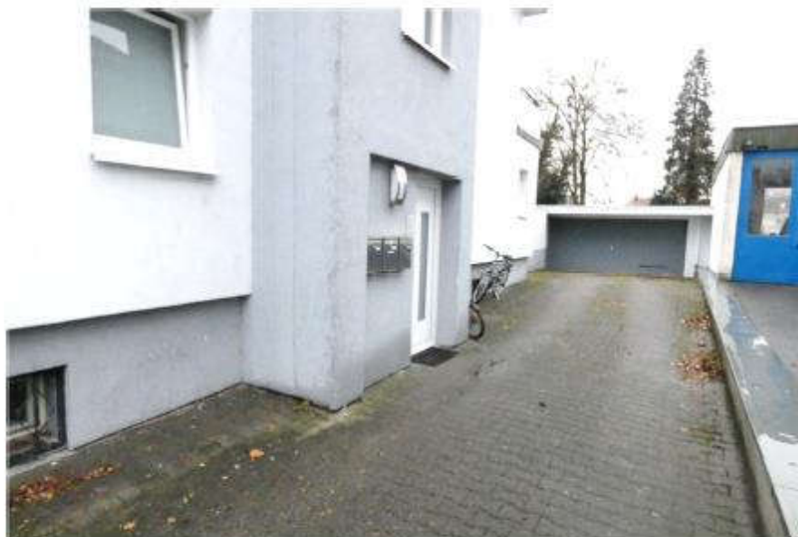
Bild 8: Hauseingang Nordostseite und Garagenzufahrt
