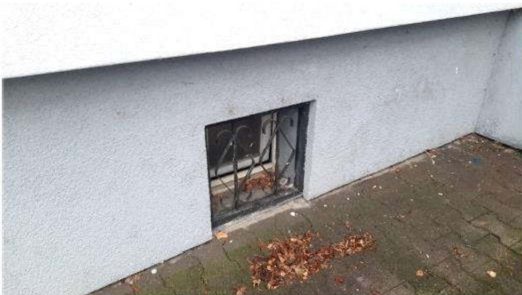
Bild 16: Kellerfenster im Sockelbereich zum Hof
