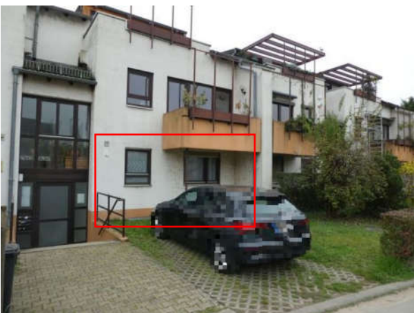
Haus Nr. 15 | Westansicht Markierung zeigt Lage der Wohnung Nr. 52
