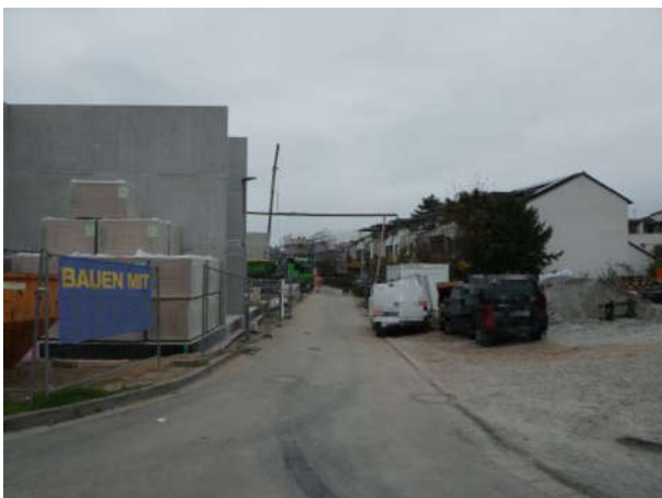
Straße „An der Neckarspitze“ in Richtung Norden
