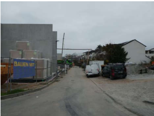
Straße An der Neckarspitze in Richtung Norden
