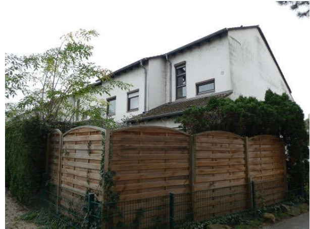
Nordostansicht Gebäude Typ B
